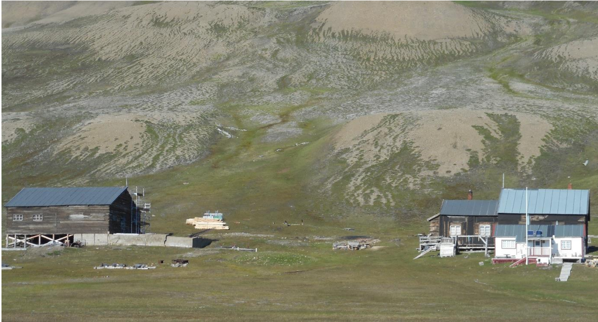
Figur 82: Flyvraket på Hiorthhamn ligger i skråningen bak bebyggelsen i den fredete gruvebyen. Deler av vraket er synlig omtrent midt i bildet. Foto: NIKU/AC Flyen
