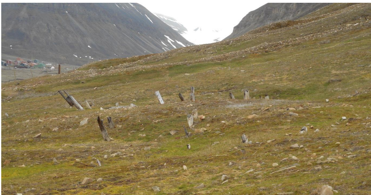
Figur 51: I området rundt Tuft D er det svært fuktig. Dette påvirker tuften, og flere av pelene sto i vann. Foto: NIKU/AC Flyen
