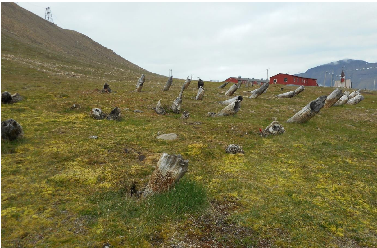
Figur 43: Tuft C består av et midtparti med relativt høye og kraftige pelers. Mot nord og syd er det derimot mindre pelers med større avstand. Mot syd og vest står pelene i våte områder. Foto: NIKU/AC Flyen
