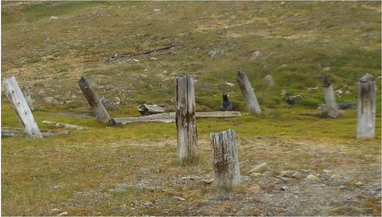
Figur 54: Pelene i bakkant på bildet står svært fuktig. Foto: NIKU/AC Flyen
