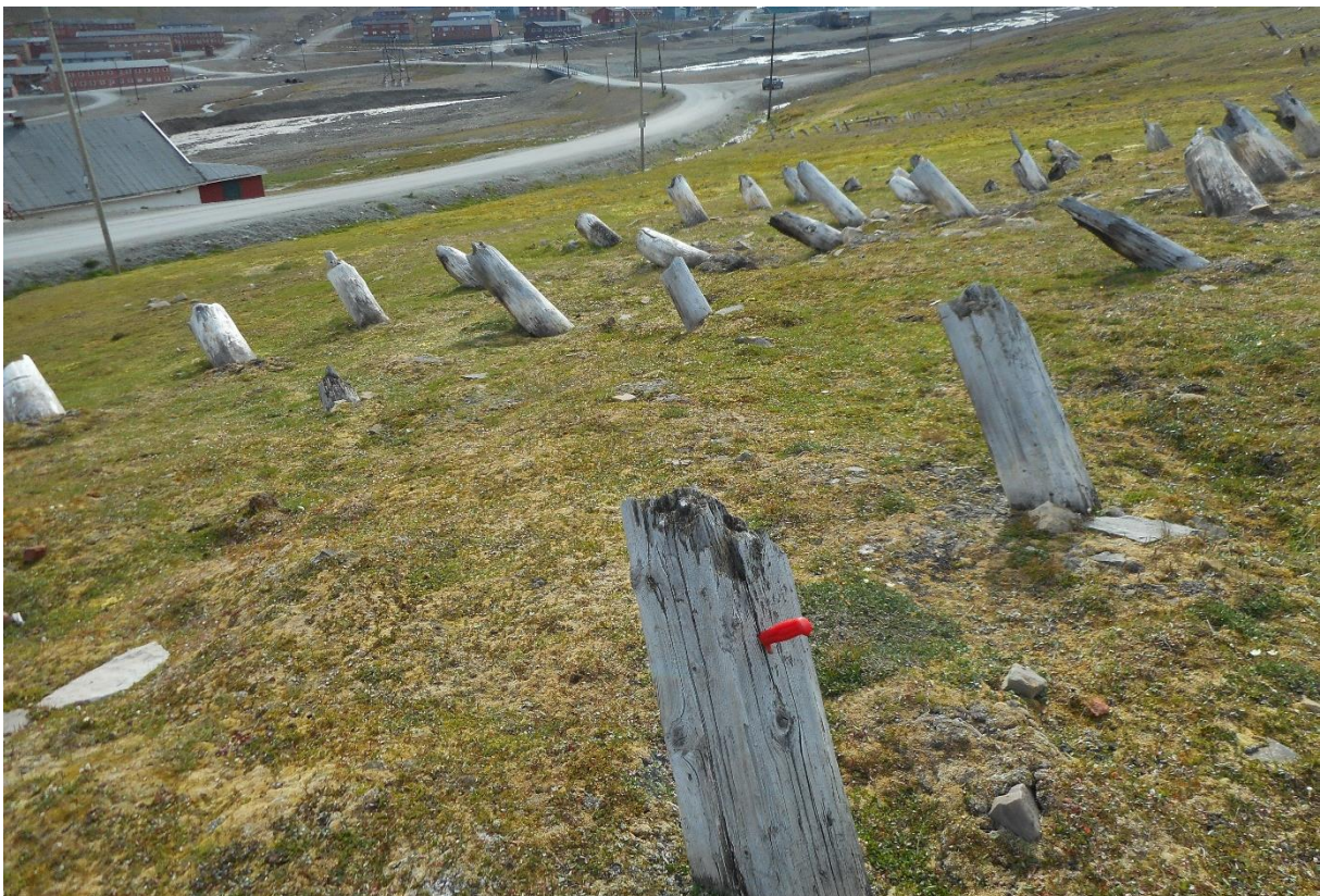
Figur 47: Pelene i tuft C sett fra nordvest. Kniven viser en av de tre pelene i denne tuften der det ble gjort enkel råteundersøkelse med en knivspiss. Foto: NIKU/AC Flyen
