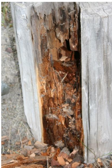
Figur 13: Til venstre: Slik ser en pele ut inni etter angrep av husnettsopp. Dette er en gammel skade. Råtesoppen har brutt ned treverket fra innsiden og utover. Til høyre: Undersøkelsene av råte inne i pelene ble gjennomført ved at en knivspiss ble ført forsiktig inn i en eksisterende sprekk i pelen. Foto: NIKU/AC Flyen
