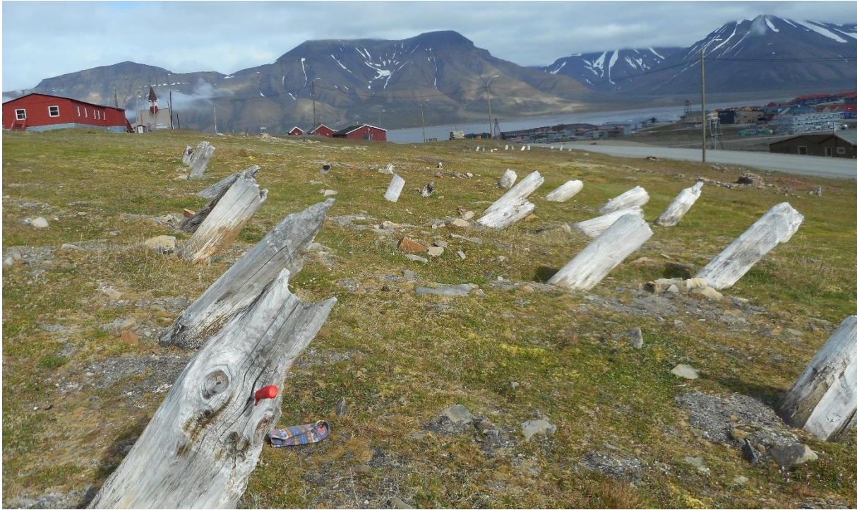
Figur 46: Pelene i tuft C sett fra sudvest. Råteundersøkelsene ble gjort med en knivspiss i eksisterende sprekker i treverket. Kniven (rød) er synlig i pelen nederst til venstre i bildet. Foto: NIKU/AC Flyen
