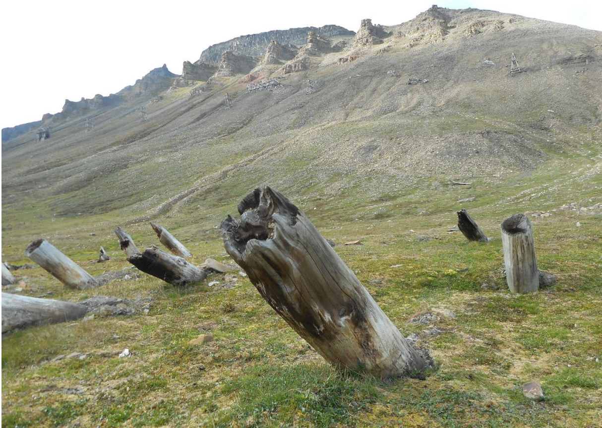
Figur 11: Jordsig. Om sommeren tiner det øverste laget i jordmassene. Den delen som tiner opp kalles det aktive laget. Under ligger permafrosten. Selv i slake skråninger kan de tinte jordmassene begynne å sige. Dette bildet viser hvordan jordmassene dytter på pelene slik at de til slutt kan ligge helt nede på bakken. Foto: NIKU/AC Flyen
