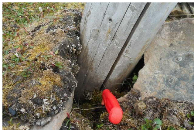
Figur 13: Til venstre: Slik ser en pele ut inni etter angrep av husnettsopp. Dette er en gammel skade. Råtesoppen har brutt ned treverket fra innsiden og utover. Til høyre: Undersøkelsene av råte inne i pelene ble gjennomført ved at en knivspiss ble ført forsiktig inn i en eksisterende sprekk i pelen. Foto: NIKU/AC Flyen
