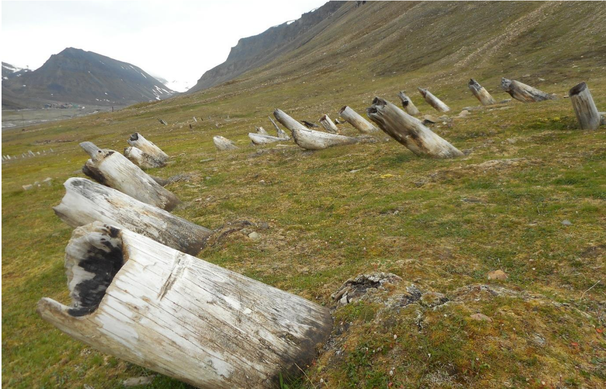
Figur 44: Pelene i tuft C sett fra nord. De er tydelig dyttet av jordmassene, og enkelte ligger helt nede på bakken. Inni er pelene kraftig brutt ned av råte. Det er også tydelige spor etter brannen i 1943 i toppen av pelene. Foto: NIKU/AC Flyen
