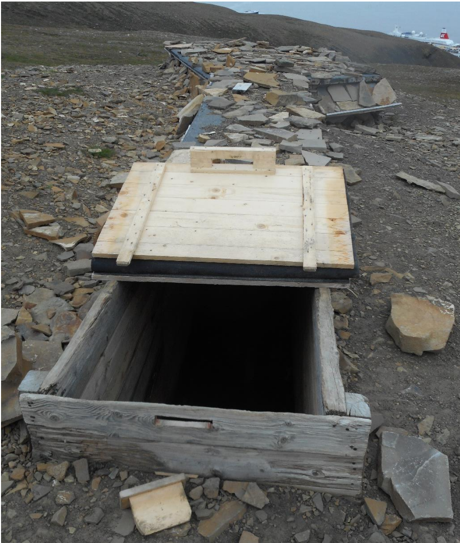
Figur 66: Nedgangen til kommandoplassen i enden av gangen. Takluken er rekonstruert i sin helhet. Så mye som mulig er beholdt av gammelt trevirke. Taket fikk ny papp (tekking) i 2007. Foto: NIKU/AC Flyen.
