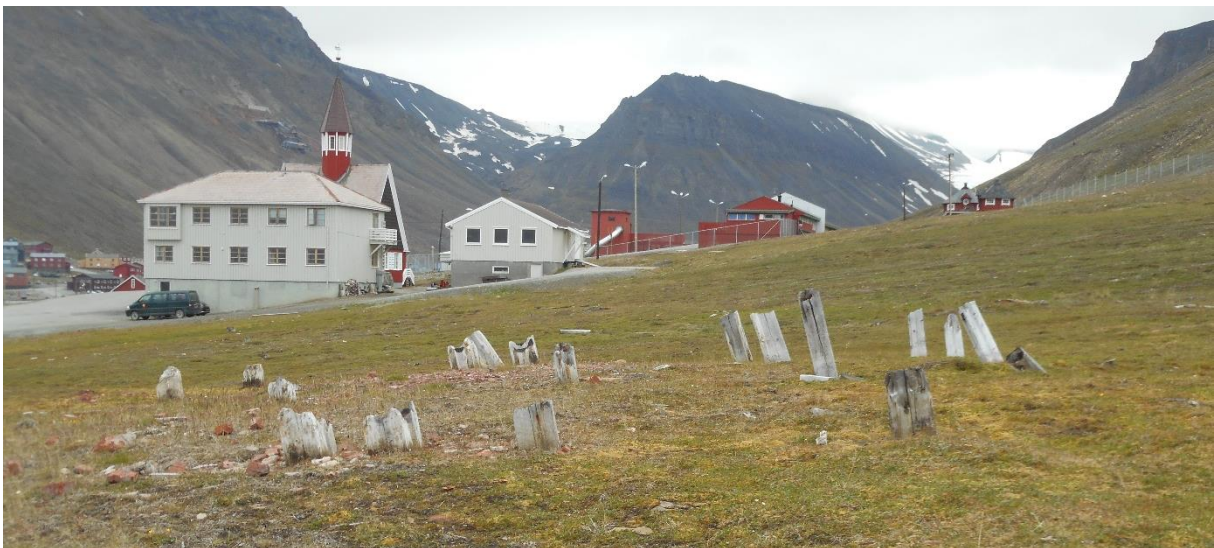
Figur 24: I forgrunnen en tuft med fundamentpelene i Gamle Longyearbyen. I bakgrunnen sees Svalbard kirke (med rødt klokketårn) og Longyearbyen barnehage (rød). Restene etter Gamle Longyearbyen fortsetter på den andre siden av kirken. Tuften består av peler og rester av teglstein. Foto: NIKU/AC Flyen
