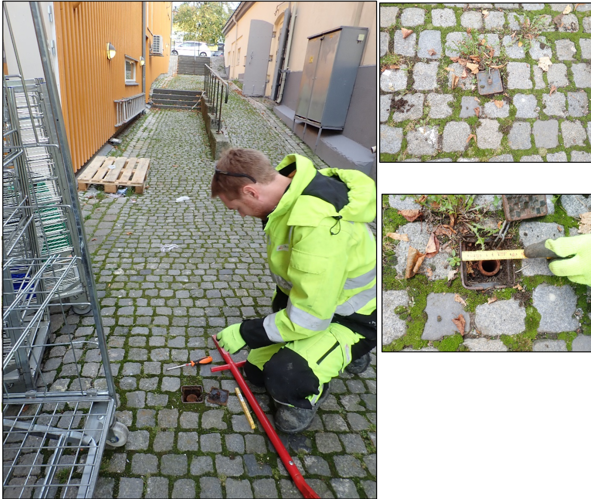
Figur 16. Piezometerbrønn TO-2a, Nedre Langgate 40, Tønsberg. Foto VVM/NIKU.
