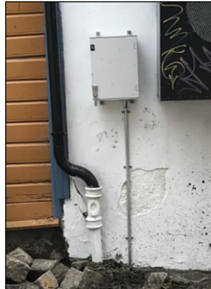
d) Ferdig montert installasjon
