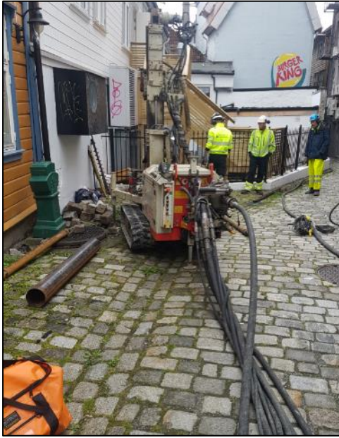
a) Borerigg og sensorinstallasjon
