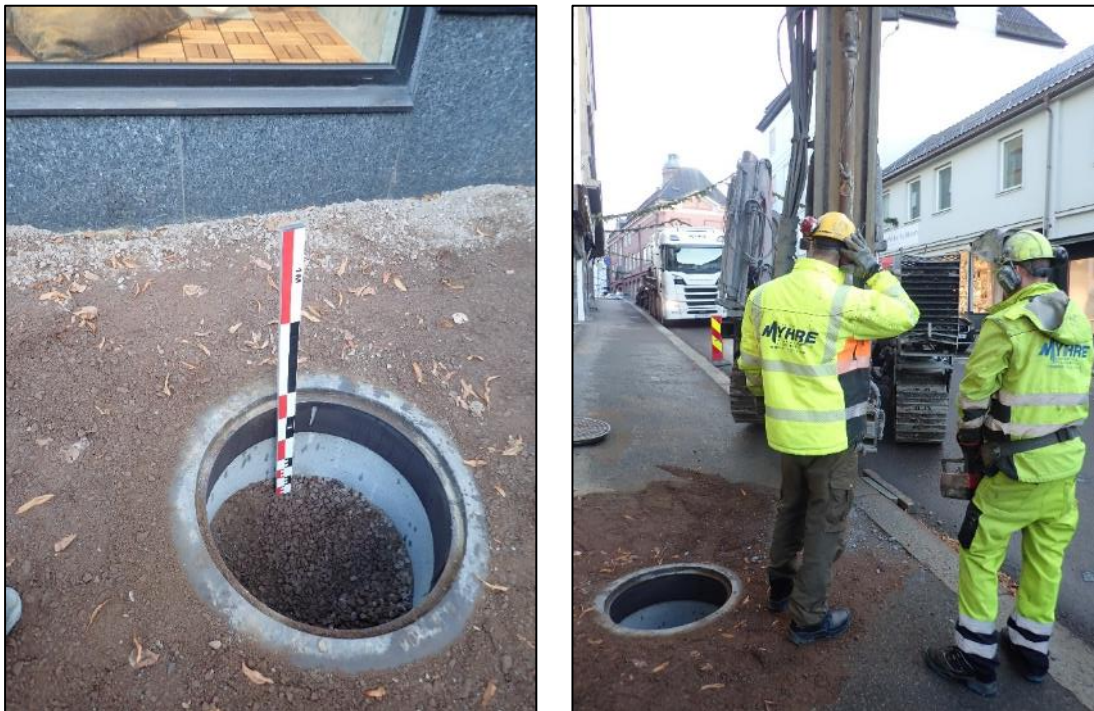
Figur 13. Bilder fra feltarbeidet før oppstart av boringen av miljøbrønn TO1. Tv.: Forhåndsinstallert kum. Th.: Boreriggen klargjøres.
