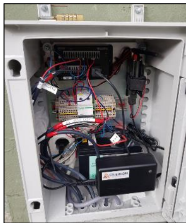
g) Ferdig montert skap på veggen
