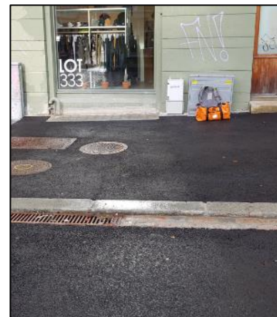
h) Ferdigstilt installasjon
