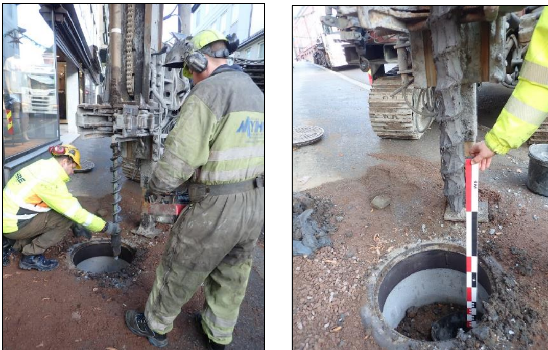
Figur 14 Bilder fra felt ved boring av miljøbrønn TO1. Tv.: Rensing av bor. Th.: Siste borelengde ved påtruffet grunnfjell.
