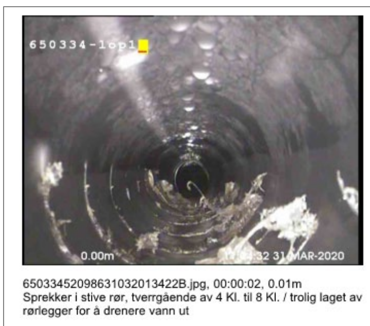
Figur 13. Inspeksjon av I/T ledning. Vitek AS
