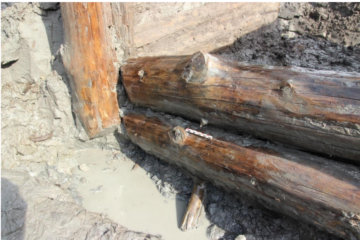
Figur 109. Detalj av de diagonalt stille veggstokkene i sørveggen som viser hvordan en grein i den nederste stokken er kjørt ned og festet i leiregrunnen. Foto mot nordvest (Cf34987_NIKU_1713).
