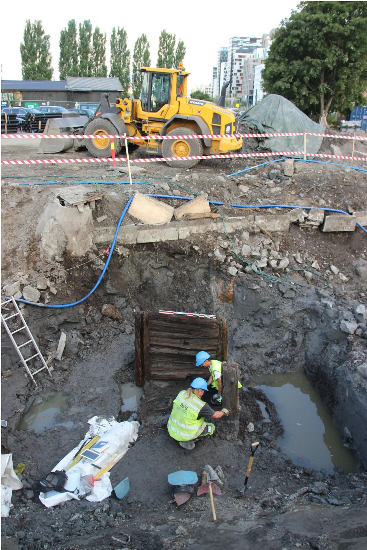
Figur 106. Brønn SA5626: Stefan Bakke og Øystein Dahle graver ut bunnlaget i sleppsverksbrønnen fra rundt 1200, med Barcode-rekken kneisende i bakgrunnen. Foto mot vest (Cf34987_NIKU_1741.).
