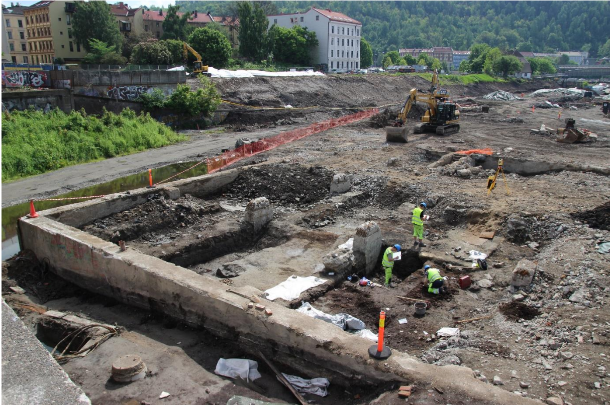
Figur 123. Utgravning av middelalderiske kulturlag under fundamentsålen til bygningen Borgen. Foto tatt fra Bispegata mot sørøst (Cf34987_NIKU_0438).
