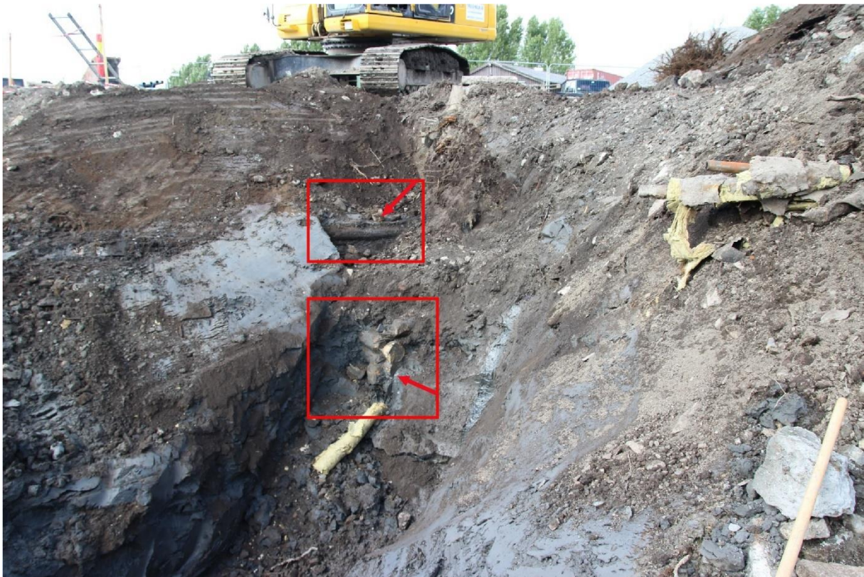
Figur 118. Laftekonstruksjon SA7207, markert med røde piler, rett etter at den ble påtruffet av gravemaskinen i grensen til tiltaksområdet. Foto mot vest (Cf34987_NIKU_1880).
