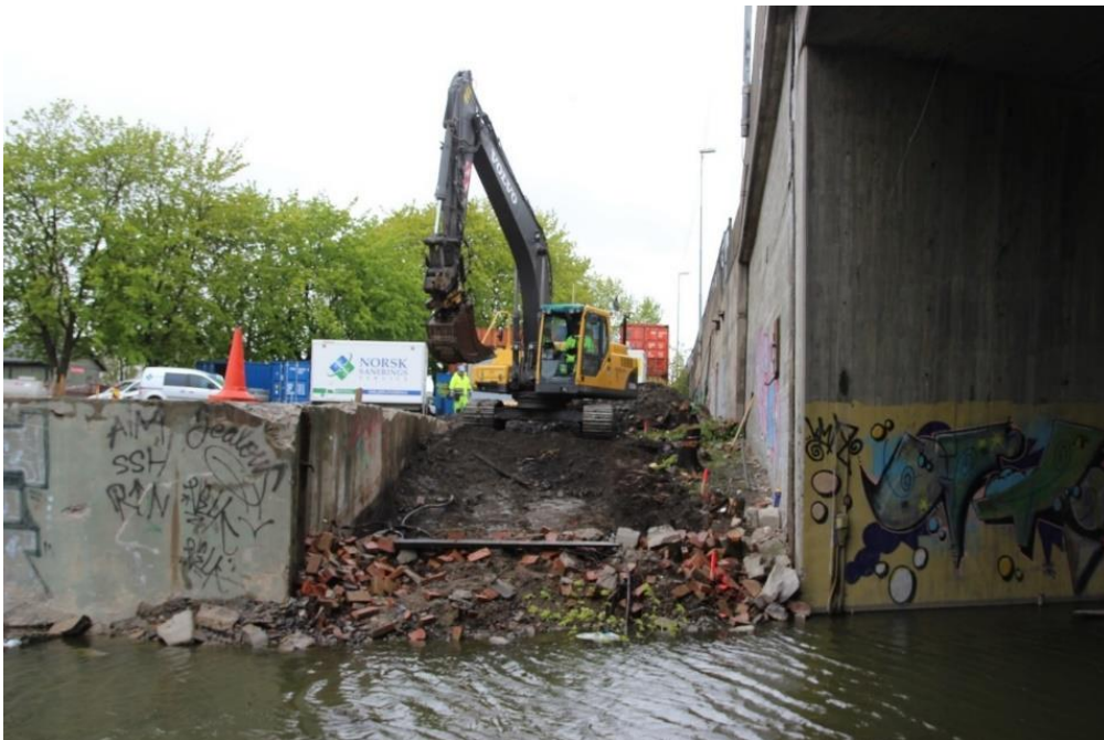
Figur 74. Gravemaskinen står mellom grunnmuren til Borgen og Bispegata bro. Ved fremrensing av dette mellompartiet var det store vannmengder i Klypenskjæringen. Bygningsrestene fra middelalderen ble avdekket rett i etterkant av at bildet ble tatt. Foto mot vest (Cf34987_NIKU_0209).
