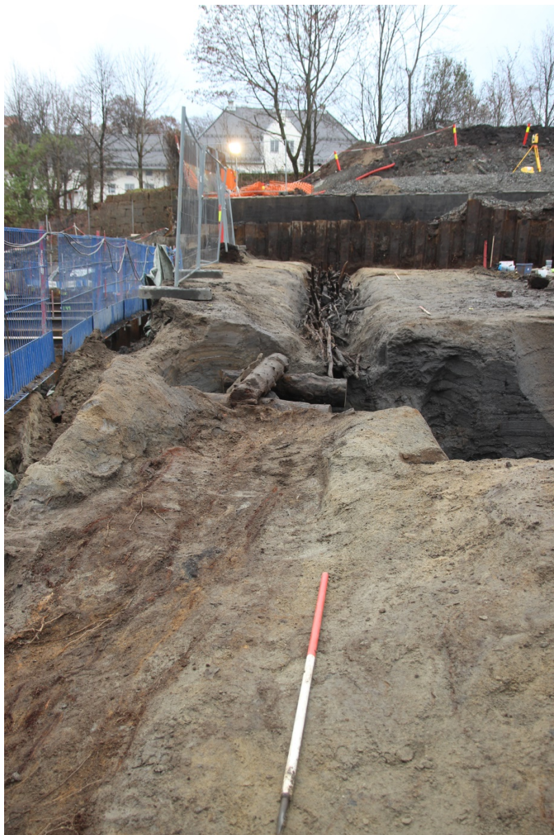
Figur 46: SA150 sett mot øst. Man ser tydelig hvordan bevaringsforholdene er vesentlig forverret vest for cisterne SA160. Foto: Cf35155_NIKU_1322.
