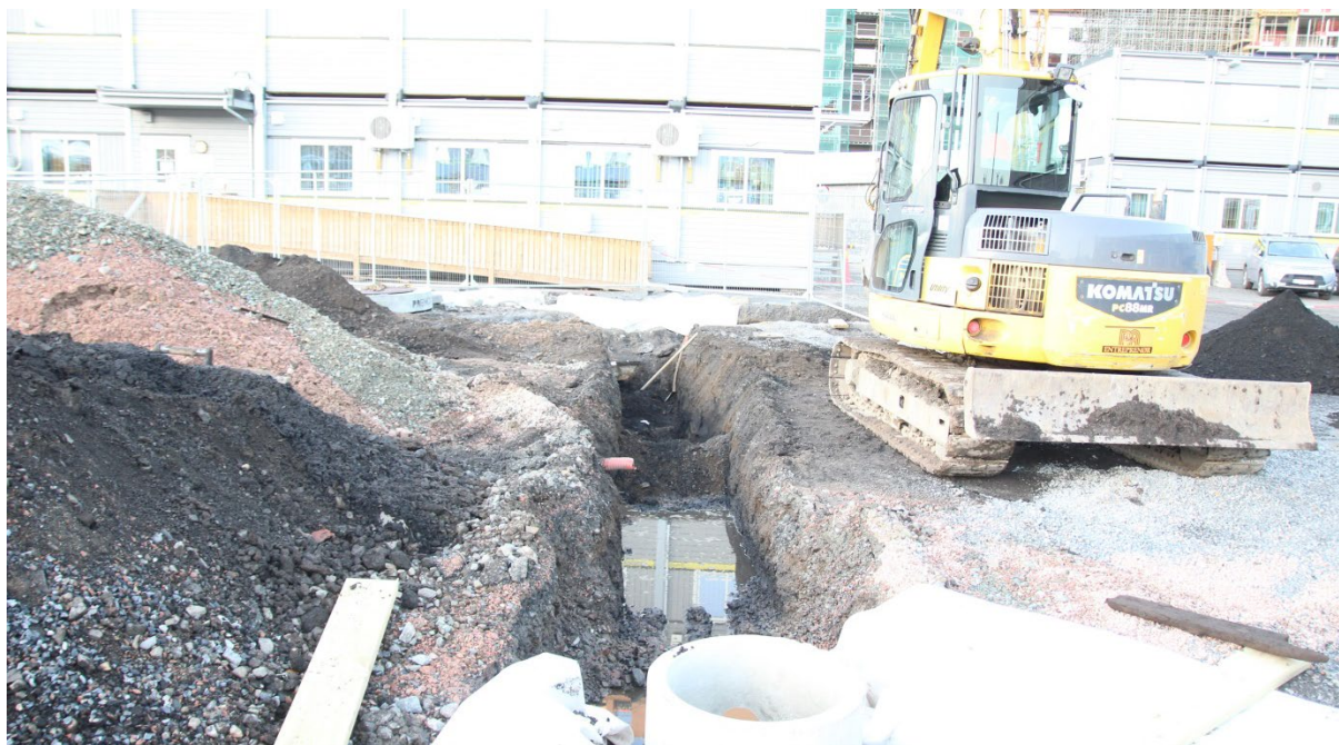
Figur 104: Øst-vest-orientert grøft, sett mot vest. Foto: Cf35155_NIKU_1397.
