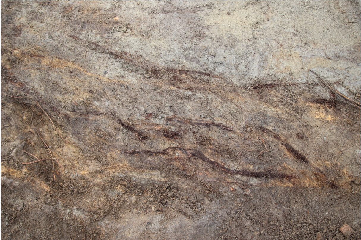
Figur 23: Spor etter flettverksgjerder som har gitt næring til røtter fra vegetasjon i nyere tid. Sett mot sør. Foto: Cf35155_NIKU_10285.
