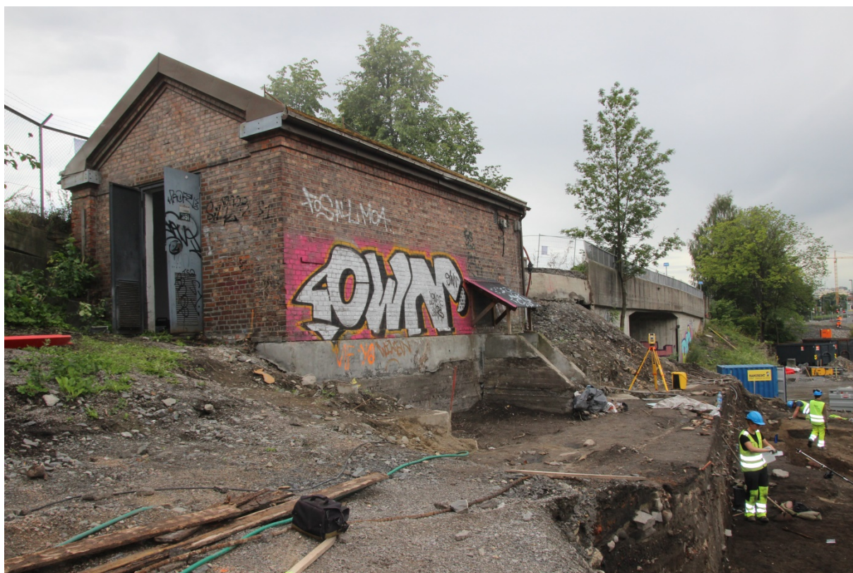
Figur 13: Mangel på flytting av trafostasjonen nord for Bispegata førte til at NIKU måtte vike fra prinsippet om å grave stratigrafisk i hele utgravningsområdet. Sett mot sørøst. Foto: CF35155_NIKU_0205.
