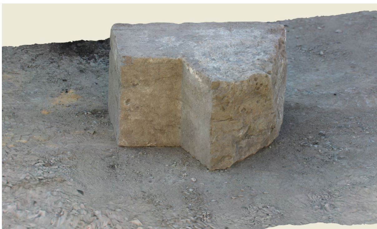
Figur 89: Stein SS2242 med vertikalhugde visflater. Foto: Cf35155_NIKU_2344.
