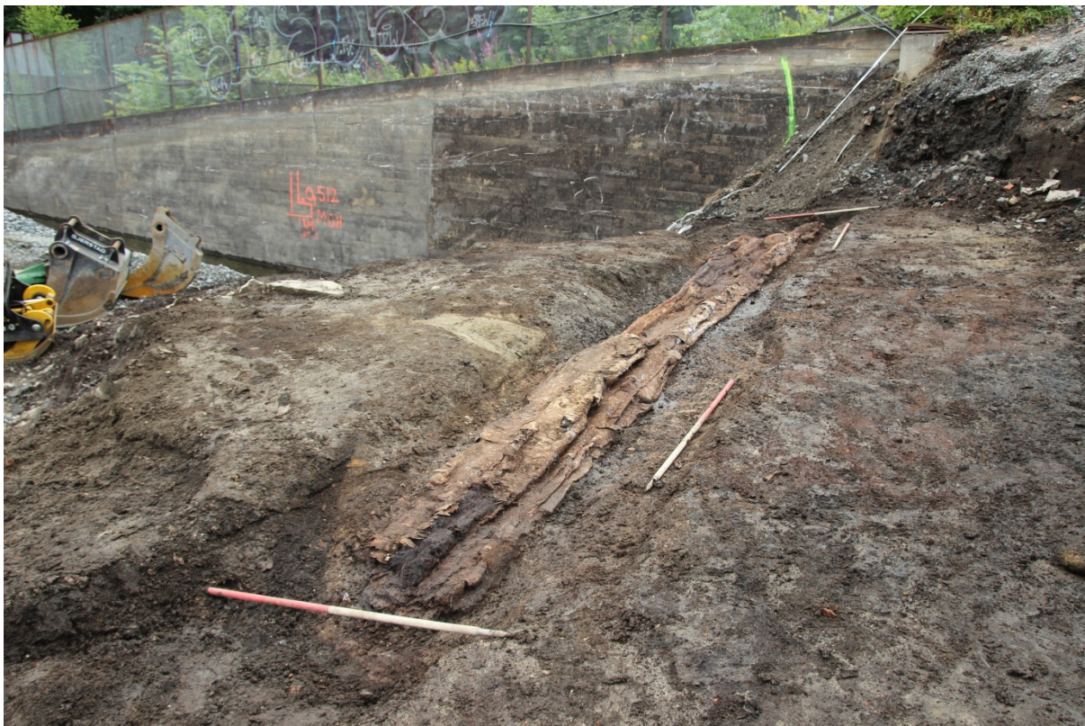
Figur 51: Avløpsrør SA1281 sett mot nordøst. Foto: Cf35155_NIKU_0246.
