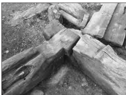
Foto 3. Bygn. 177 in situ, NV-hjørne sett fra SØ Foto: Ark. inst., UIB
