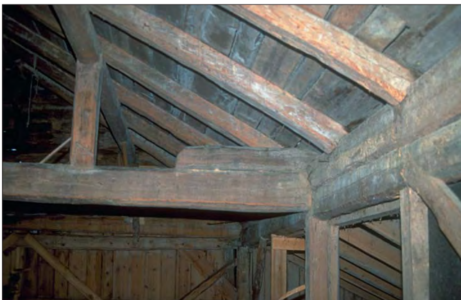
Figur 10. Detalj av bukkehus-konstruksjonen i lœa på Grønnes, med dobbel bete og dobbel raftlœgje, og med raftlœgja plassert sentrisk over staven. Foto: CAS
