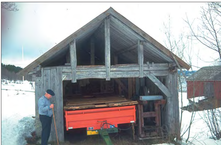
Figur 11. Båtskjå på Grønnes i Molde kommune. Bukkehus-konstruksjon, der taksperrene er understøttet av mœnsås, sideœser og œsstaver festet i reksponspor i den doble beten. Foto: CAS
