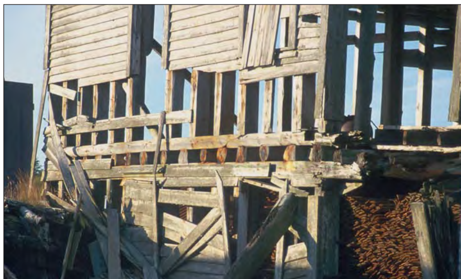
Figur 3. Bindingsverksvegg, ca. 1880. Vibrandsøy i Haugesund. Foto: HS
