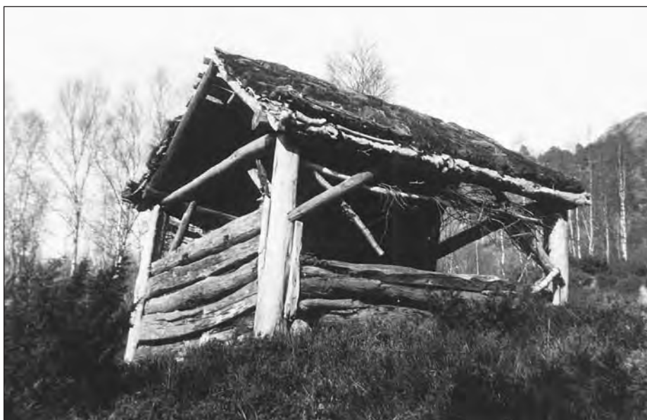
Figur 17. Utlæ med slepverksvegger «laveger». Espedal, Forsand i Ryfylke. Foto: G. Mikkelsen.
