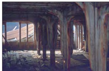
Figur 5. Avstivning med krumvokste knær. Vibrandsøy i Haugesund. Foto: HS
