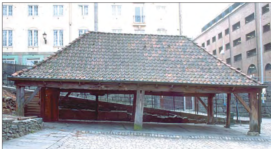
Figur 14. Stolpebod i «stavlinekonstruksjon», Bryggen i Bergen. Foto: A.Steindal
