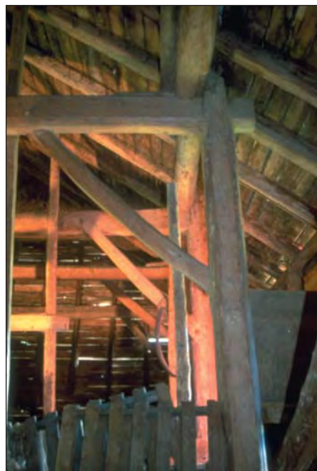
Grindbygd løe på Svantesvoll, Vindafjord kommune. Foto: HS
