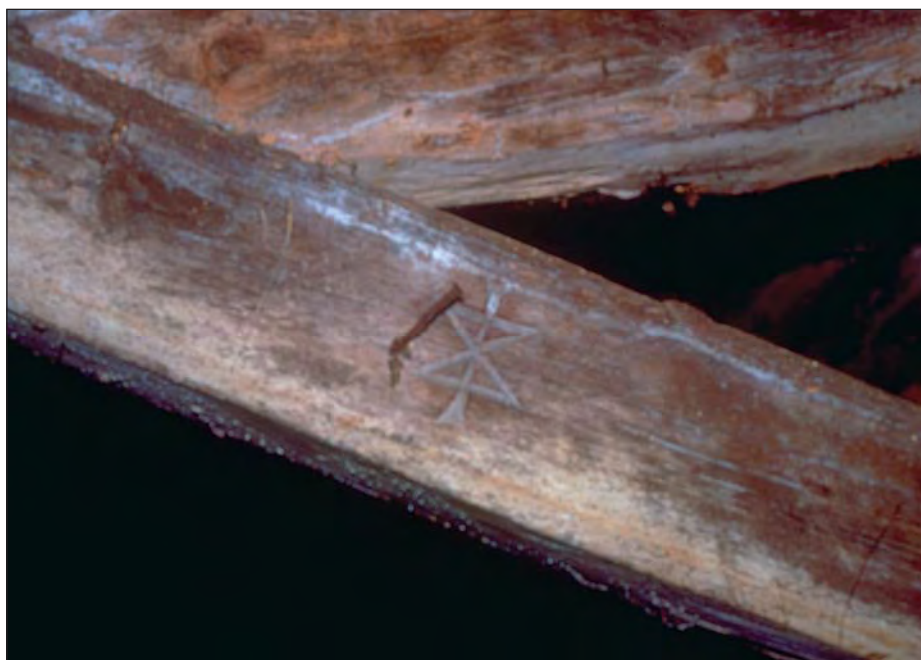
Figur 7: (Under) Løe frå Titland i Lindås. Merke av same type som på garnhengja frå Moldegård i Os. Flyttemerke eller bumerke? Begge foto: Kjell Andresen.
