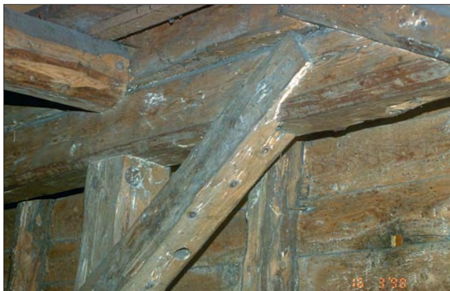
Figur 4. Fra interiøret på løa på Ålesund Museum. Et atypisk eksempel på nordmørske stavlinekonstruksjon på Sunnmøre. Et resultat av innvandret håndverker? Foto: Ragnar Albertsen, Fylkesfotoarkivet.
