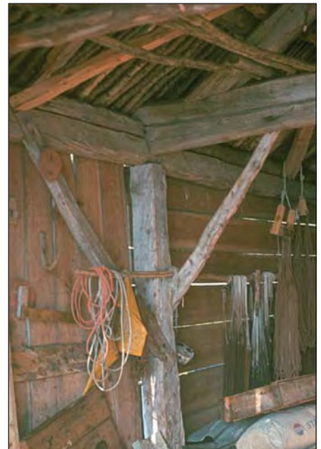
Figur 3. Naust Efjorden. Overgang vegg/tak. Foto: GJ
