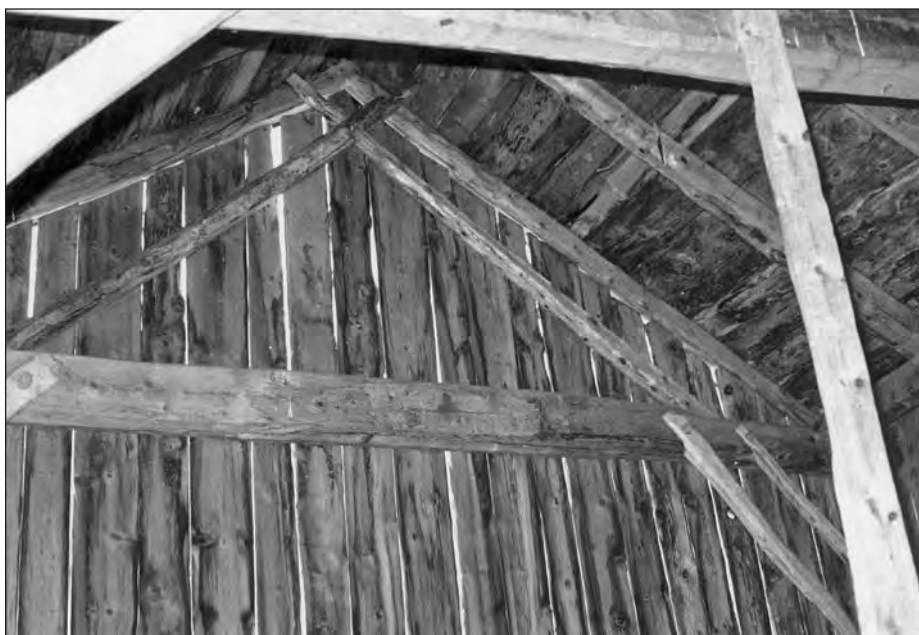
Figur 22. Gavlvegg i løe. Melheim, Eid i Nordfjord. Foto: PG.
