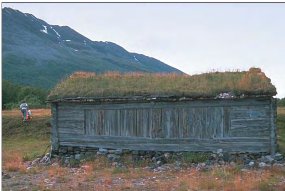
Figur 3. Skjelter (skjæltæl, skjaldtile) finst i Nord-Noreg både som fylling i tømmervegg og som fylling mellom stavar i skjåar og stavreiste naust. Foto: JBG.
