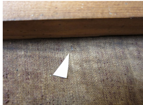
Foto 10: Detalj av et lite hull i lerretet.
