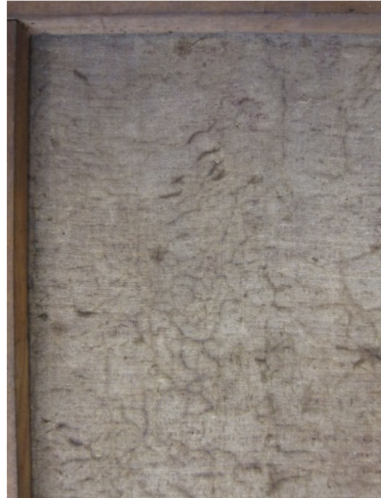
Foto 8: Detalj av baksiden som viser et mønster av malinglagets krakeleringer.
