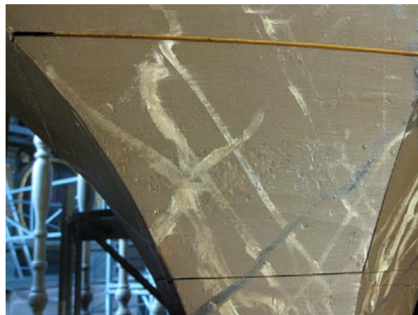
Foto 34: Skader på prekestolsløken etter konsolidering og retusjering.
