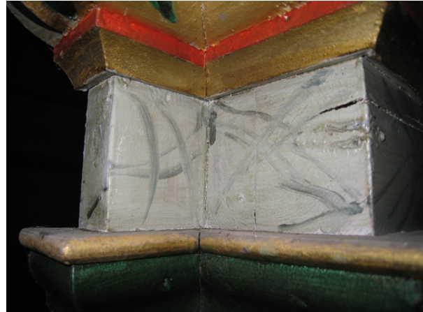
Foto 17: Samme detalj som foto 16. Etter rensing fikk arkitekturen et mer helhetlig og renere utseende.
