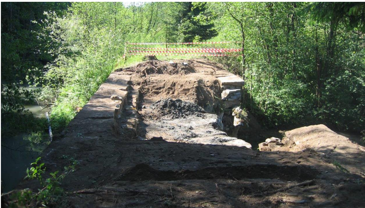
Foto: Bro IV. Avdekking av bro IV i 2009 for å vurdere oppbygging og konstruksjon og som underlag for en eventuell rekonstruksjon av denne eller noen av de andre broene. Foto: NIKU v/AC Flyen
