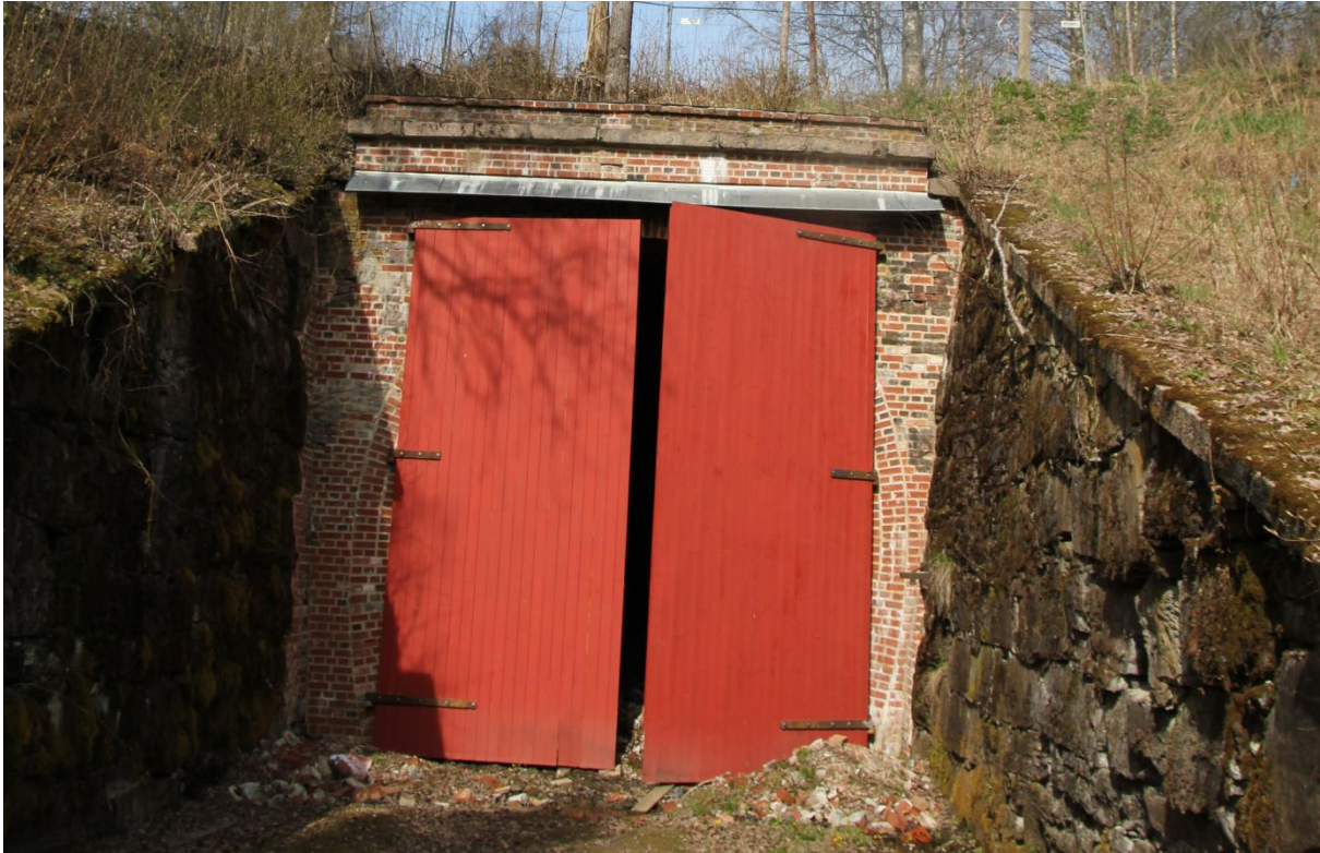
Foto: Løken tunnel. Søndre tunnelåpning ferdig restaurert i 2014. Foto: NIKU v/AC Flyen
