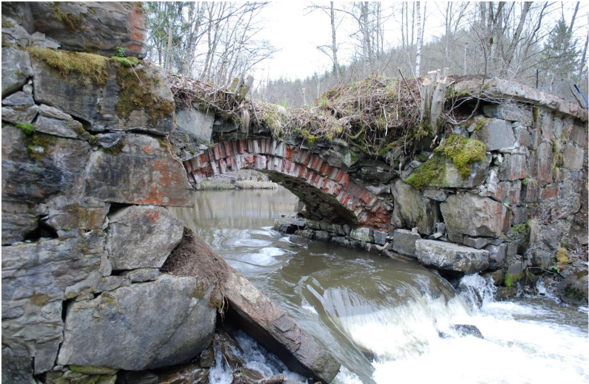
Foto: Bro II før rekonstruksjon i mai 2013. Kun deler av det murte hvelvet står igjen, resten av hvelvet er løst og oppsprukket. Foto: NIKU v/AC Flyen
