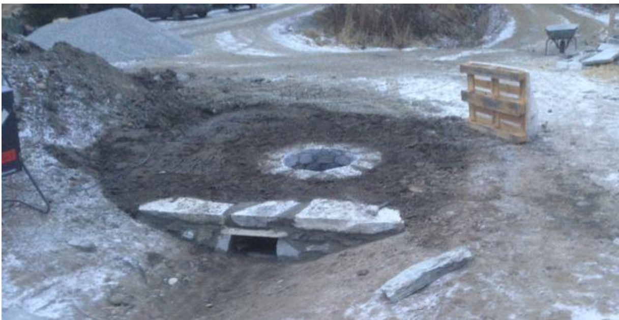
Foto: En av de nye kummene ved siden av jernbanetraséen like utenfor tunet foran banevokterboligen. Arbeidet utført av Bakken og Magnussen AS. Terrenget er bearbeidet og jord lagt tilbake etter dette foto. Foto: NIKU v/AC Flyen
