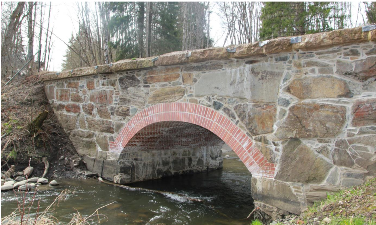
Foto: Bro II ferdig rekonstruert i 2014. Foto: NIKU v/AC Flyen
