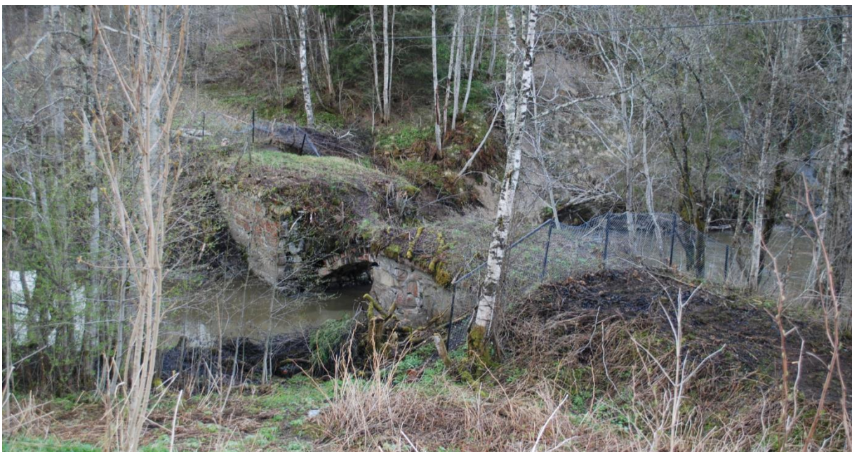
Foto: Bro II og litt av traseen på begge sider av broen i april 2013, før oppstart av rekonstruksjonsarbeidene. Foto: NIKU v/AC Flyen
