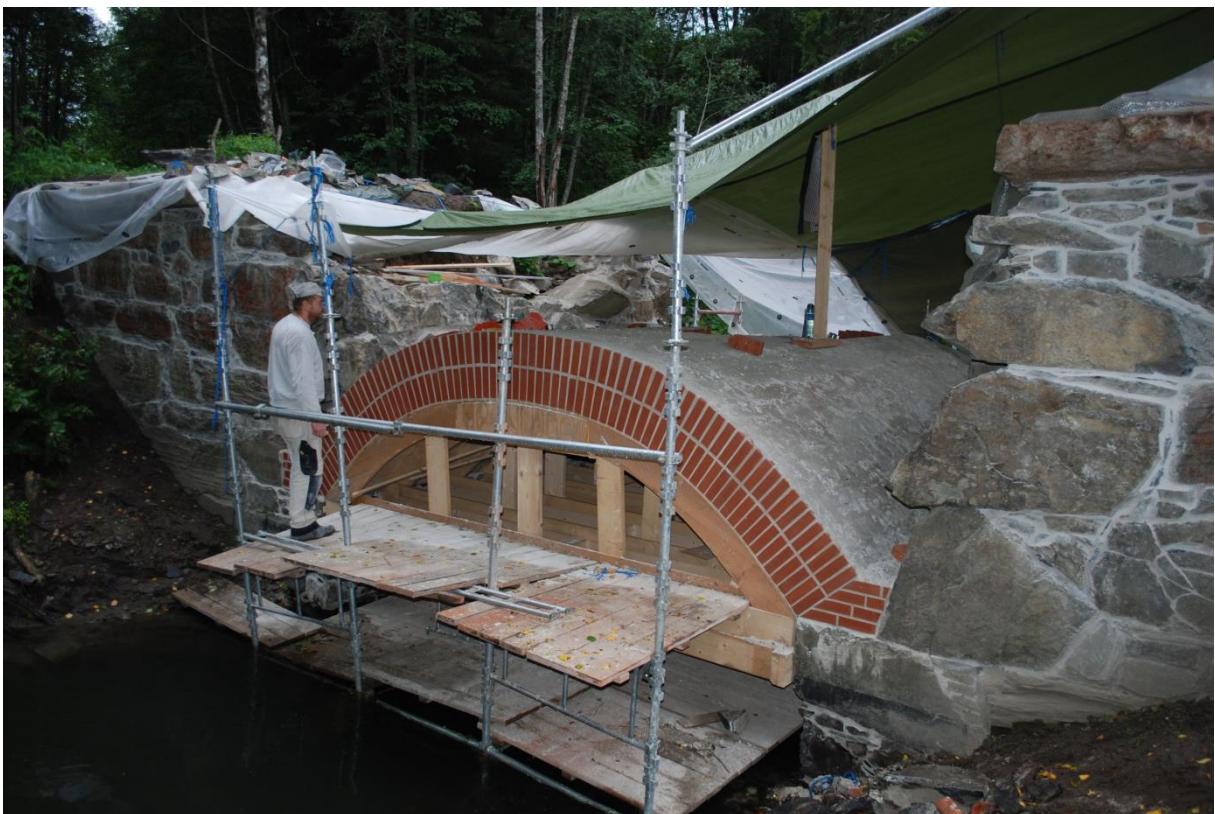
Foto: Bro II. Muring av teglbue i bro II, september 2013. Foto: NIKU v/AC Flyen
