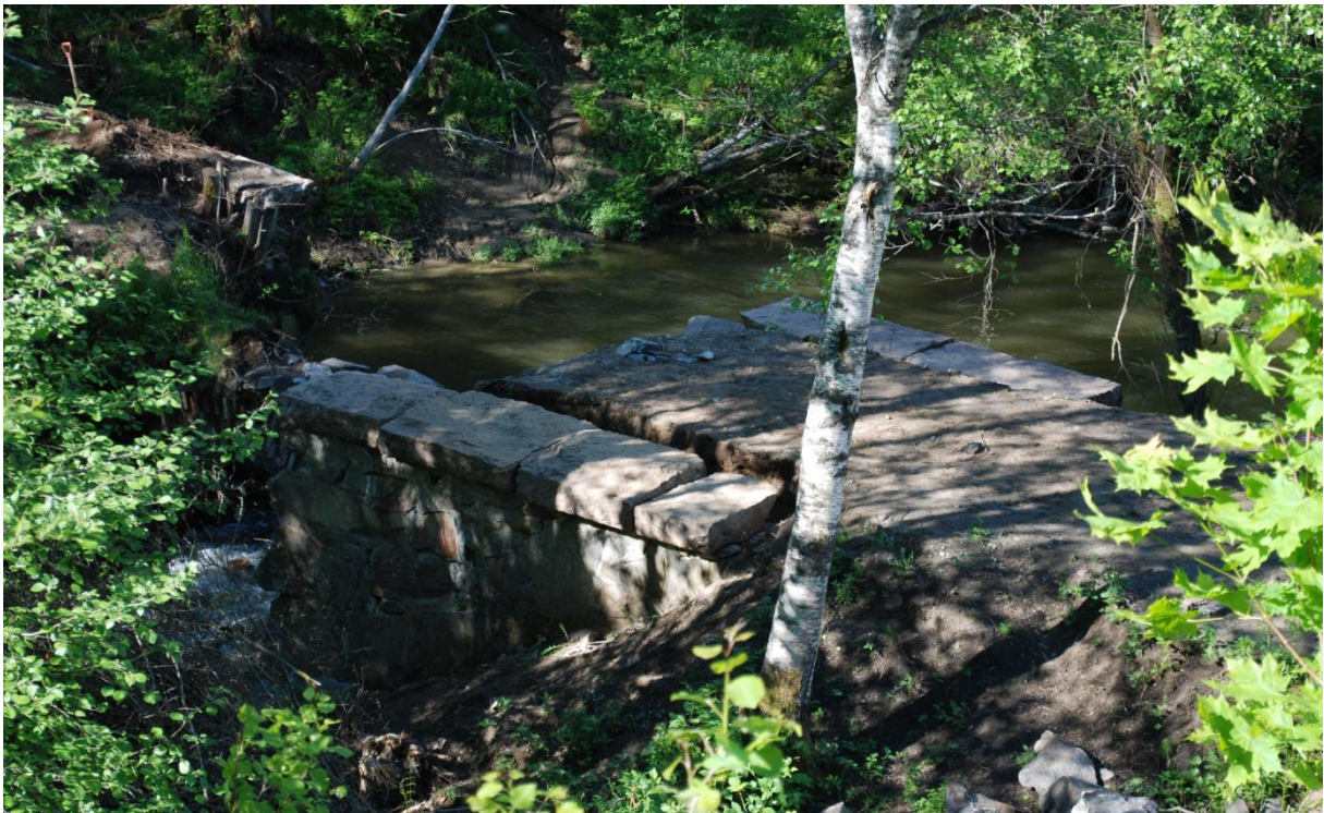
Foto: Bro II. Vegetasjonen er fjernet og bro II er blottlagt i juni 2013. Foto: NIKU v/AC Flyen
