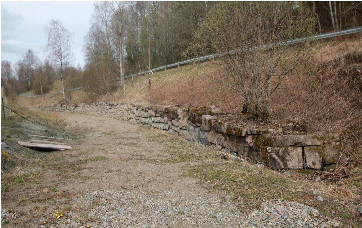
Foto: Den fremgravde jernbanetraséen i april 2015. Opp til 3,5m masse er fjernet over det opprinnelige banelegemet og støttemuren mot skråningen i øst er avdekket. Foto: NIKU v/AC Flyen
