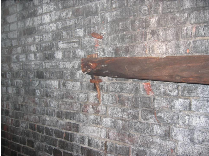
Foto: Løken tunnel. Tunnelveggenes vestsider, feste for tidligere porter. Foto: NIKU v/O. Storsletten
