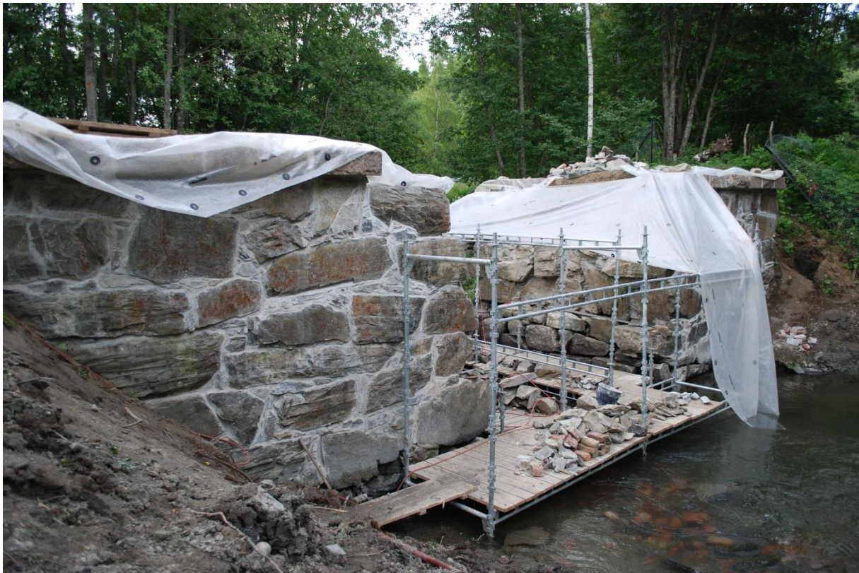
Foto: Bro II under restaurering i juli 2013. Foto: NIKU v/AC Flyen
