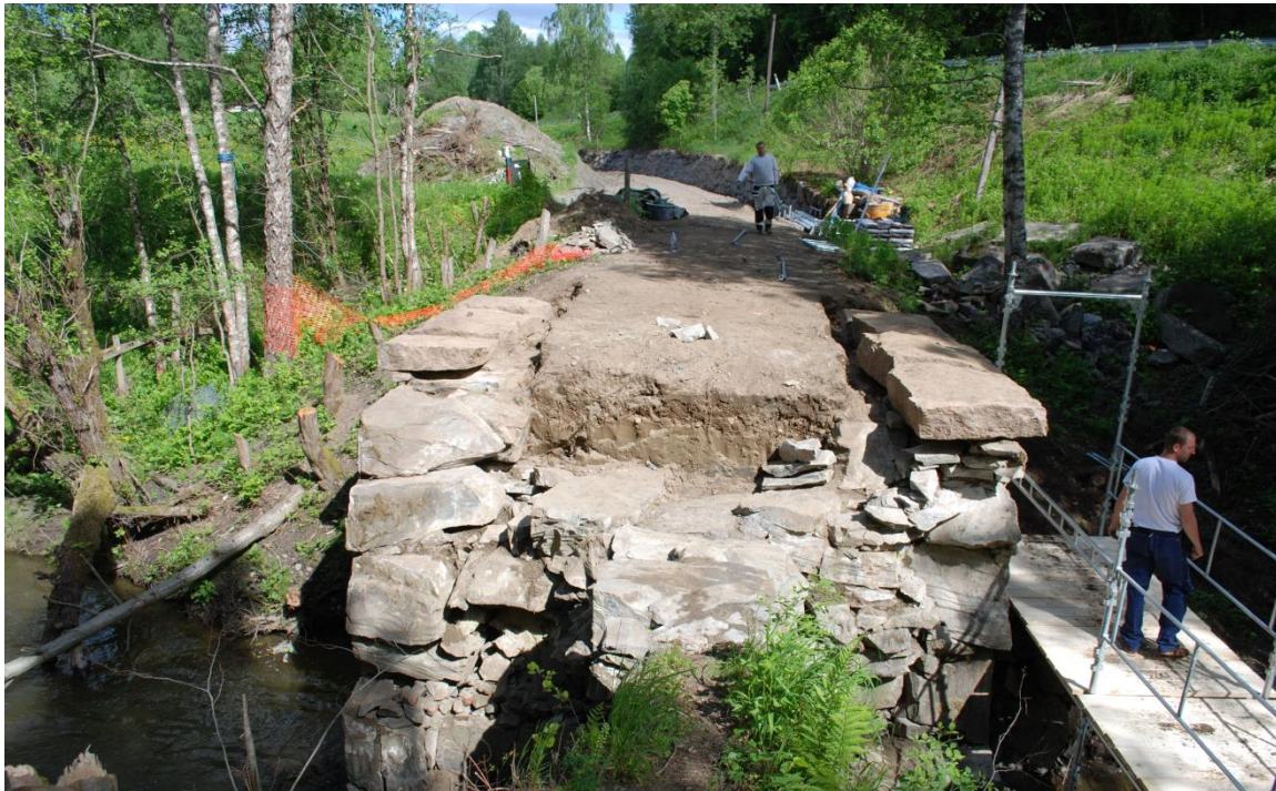
Foto: Bro II under rekonstruksjon i juni 2013. Foto: NIKU v/AC Flyen
