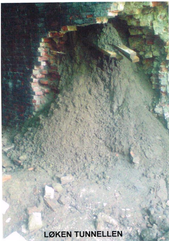
Foto til venstre: Løken tunnel. Raset som gikk inne i tunnelen under arbeidet med søndre portal. Foto: Hedmark murmesterforretning v/E. Hernes
