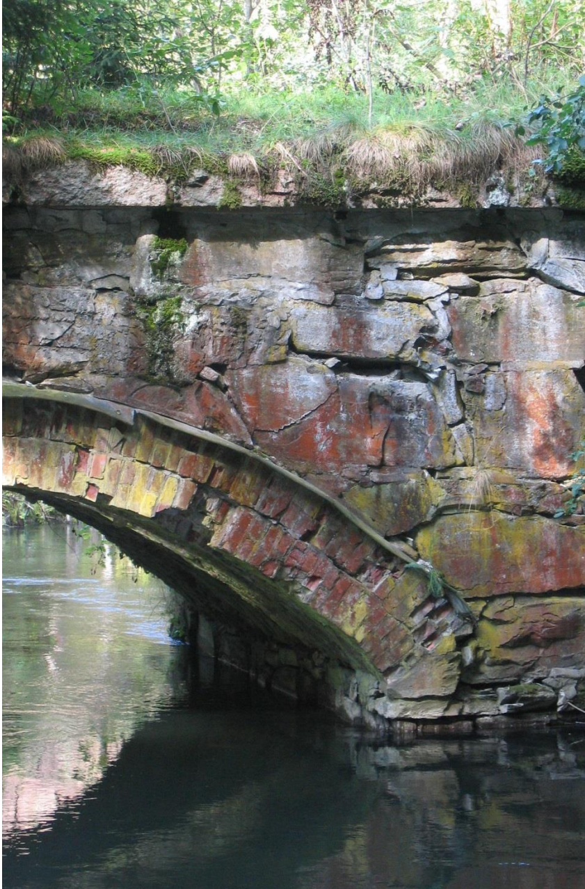
Foto: Bro IV i 2006 med bevart toppstein med dryppnese og sinkbeslag over teglsteinshvelvet. Foto: NIKU v/ A.C. Flyen
