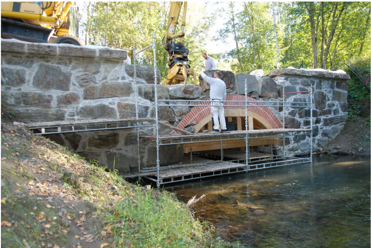
Foto: Bro II. Muring med naturstein over teglbue. Foto: NIKU v/AC Flyen
