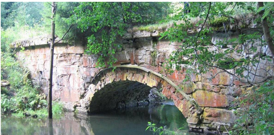
Foto: Bro IV sett fra sydøst i 2006. Broen er ganske intakt ut på avstand. På bro-legemet vokser flere store trær. Foto: L. Mydland, NIKU
