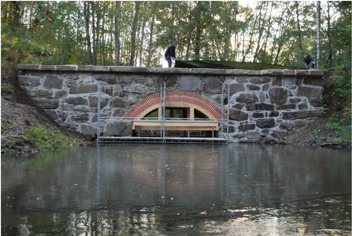
Foto: Bro II nedstrøms, ferdig murt og spekket, september 2013. Foto: NIKU v/AC Flyen
