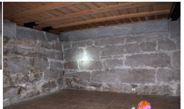
Granittmurer. Vegg forhøyet i forbindelse med heving av etasjehøyde (byggemeldt 1981).
