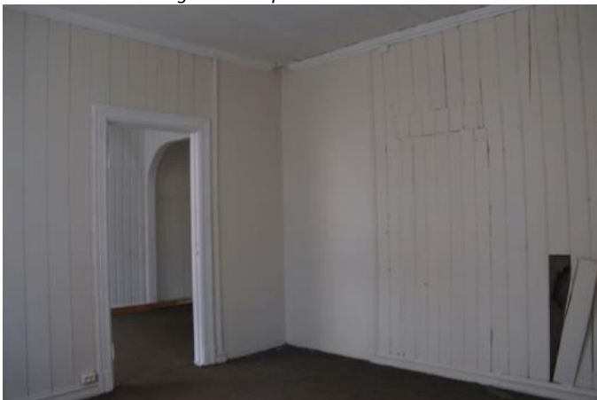
Sett fra vindu. Midtveggen som er oppført i en trekonstruksjon, har en gjenpanelt døråpning. Foto: Siv Leden, NIKU 2015.
