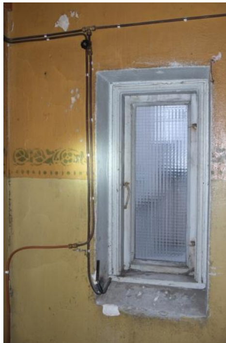
Lite vindu ut mot bakgård. Pusset og malt yttervegg.
