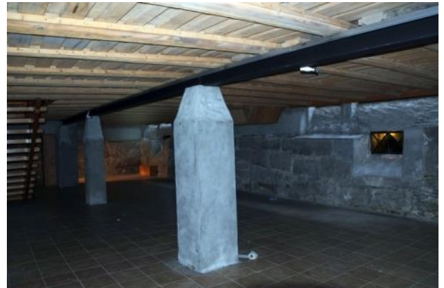
Bæresøyer er forhøyet. Ståldrager bærer nytt dekke (1981).
