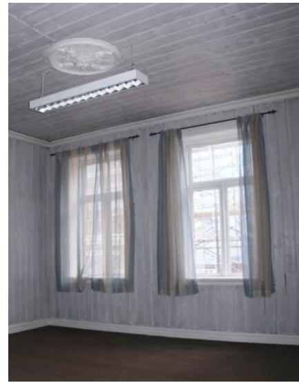
Rommet har to vinduer med T-post.
