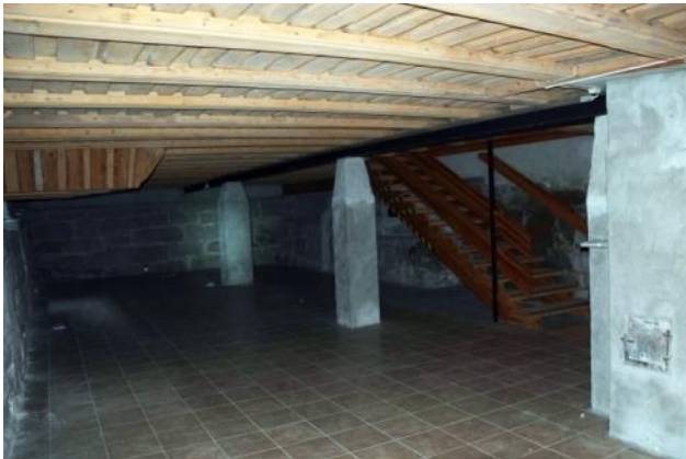
T.v. lavere himling under inngangsparti. T.h. trapp til 1.etasje.
