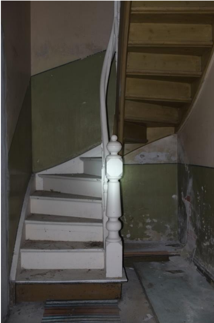
Trapp opp til 2. etasje har opprinnelig vært olivengrønn som høyere opp i etasjene, men er overmalt i hvitt.
