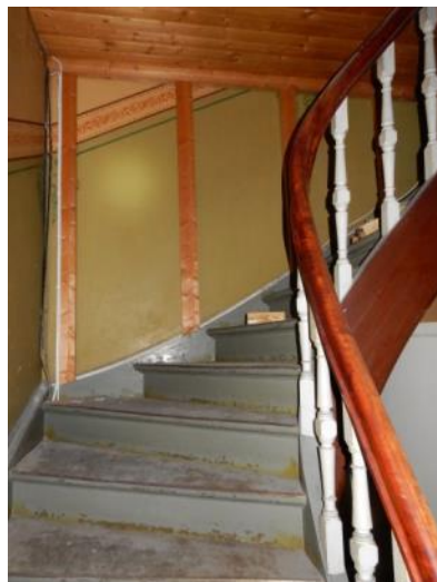
Nyere, umalte stendere på vegg bærer nytt dekke.
