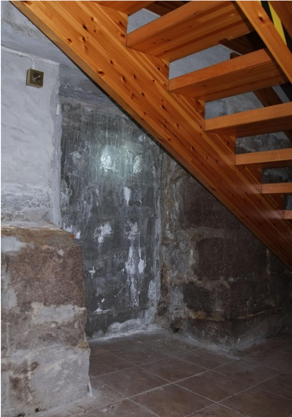
Kjeller. Under trapp fra 1981 ses blendet døråpning der det tidligere var dør til utvendig kjelleroppgang. Foto: Siv Leden, NIKU 2015.
