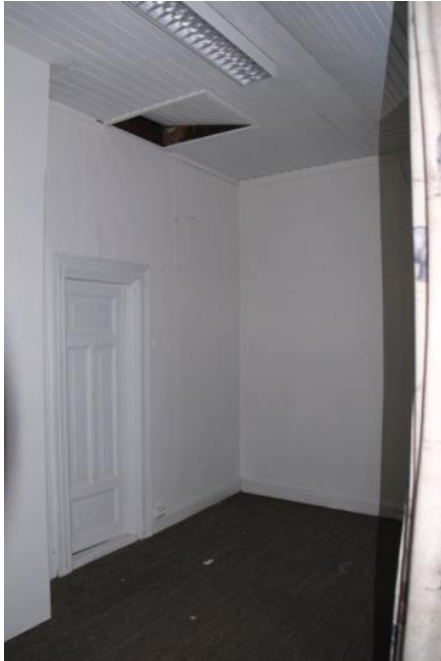
Dør til rom 4 er en fyllingsdør i sveitserstil.
