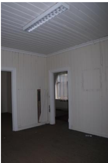
Sett mot rom 2. Foto: SL, NIKU 2015.
