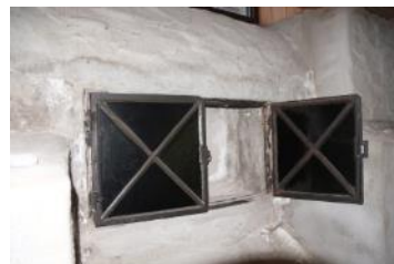
Hvorvidt kjelleren har hatt vinduer ut mot gate opprinnelig, vites ikke. Støpejernsvinduene som er satt inn i muren nå, er nyere og har dekorativ effekt for belysning.
