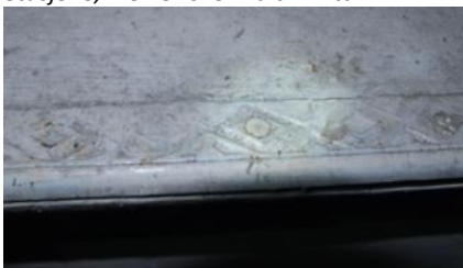
Trappenesene er forsterket med metallbeslag. Foto: Siv Leden, NIKU 2015.
