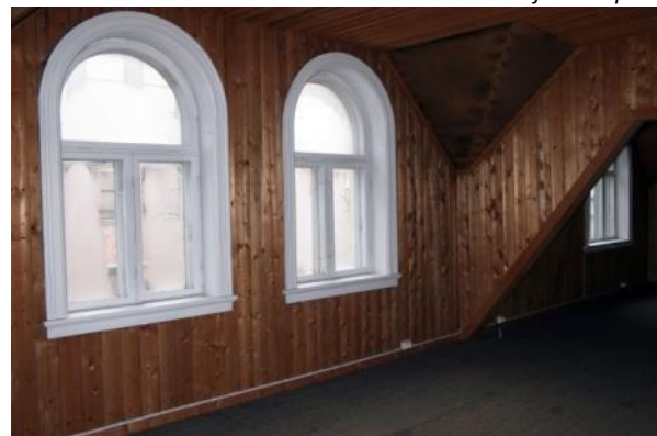
Veggene har umalt panel som opprinnelig har vært trukket.
