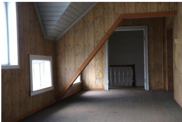
Sett mot rom 1 og trappeoppgang.
