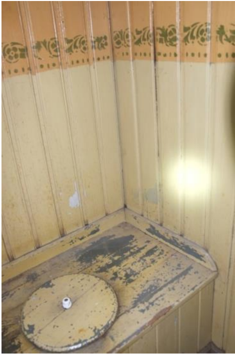
Do-benk. Panelte vegger mot bod.
