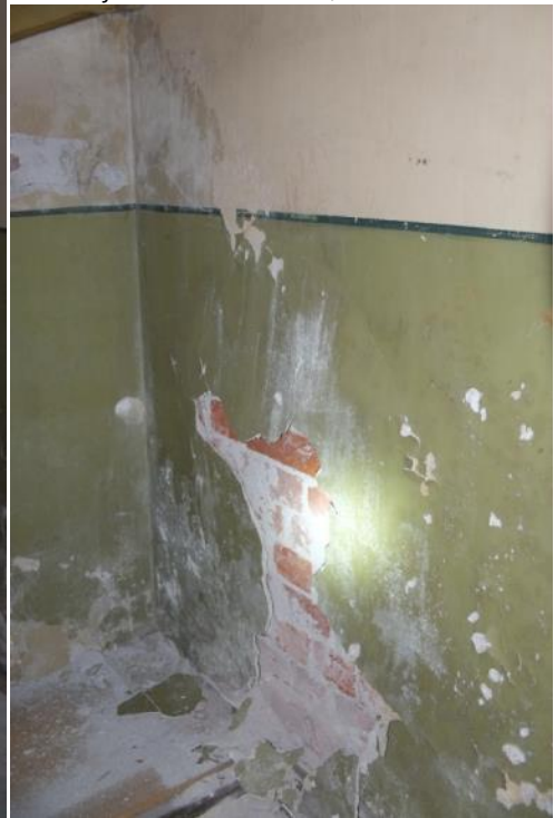
Teglveggen er pusset og malt.
