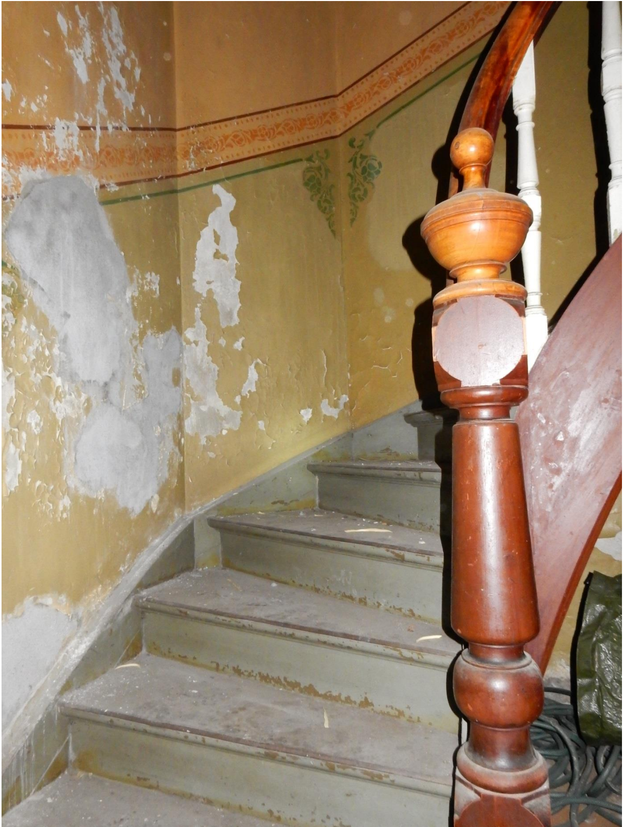
1. etasje. Hovedtrapperom i bygningens sørøstre hjørne. Sjablongdekorerte vegger, ådret trapp. Foto: Siv Leden, NIKU 2015.
