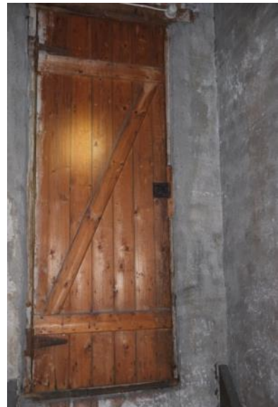
Dør til trappegang.
