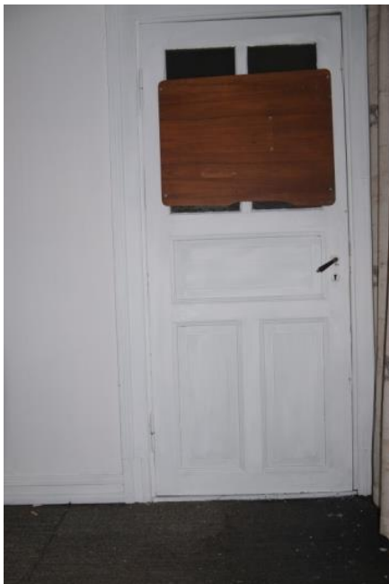
Dør til bakgårdstrapp. Trådglass i øvre felt.
