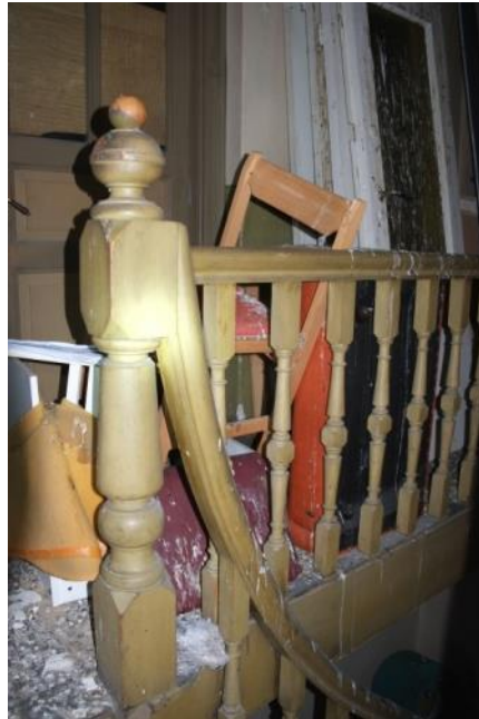
Dreid trappemegler og balustre.
