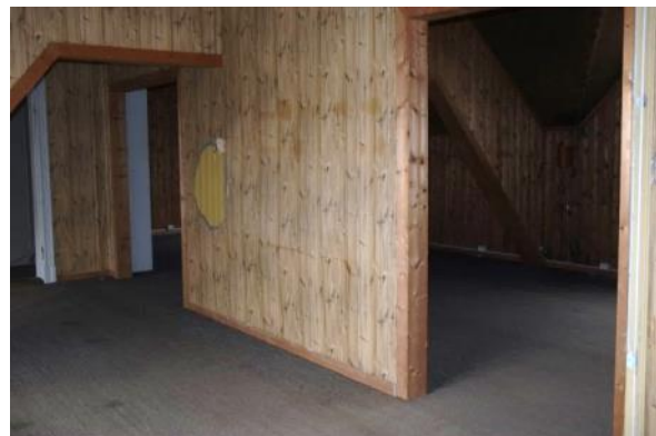
Sett mot midten av bygningen. Veggene har faspanel, men er overtapetsert med et papirtapet med «furu-mønster».
