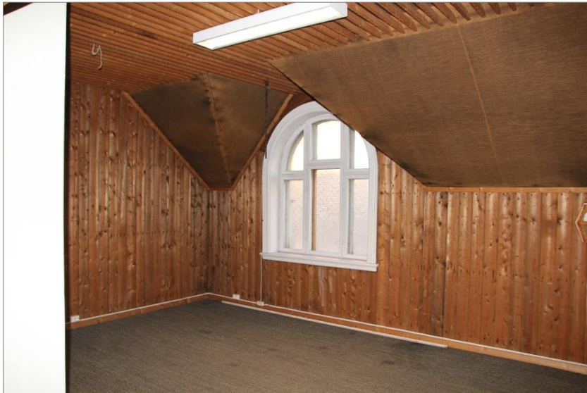
Veggene er umalte. De var opprinnelig trukket/tapetserte. Hvitmalt brannmur t.v.
