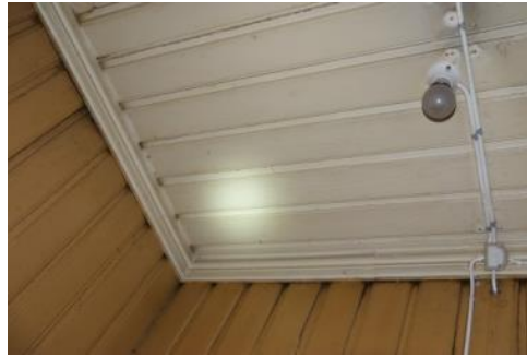
Himling og vegg har perlestaffpanel.
