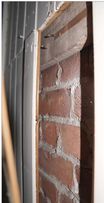
Yttervegg i 2. etasje kledd med panel innvendig. I de finere rommene var panelet tapetsert.
