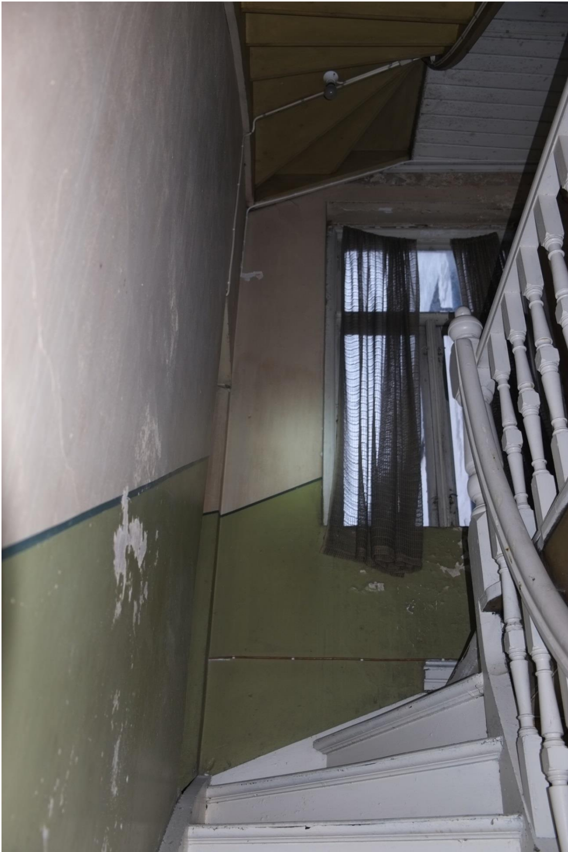
Bakgårdsfløy. Trapperom, 2.etasje. Til høyre ses døråpning inn til do. Foto: Siv Leden, NIKU 2015.
