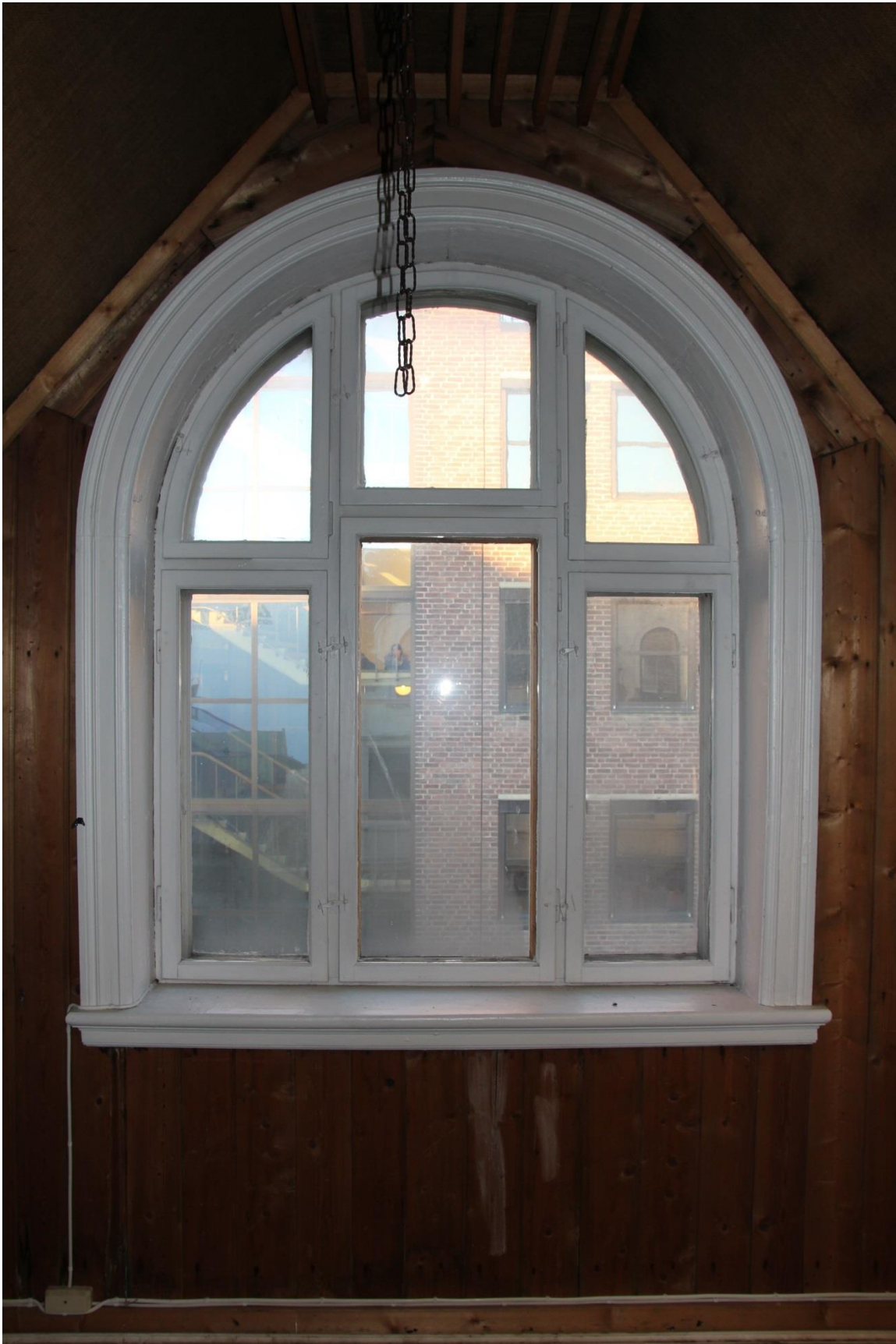
3.etasje. Vindu i tidligere stue. Foto: Anne-Cathrine Flyen, NIKU 2015.
