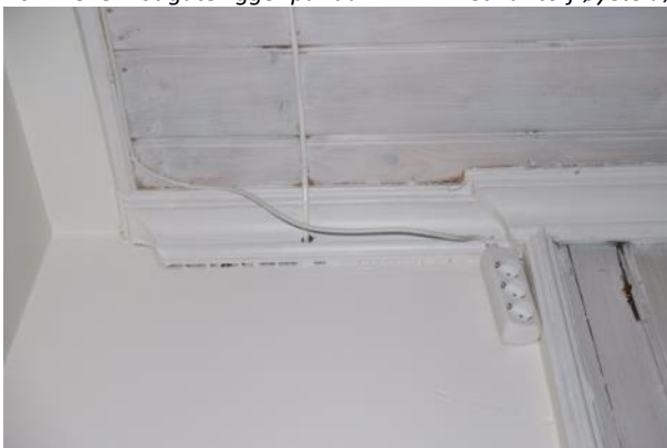
Brannmurlist og taklist. Himling og vegger har vært trukket. Foto: Siv Leden, NIKU 2015.
