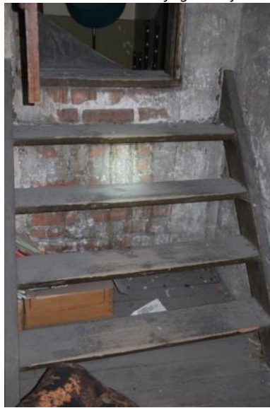
Trapp opp til gangen utenfor.
