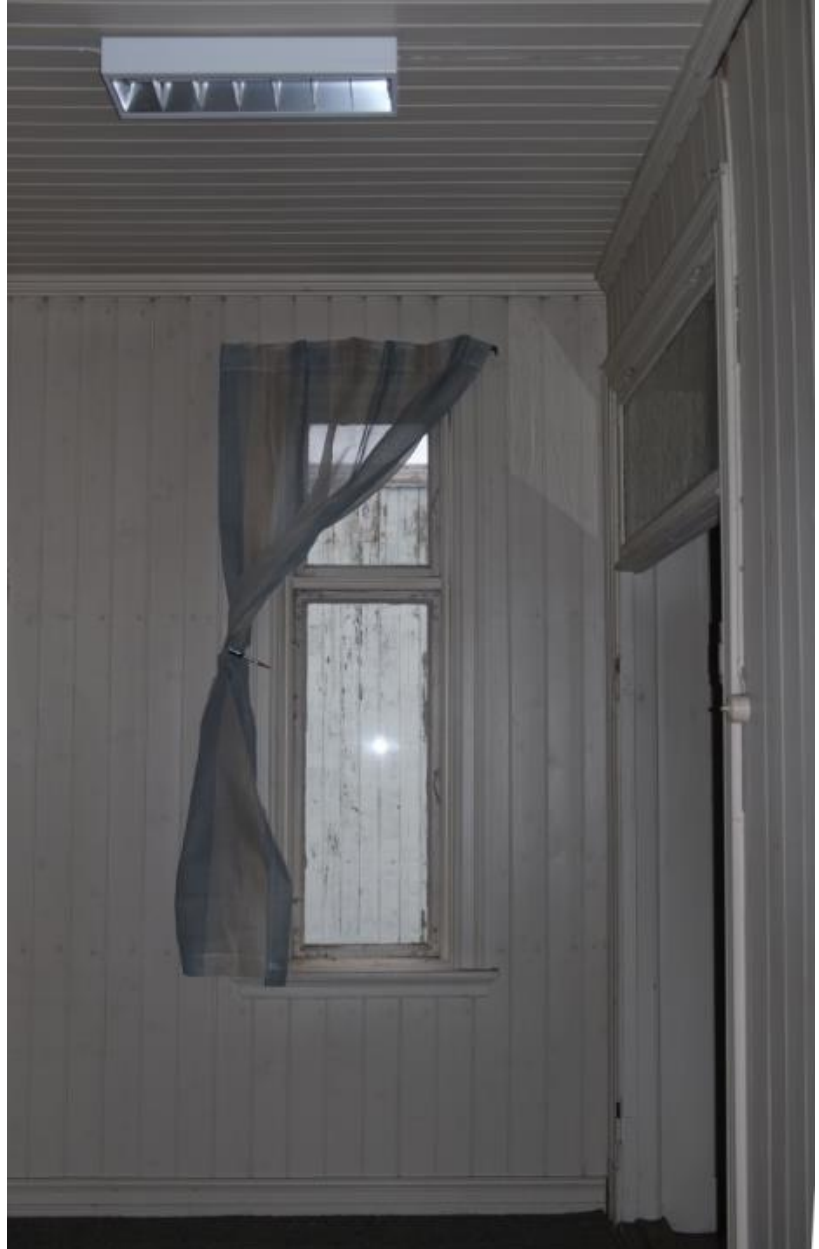
Smalt to-fags vindu mot bakgård. Foto: Siv Leden, NIKU 2015.
