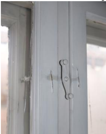
Detalj av vindushaspe.
