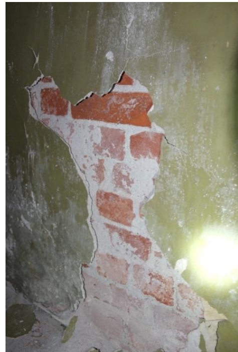
Yttervegg i trapperom er pusset og malt.
