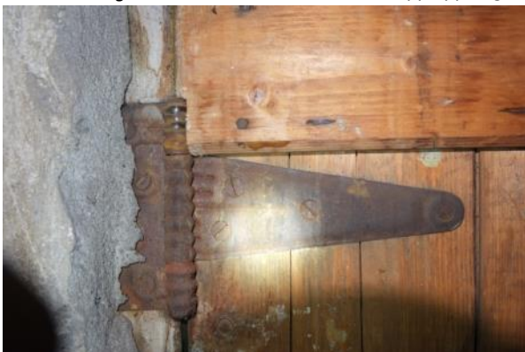
Detalj av dørhengsel (dør mot trappegang). Foto: Siv Leden, NIKU 2015.
