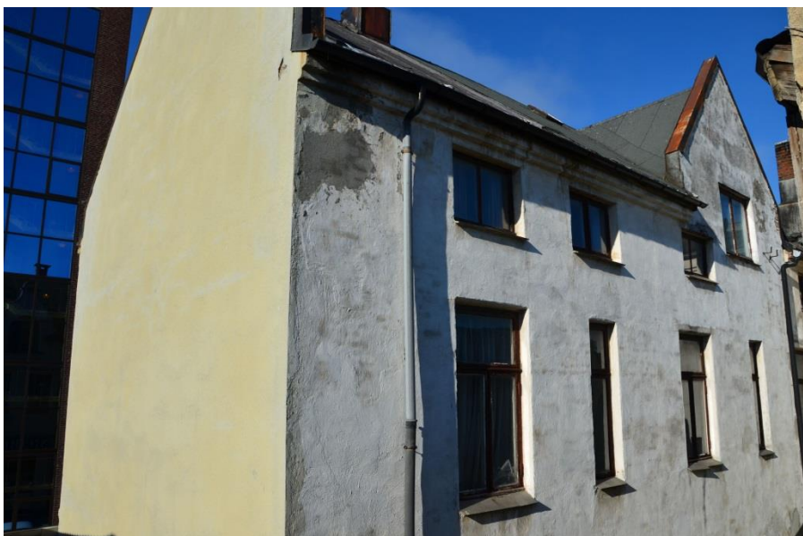
Amtmand Bloms gate 6, gavlvegg og bakgårdsfasade. Foto: Anne-Cathrine Flyen, NIKU 2015.
