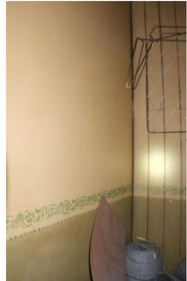
Pusset murvegg mot trapp, panelvegg mot bod.
