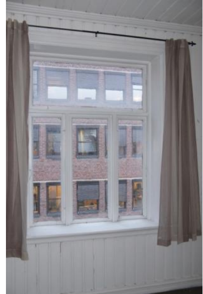
Vinduet mot gaten har fire fag.
