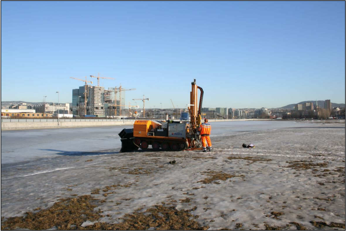
Figur 1: Boring av punkt 13, ved vannspeilet. (Foto: niku_ark_307656).
