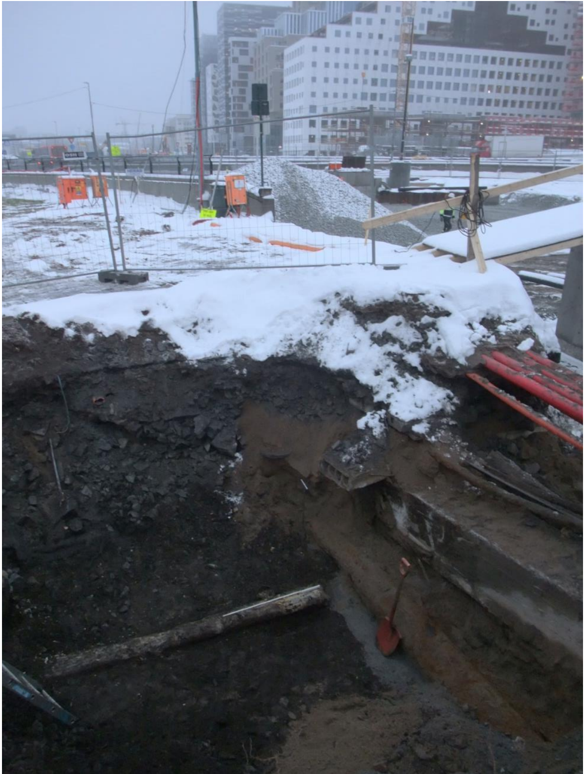
Foto 21: Øverste stakk avkappet mot vannledning. Foto mot vest
