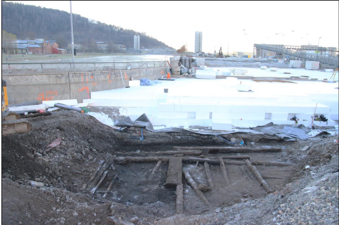
Foto 20: Kong Håkon V.s gate i ferd med å dekke over middelalderens havnekonstruksjoner. Sett mot sør.
