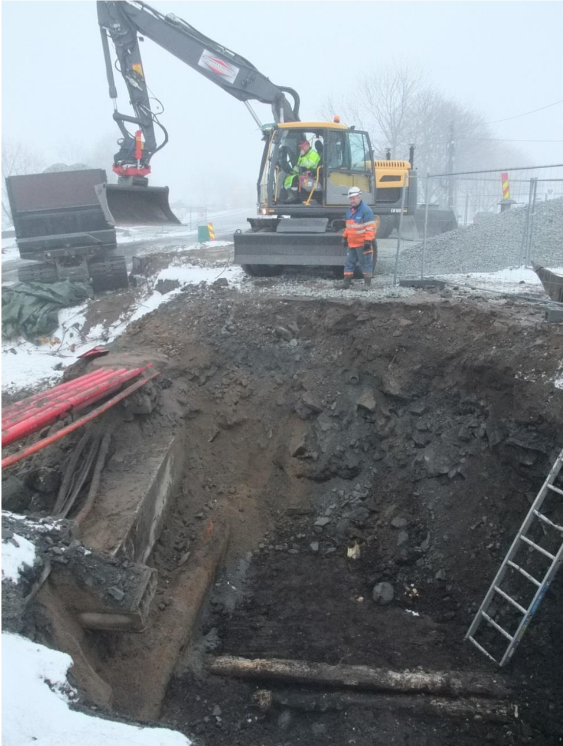
Foto 23: Stokker med påle inntil vestsiden. Foto mot øst
