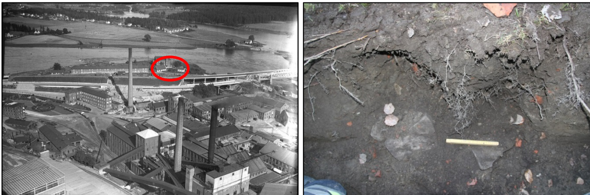
Over til venstre: Bygg som senere er revet. Over til høyre: Rester av mur fra bygg i tilknytning til arbeiderboligene.
