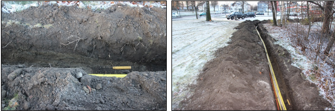
Over til venstre: Sandlaget i profil. Over til høyre det samme laget strekker seg fra tomrestokken i forkant til grøftesvingen i bakgrunnen.
