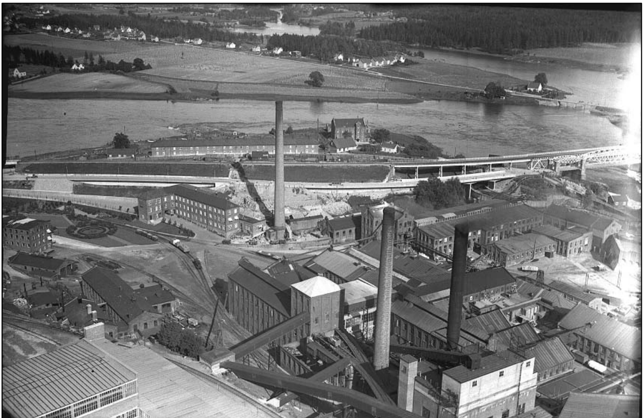
Flyfoto fra 1930 av Tarris ut mot Glommas elvebredd (foto: http://websok.mikromarc.no ).
