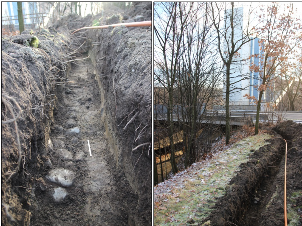
Steinpakningen i grøfta med nedskjæringen til Borregaards jernbanespor liggende ut til venstre.
