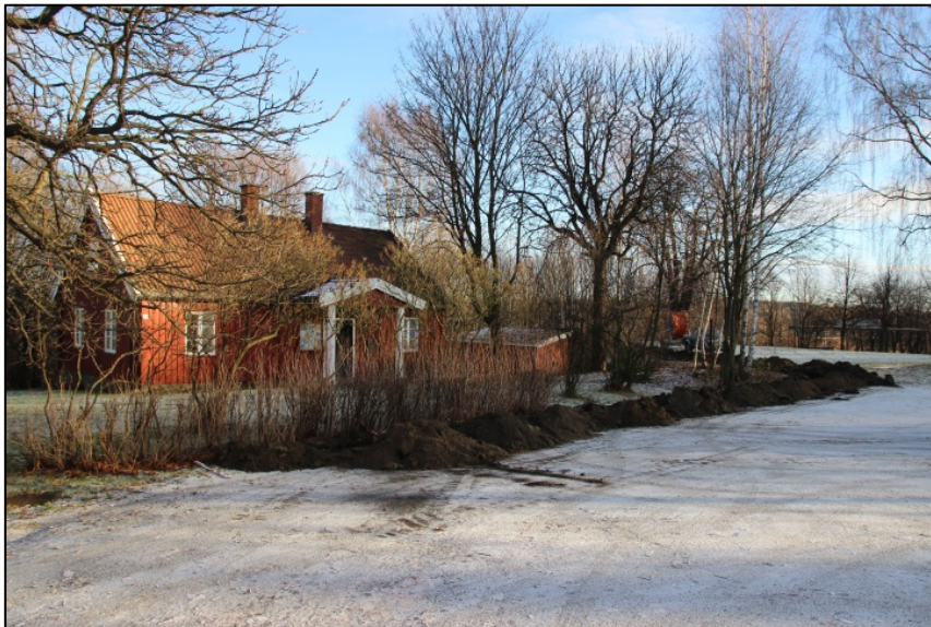
Grinastua med grøfta som ble gravd i kantlinja mellom hagen og parkeringsplassen.
