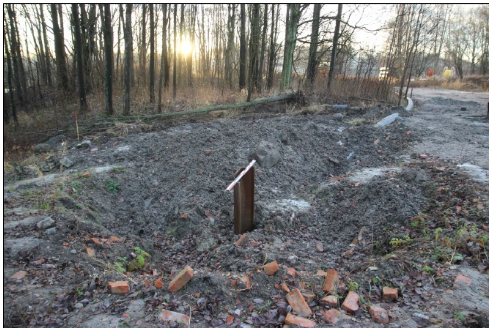
Nylig gravd grop i forbindelse med vannledning.
