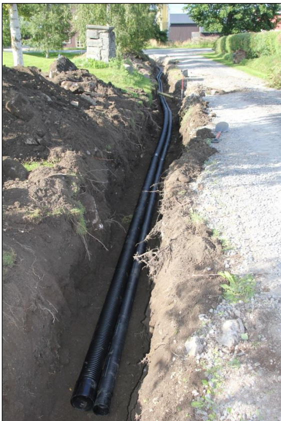
Figur 11: Ferdiggravd grøft med nytt dreneringsrør, S del av kulturminneområdet. Sett mot N. Foto: niku_ark_326469.
