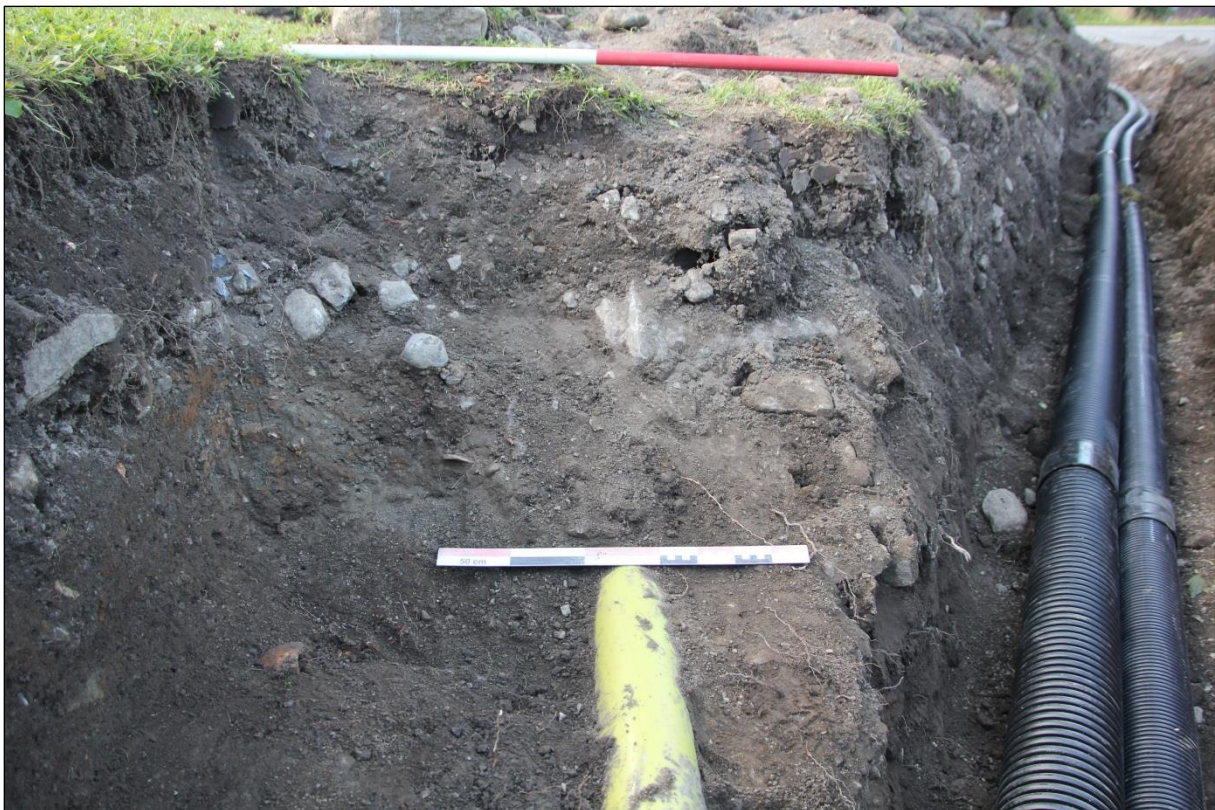
Figur 3: Grav i utvidelse av grøft mot vest ved strømkabel. Sett mot NV. Foto: niku_ark_326475.
