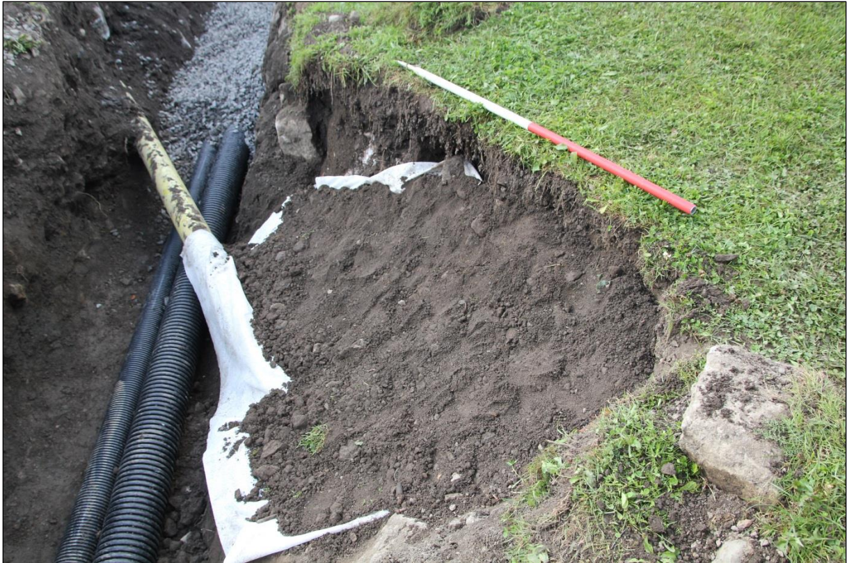
Figur 10: Grav og profil etter tildekking. Sett mot S. Foto: niku_ark_326484.
