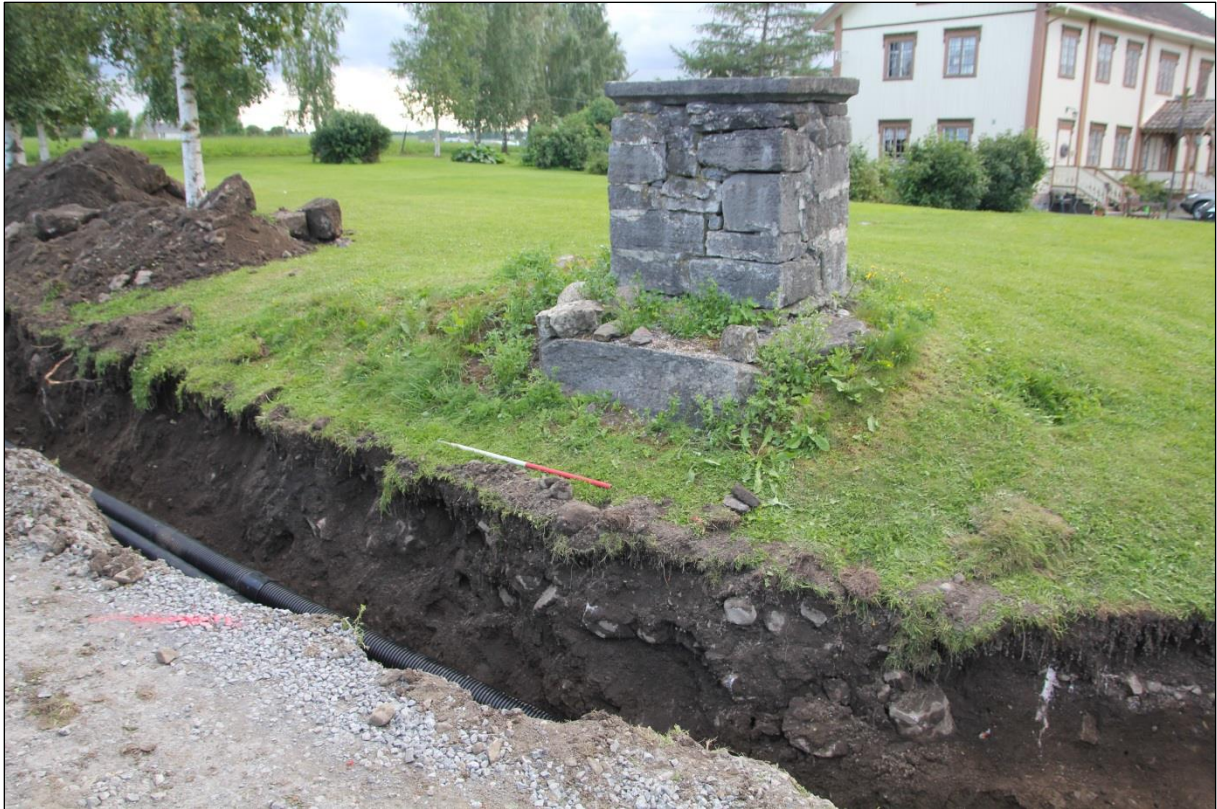
Figur 7: Dystealteret med steinfundamentslag SL6. Sett mot SV. Foto: niku_ark_326478
