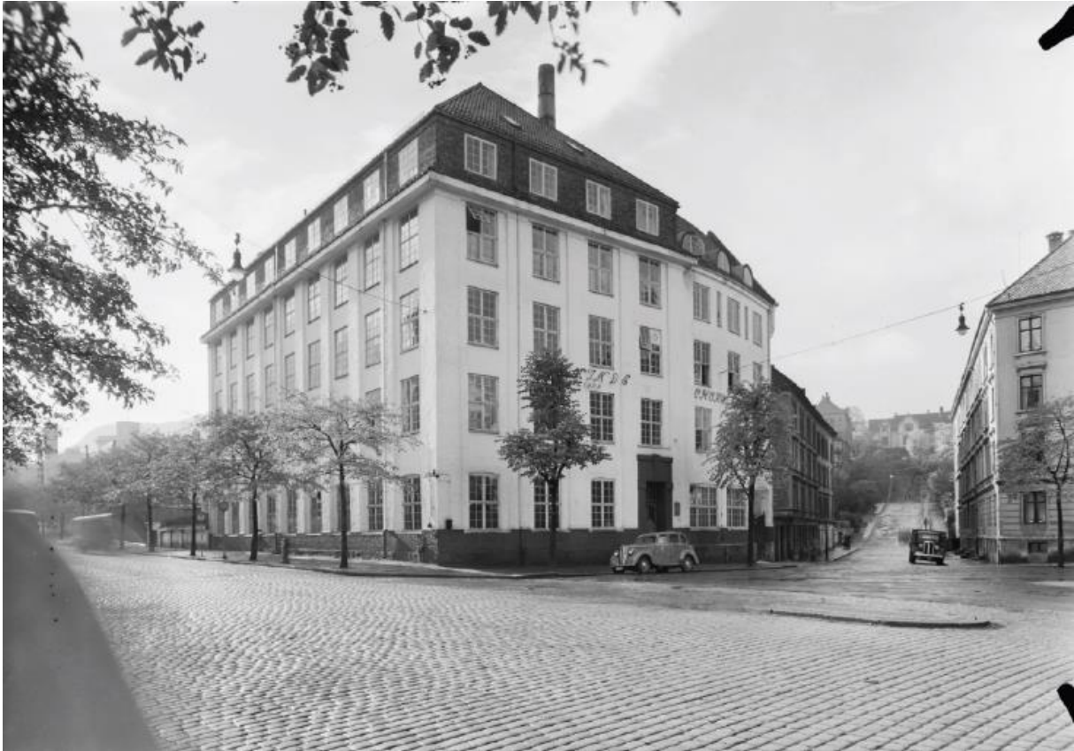
Figur 25. Minde Sjokoladefabrikk i 1950. Kilde. UBB Billedsamlingen, UBB-NOR-M-1302.
