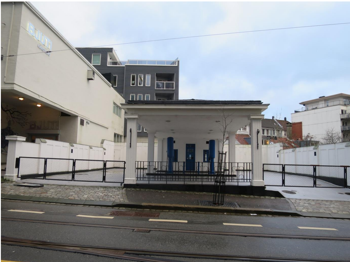
Figur 22. Bensinstasjonen i dag. Kilde: NIKU
