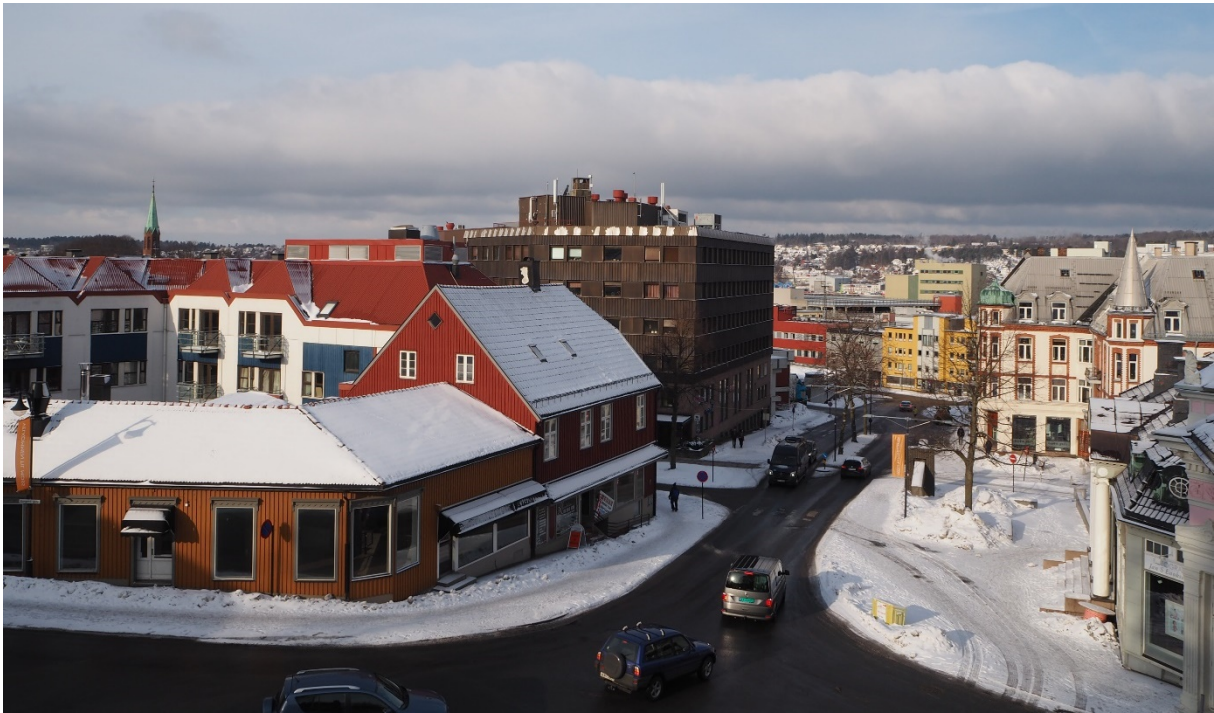
Figur 4-7 Dronningens gate 1 mfl sett fra taket på Basarbygningen (NIKU 2018).
