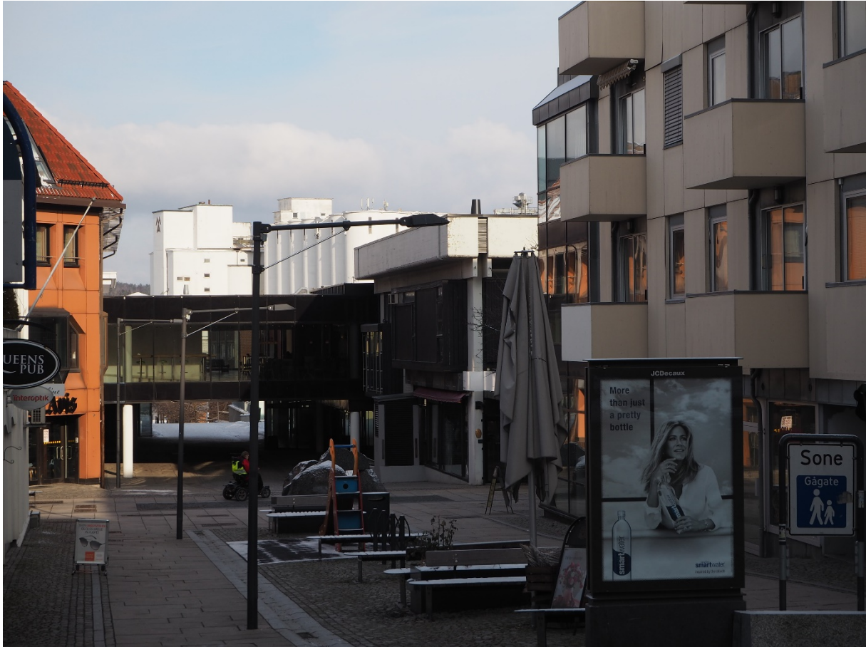
Figur 4-3 Kornsilolanlegget fra 1939 i Havnestredet, tegnet av Eivind Mostue og Ole Lind Schistad, er et arkitektonisk og industrihistorisk landemerke. Den visuelle kontakten med dette anlegget bør opprettholdes og om mulig forbedres. Her sett fra Kronprinsens gate.
