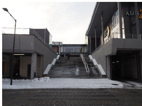
Figur 3-4 Opprinnelig betongdekke mot Th. Petersons gate (fra Byggekunst 1966) og dagens trapp som forbinder Prinsens gate og Kronprinsens gate (NIKU 2018). Dekkets karakteristiske skråstilte avslutning fungerer også som skjermtak over bedriftenes inngangspartier og fortsetter inn under Amfi-senteret hvor det runder hjørnet til Ibsens gate.
