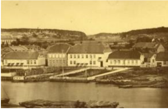
Figur 5-10 Anton Olsen gården i Storgata 6 står fortsatt. Fotografiet viser hvordan de forholdsvis store bygningene lå med lastetomt foran og fasaden fritt ut mot elva.
