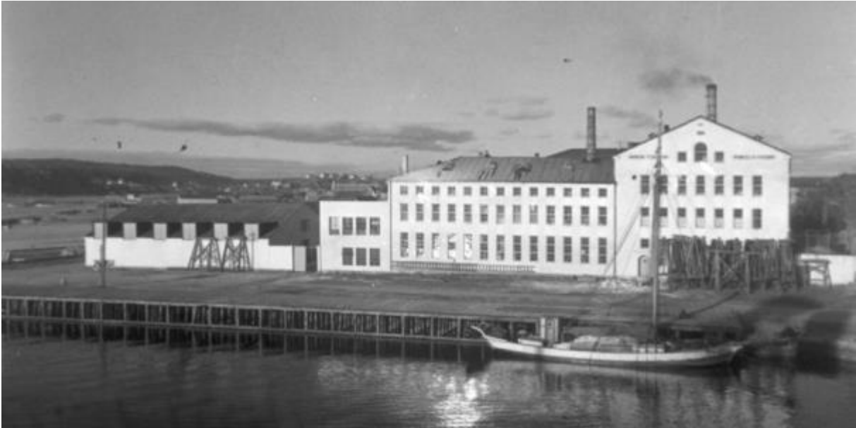
Figur 4-10 Norsk Teknisk Porselensfabrikk (NTP) fotografert fra FMV 1937. Porselenskaia i forgrunnen. Anlegget har blitt bygget ut suksessivt, på utfylling, og speiler til dels produksjonskjeden. Tørkehallene i vest er ikke på plass når bildet er tatt.
