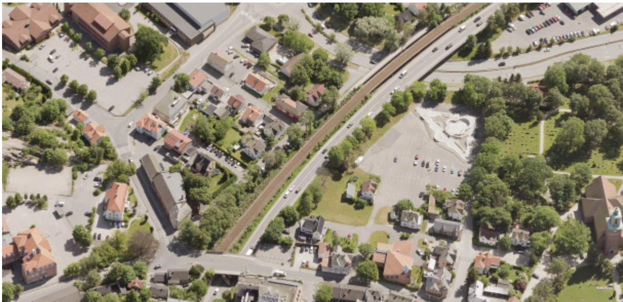
Figur 6-33 Skråfoto som viser Trara med bebyggelsen i blant annet Røde Mølle-kvartalet og langs Øyvind Sørensens vei, Glemmengata sin kurvatur, samt jernbanen fra 1879. Til høyre i bildet Glemmen kirke og sveitserbebyggelsen i Blomsterberget og Husmorveien.
