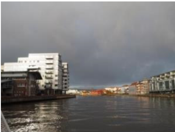
Figur 6-12 Bebyggelse i 8.etasjer på Kråkerøy/FMV som ligger helt ut mot elva. Når bygningene ligger tett, er høye og store, skapes et inntrykk av sammenhengende volum som delvis avskjærer byen bak fra elva. Elva oppleves i større grad som en kanal enn det elva historisk har vært.
