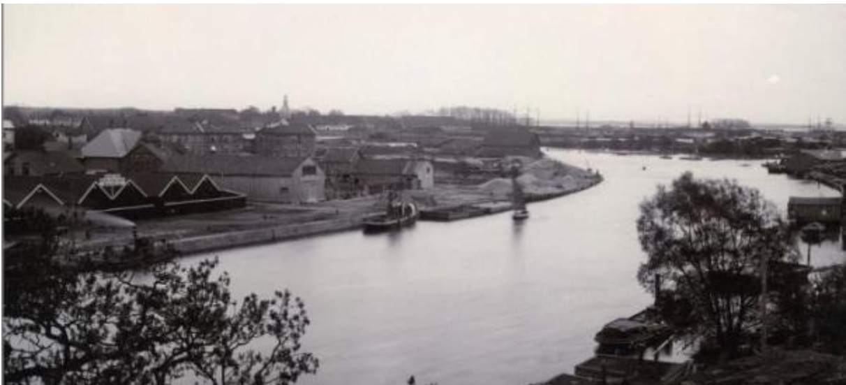
Figur 6-5 Fotografiet er tatt fra Kråkerøy rundt 1900. Fotografiet viser hvordan lastetomtene lå ned mot elva. Spiret på kirken i Gamlebyen sees så vidt. Biblioteket ble bygget her i 1916.
