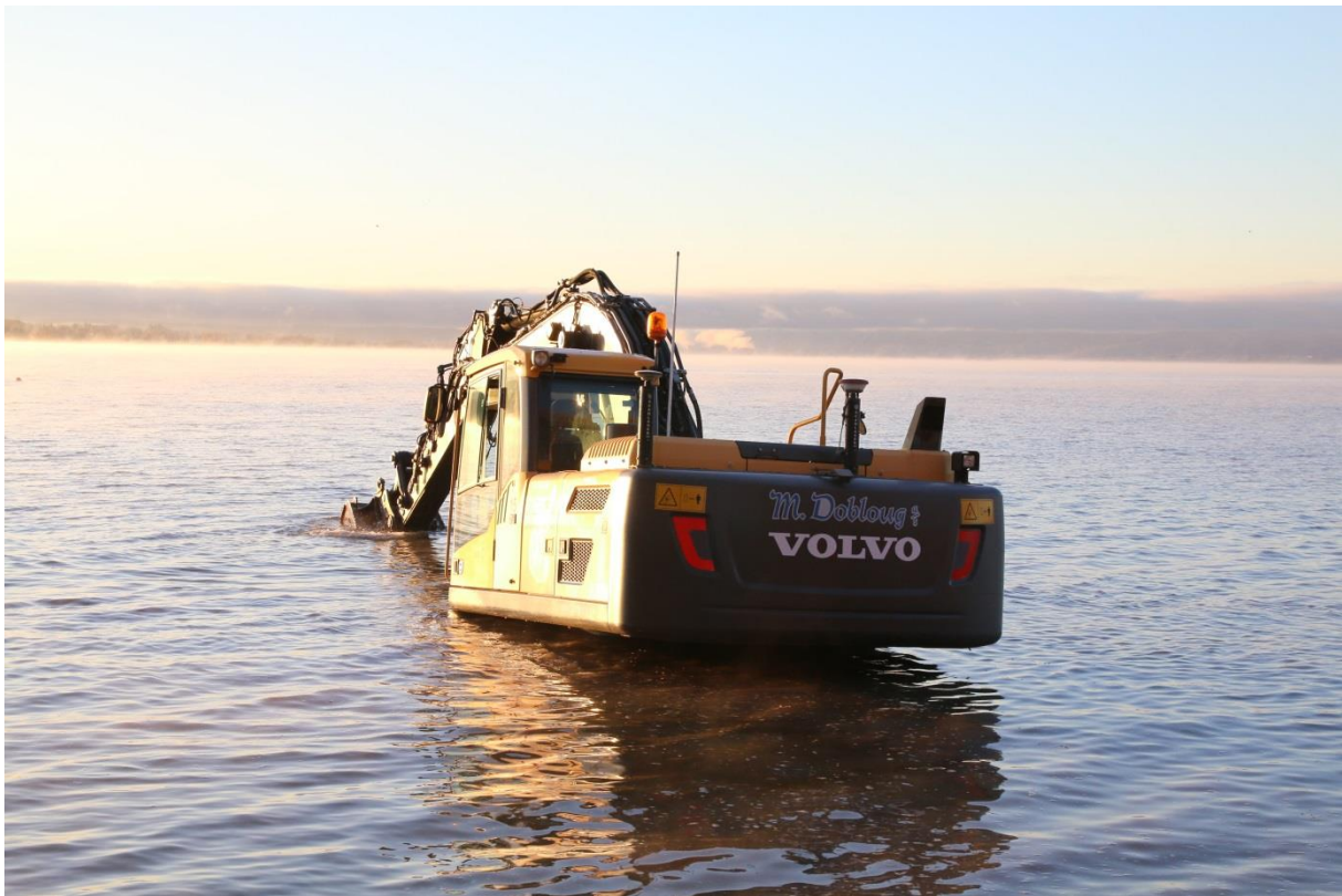
Figur 8: Arbeidsbilde, graving etter eksisterende pumpeledning under vann. Sett mot S. Foto av Nora Furan. Foto-nr: Cf53319_NIKU_0070.JPG
