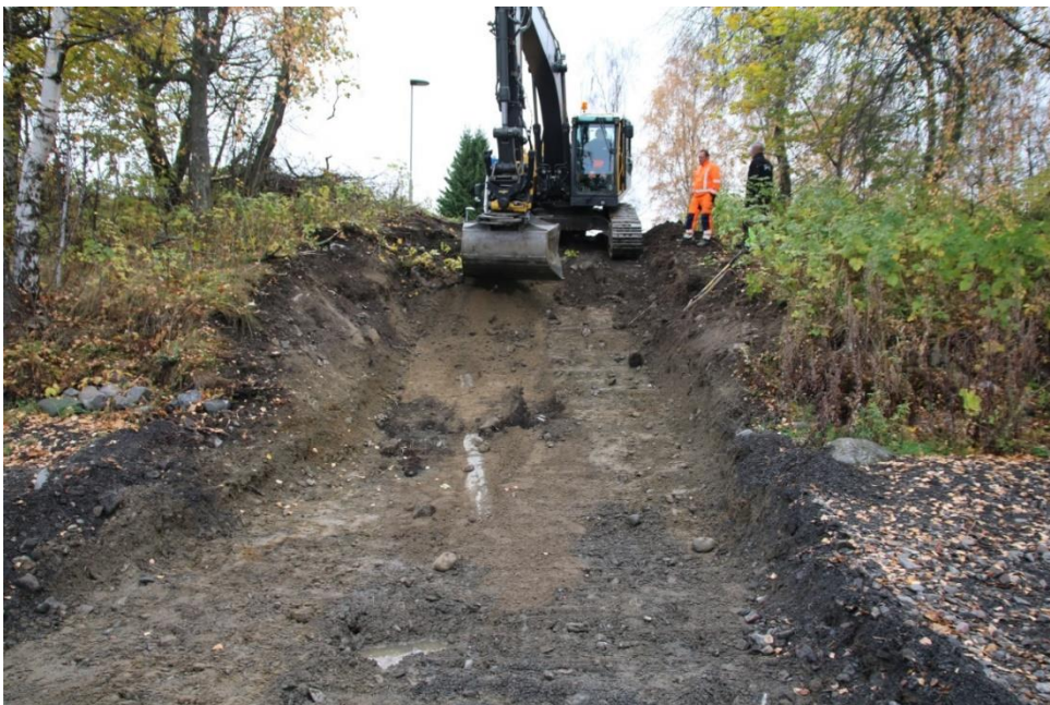
Figur 4: Graving av grøfta, fra sør mot nord. Sett mot N. Foto av Nora Furan. Foto-nr: Cf53319_NIKU_0023.JPG
