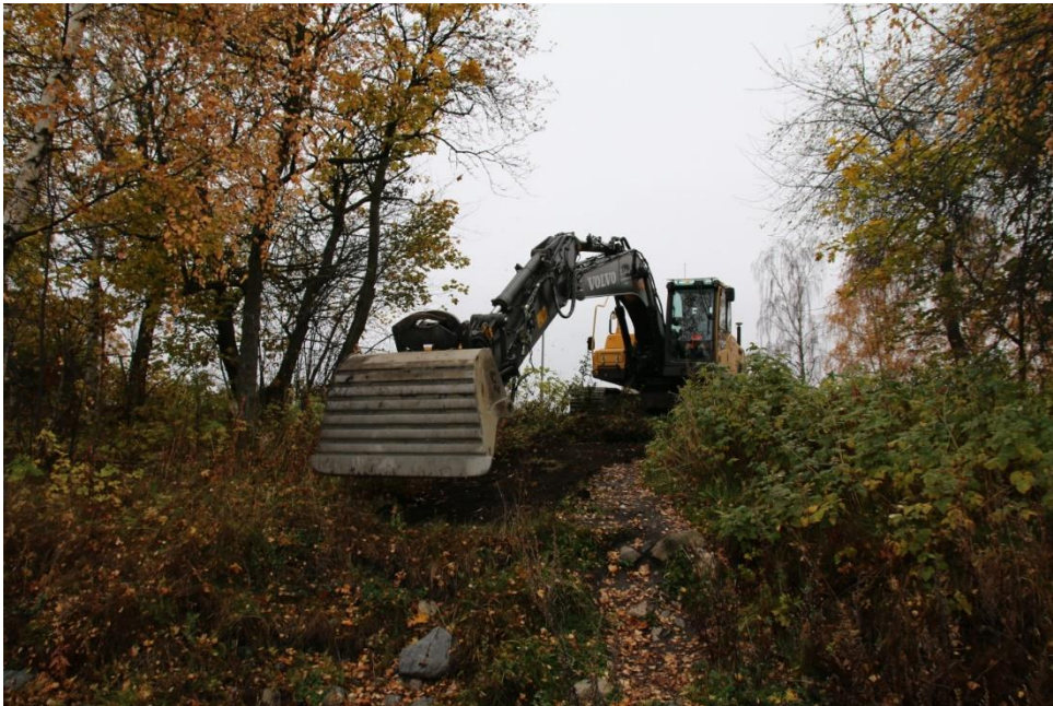
Figur 2: Oversikt ved oppstart av gravearbeidene. Sett mot N. Foto av Nora Furan. Foto-nr: Cf53319_NIKU_0019
