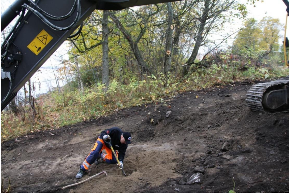
Figur 3: Arbeidsbilde, søk etter eksisterende pumpeledning. Sett mot V. Foto av Nora Furan. Foto-nr: Cf53319_NIKU_0021.JPG
