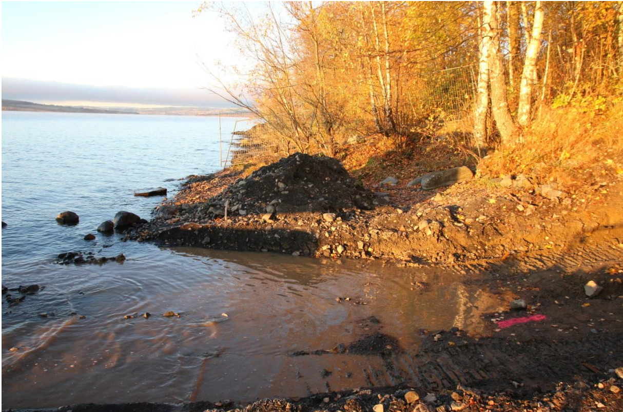
Figur 1: Grøft for pumpeledning i overgang sjø/land. Sett mot V. Foto av Nora Furan. Foto-nr: Cf53319_NIKU_0070
