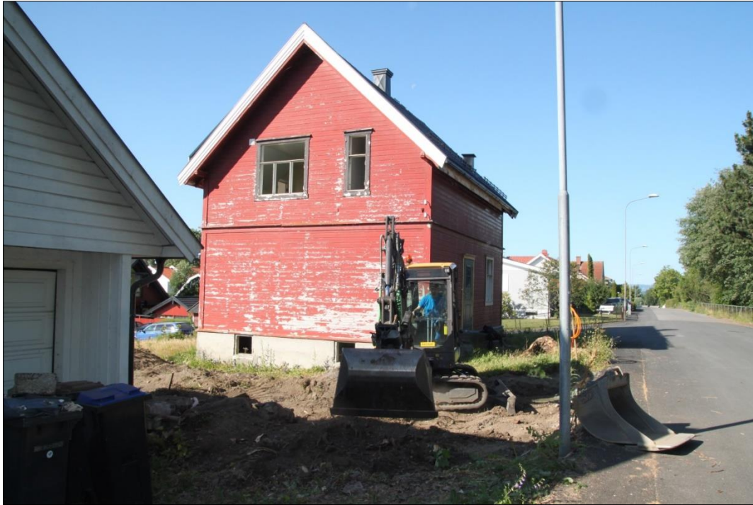
Figur 3: Graving av tomt til garasje, husets Ø-fasade i bakgrunnen. Mot S-SV. Foto-nr: Cf53528_NIKU_0002
