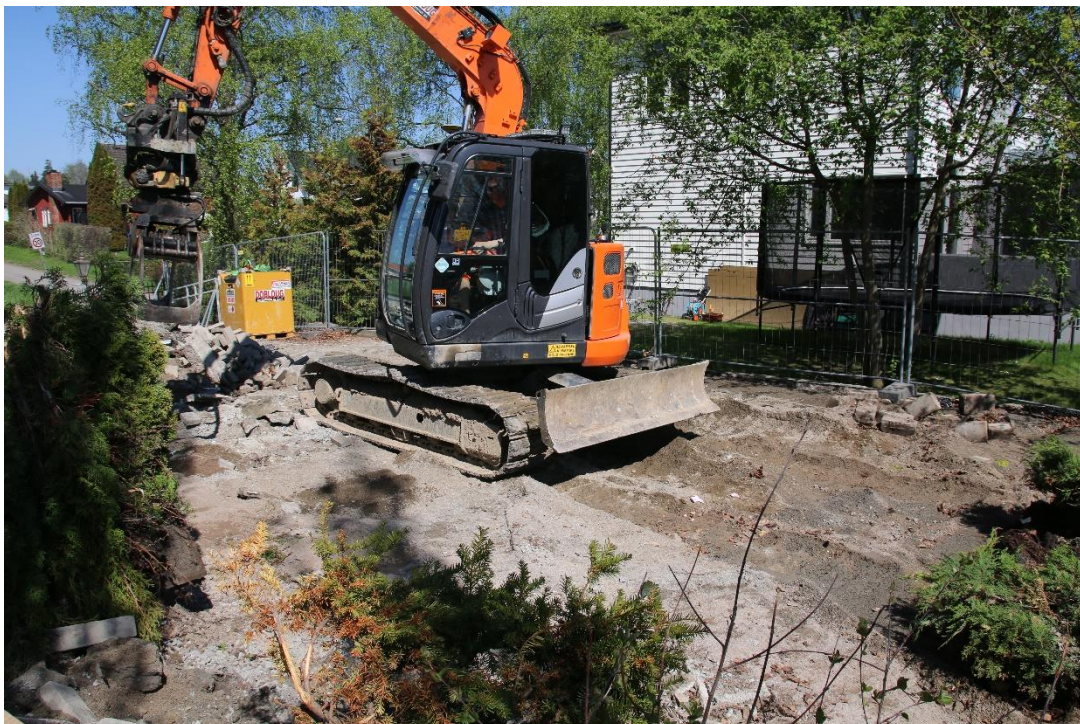
Figur 24: Arbeidsbilde, graving under fjernet garasje. Sett mot NØ. Foto av NF. Foto-nr: Cf53321_NIKU_0090
