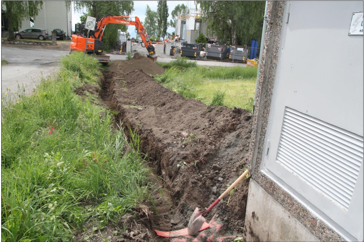
Figur 41: Oversiktsfoto Trafogrøft: grøfta gravd fra trafostasjonen og ned til grensen mot Storhamargata. Torfinngate i øst og NRK-jordet i vest. Mot S-SV. Foto-nr: Cf53321_NIKU_0109
