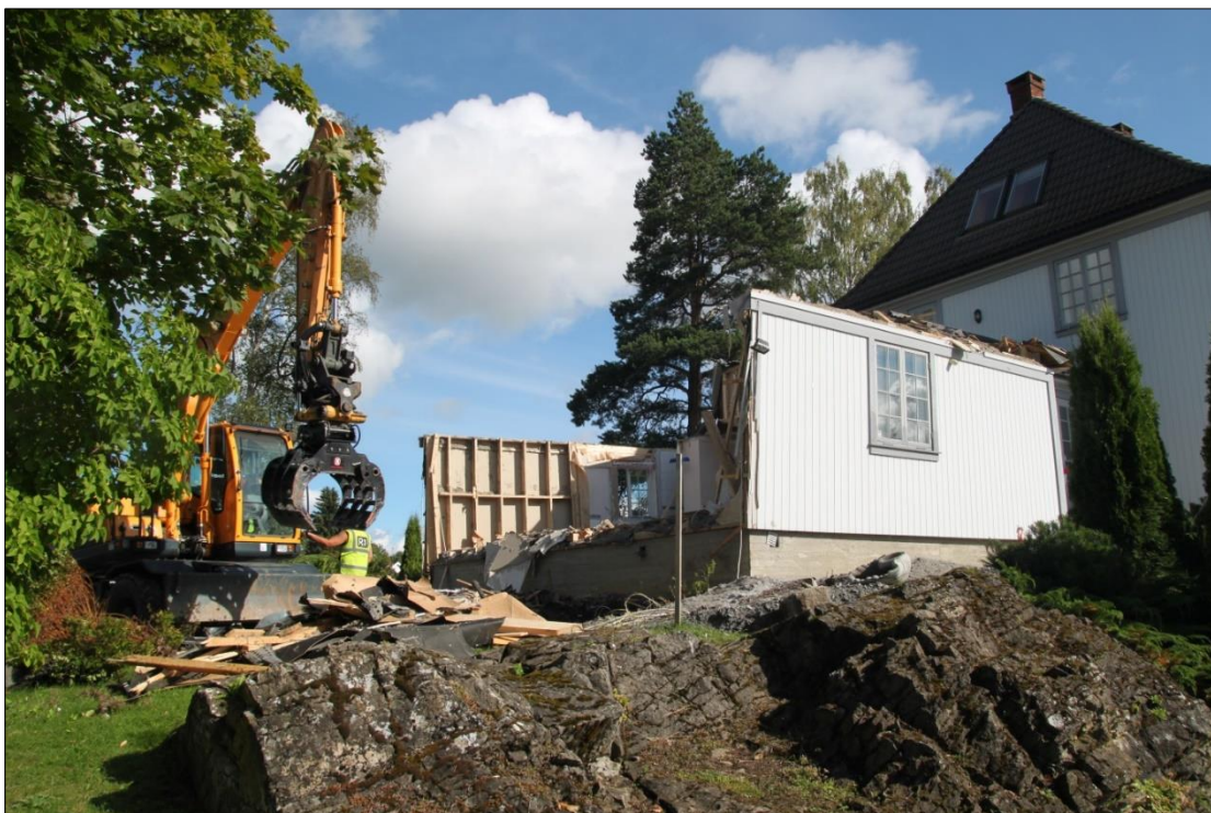
Figur 11: Undersøkelsesområdet: V-tilbygg, riving påbegynt. Fjell i dagen i forkant. Mot N-NØ. Foto-nr: Cf53321_NIKU_0010
