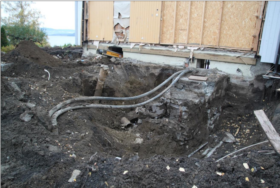
Figur 22: Ø-tilbygg: oversikt nordre del med diverse kummer, jordvarmeledninger, kloakkrør. Prøvesjakt midtre del (foto 20) i bakkant. Mot SV. Foto av HRA. Foto-nr: Cf53321_NIKU_0087
