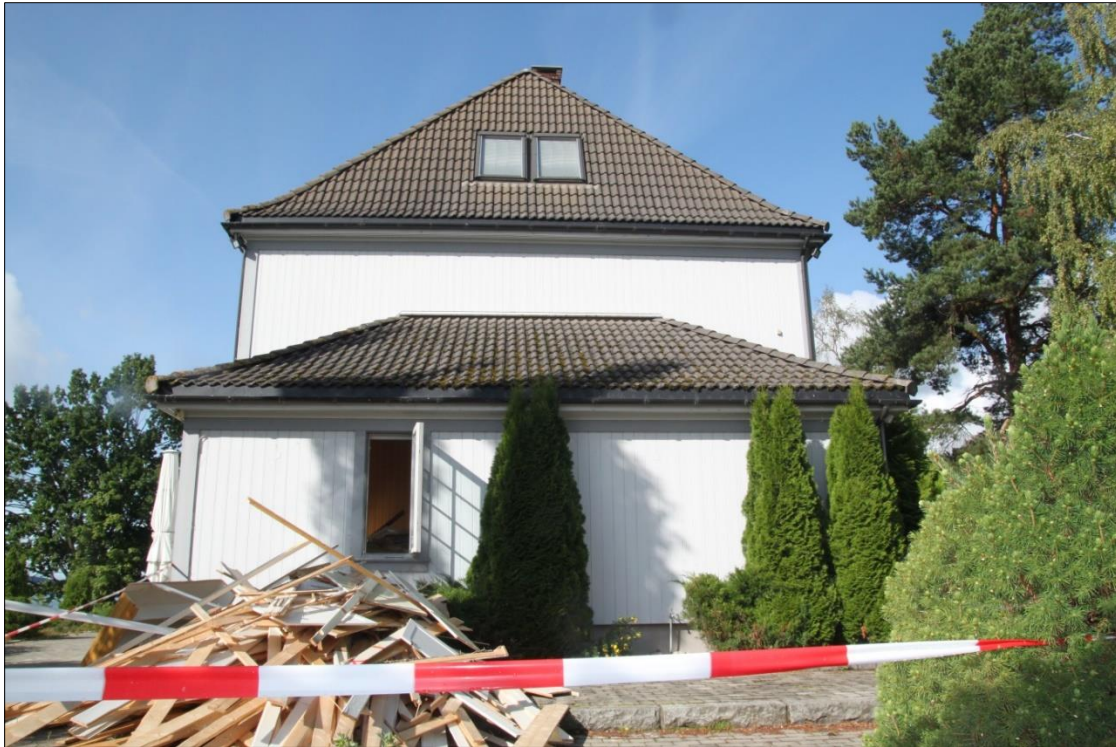
Figur 12: Undersøkellesområdet: Ø-tilbygg, innvendig riving. Mot V. Foto-nr: Cf53321_NIKU_0004
