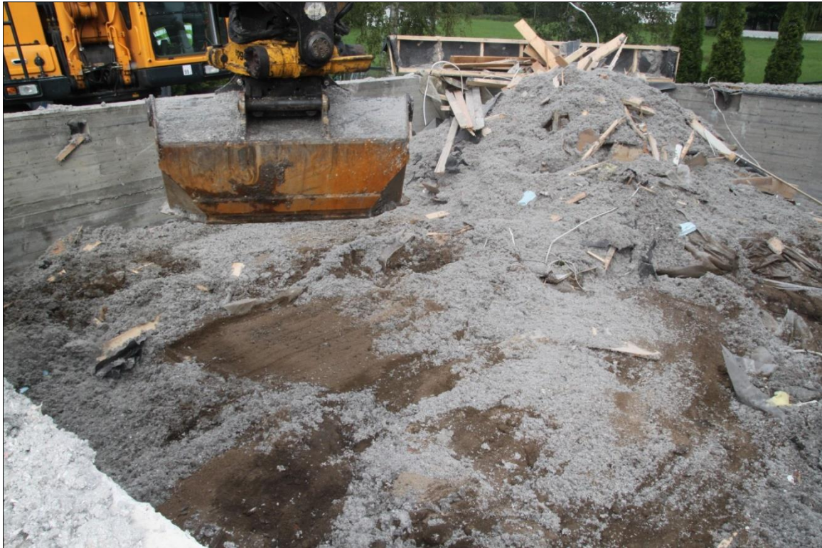
Figur 19: V-tilbygg, Øvre del : under gulvnivå, påførte masser sand/grus/rester div. bygningsmateriale med deler av Midtre del fremgravd: lysebrunt, påført homogent sandlag inkl. plastduk. Planering, fundamentering. Foto-nr: Cf53321_NIKU_0020.
