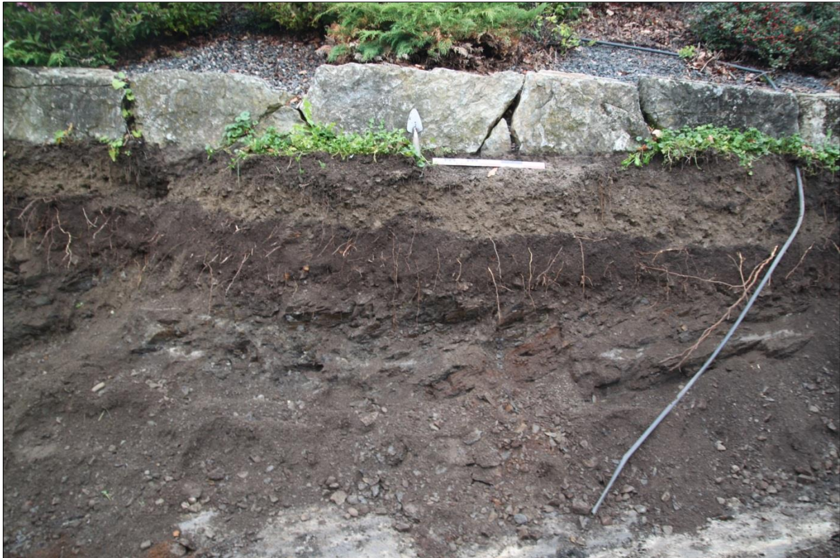
Figur 33: S-grøft: utgang underetasje til hage fra nye V-tilbygg. Midtre mot østre del av N-profil. Mot N. Foto-nr: Cf53321_NIKU_0071
