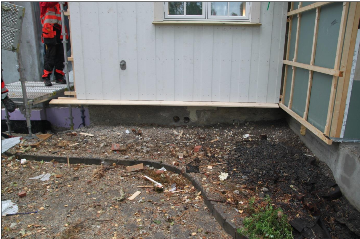
Figur 39: Østre del av N-dreneringsgrøft før graving. Mot S. Foto-nr: Cf53321_NIKU_0136
