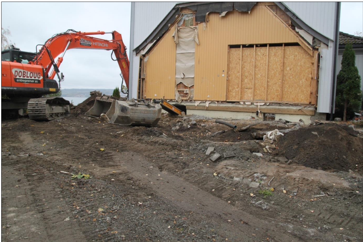
Figur 20: Ø-tilbygg: oversiktsfoto før graving nedover i massene. Søndre dreneringsgrøft ved gravemaskinen. Mot S-SØ. Foto-nr: Cf53321_NIKU_0078
