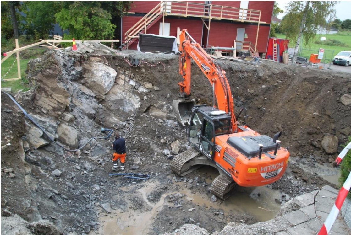
Figur 17: V-tilbygg: byggegrop tilnærmet ferdig utgravd. Undergrunn bestående av gul, leirholdig kvabb, skifrig berg og fjell i undergrunnen (nedre lag). Grunnvannsspeilet var oppe i dagen. Mot V. Foto-nr: Cf53321_NIKU_0058
