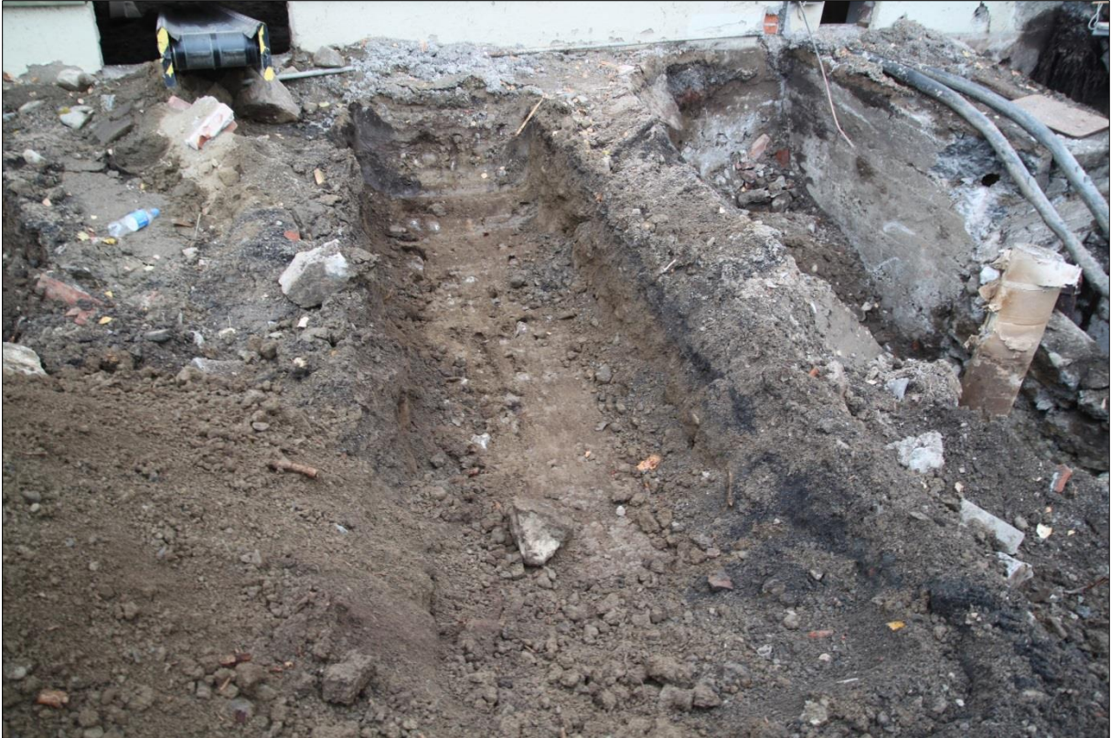
Figur 21: Ø-tilbygg: midtre del av byggegrop. Liten prøvesjakt gravd ca. 25 cm ned. Kun nyere og omrotete masser. Mot V. Foto av HRA. Foto-nr: Cf53321_NIKU_0001
