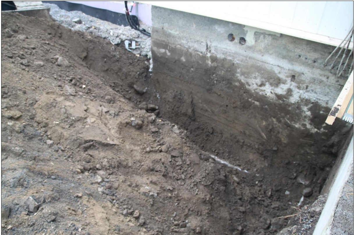
Figur 40: Østre del av N-dreneringsgrøft ferdig utgravd. Mot SØ. Foto-nr: Cf53321_NIKU_0137
