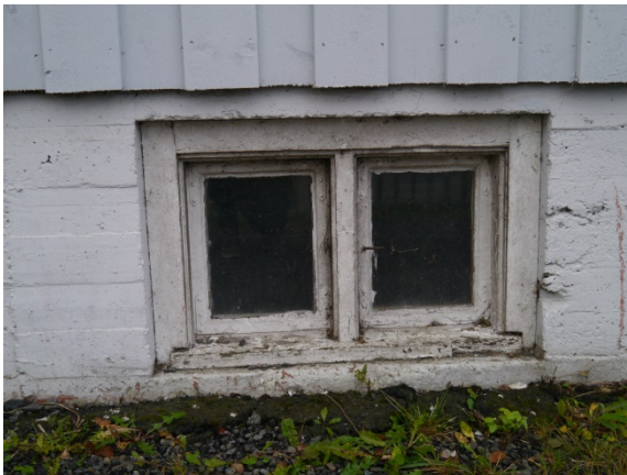
Skårerveien 77, kjellervindu. Foto: Siv Leden, NIKU 2016.
