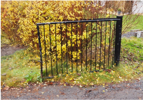
Skårerveien 61, grind. Foto: Bjørn Johansen, NIKU 2016.
