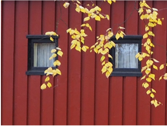
Trygves vei 2, opprinnelige vinduer. Foto: Bjørn Johansen, NIKU 2016.
