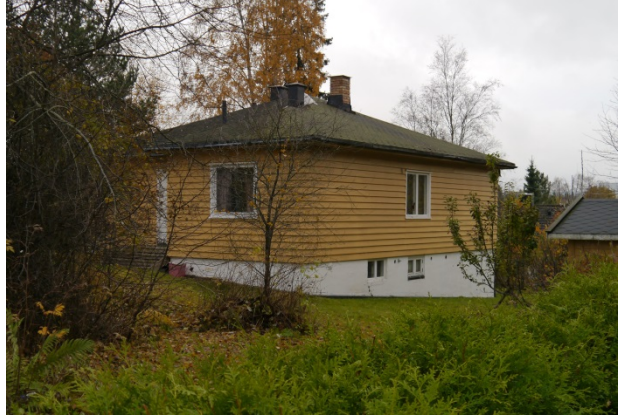
Blåkkollveien 2 sett fra nord. Foto: Siv Leden, NIKU 2016.
