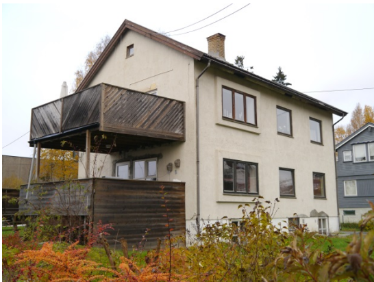
Skårerveien 69 sett fra gate. Foto: Siv Leden, NIKU 2016.
