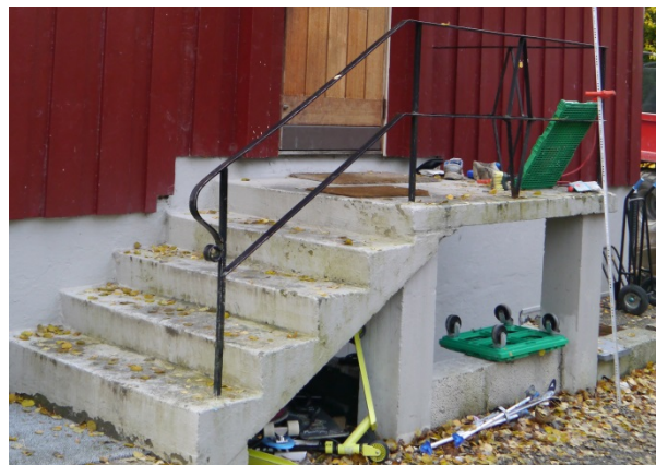
Skårerveien 65, betongtrapp. Foto: Siv Leden, NIKU 2016.
