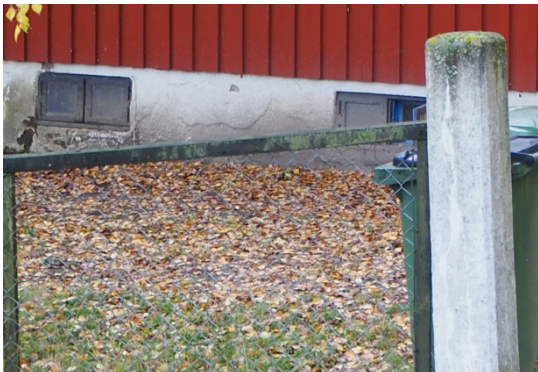
Trygves vei 2, grindstolpe av støpt betong og nettinggjerde. Kjellervinduene er bevart fra byggeåret. Foto: Bjørn Johansen, NIKU 2016.
