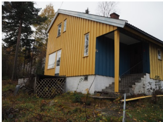
Ringveien 17 sett fra sørøst. Foto: Bjørn Johansen, NIKU 2016.
