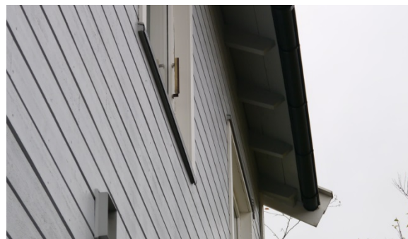
Torbjørns vei 20, taksperrer. Foto: Siv Leden, NIKU 2016.
