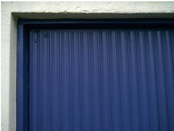
Ringveien 9, garasjeport. Foto: Siv Leden, NIKU 2016.
