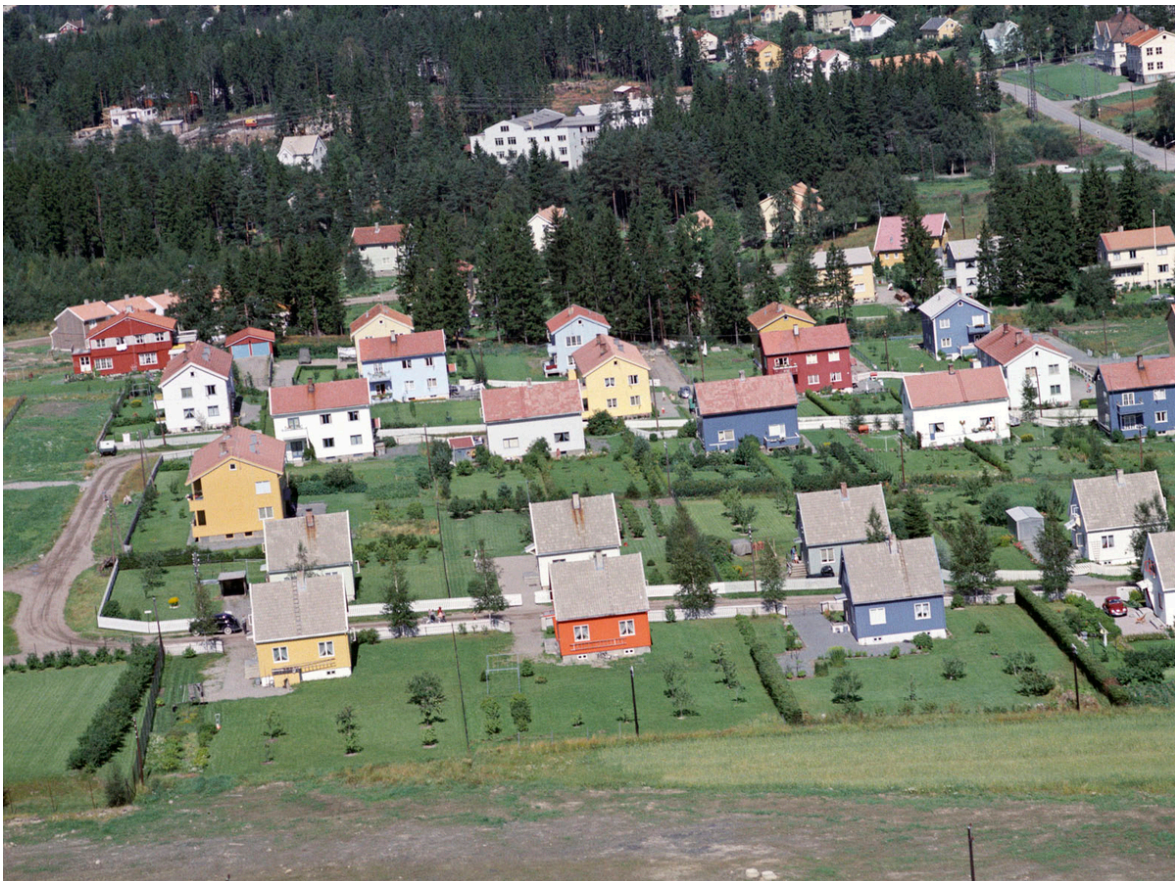
Flyfoto Rolvsrud – Trygves vei, Tormods vei, 1961. Kilde: Lørenskog kommune.
