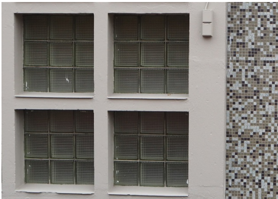
Lørdagsrudveien 24, glassbyggsten og fasademosaikk. Foto: Bjørn Johansen, NIKU 2016.
