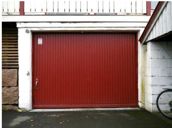
Ringveien 9, garasjeport. Foto: Siv Leden, NIKU 2016.
