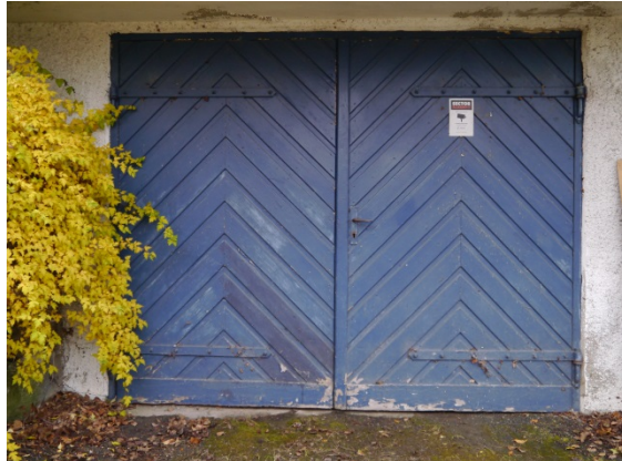
Ringveien 7, garasjeport. Foto: Siv Leden, NIKU 2016.
