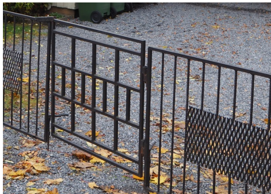
Ringveien 20, grind. Foto: Bjørn Johansen, NIKU 2016
