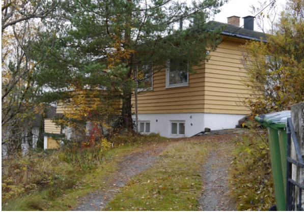
Blåkkollveien 2 sett fra øst. Foto: Siv Leden, NIKU 2016.
