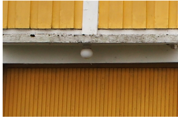
Skårerveien 57, betongbaldakin og armatur over garasjeport. Foto: Bjørn Johansen, NIKU 2016.
