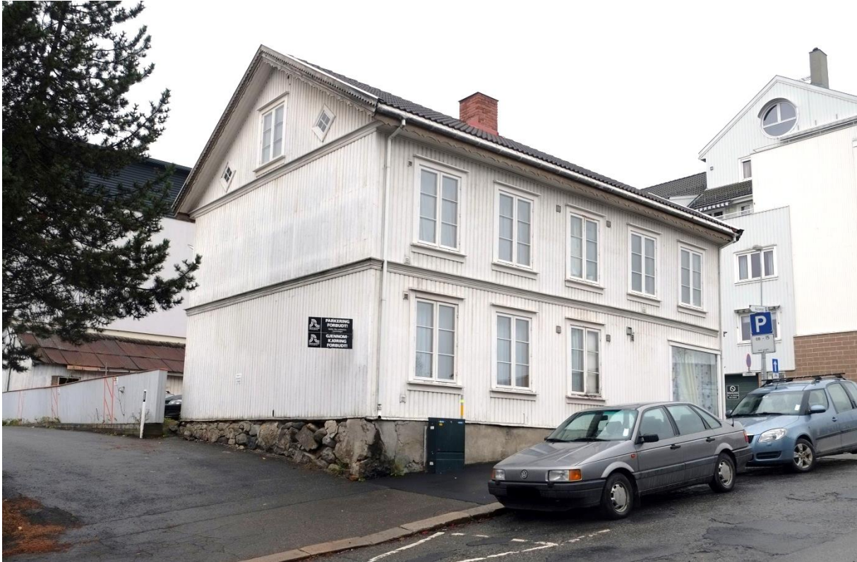
Hovedbygningen i Skolegata 8 ligger med langfasaden ut mot Bassengvegen. Bak plankegjerdet til venstre ses pulttaket på bakgårdsbygningen. Foto: Siv Leden, NIKU 2017.
