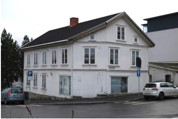
Fasade sett fra krysset Bassengvegen/Skolegata.
