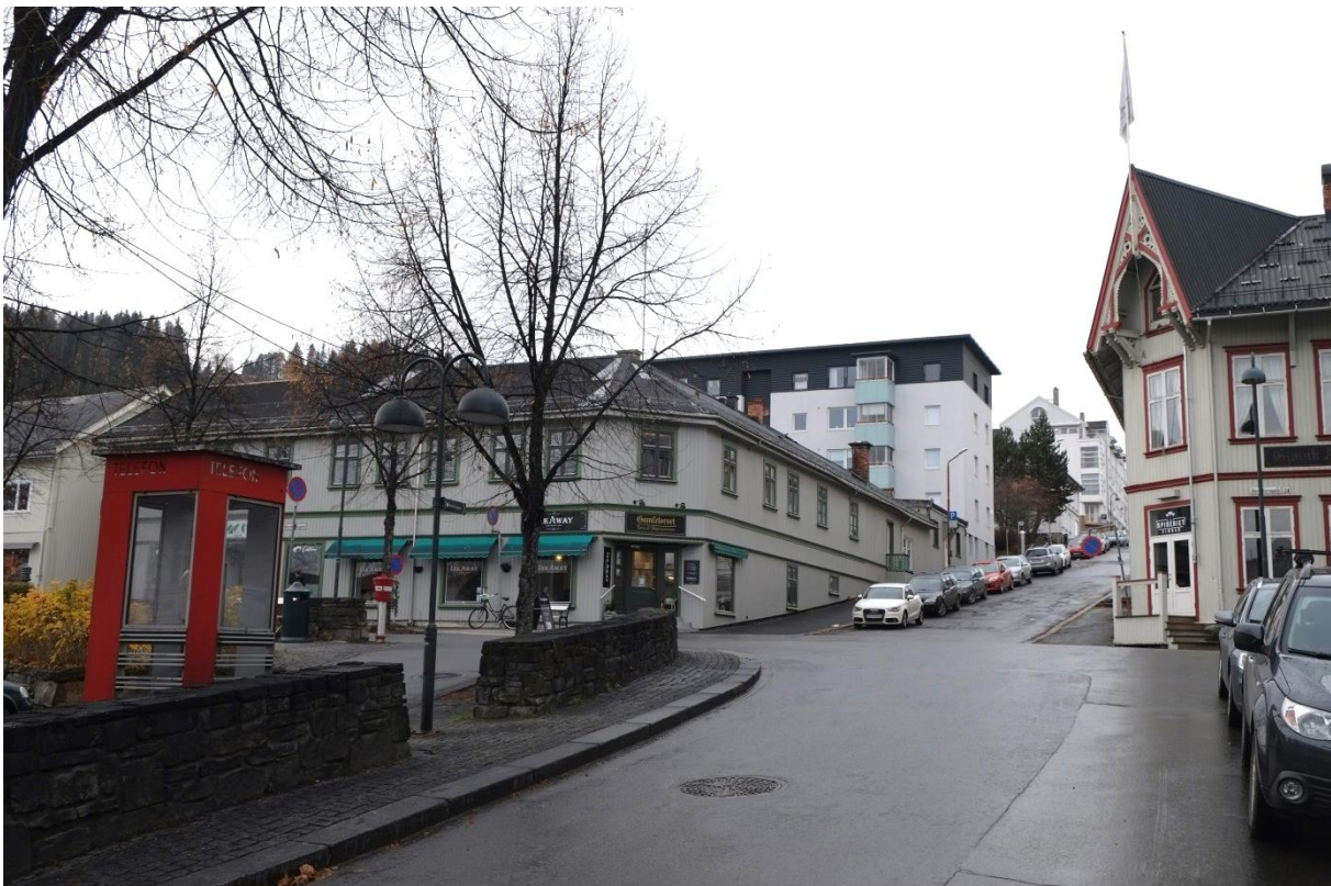
Sikten fra Gamletorget oppover Bassengveien har beholdt mye av sitt gamle preg. Skoleveien 8 som ligger delvis skjult bak furua midt i bakken på venstre side, er en historisk referanse langs gateløpet sammen med de bevarte tregårdene rundt torget og gården i Hans Mustads gate 2 lengre opp. Boligblokka (Skolegata 10 A-B-C) som ble bygget rundt 1960, er høyere enn bygningen som er avbildet på fotoet fra 1940, men fordi den ligger lavere i terrenget, nærmere Torvet, framstår den likevel med omtrent samme høyde som bygningen på bildet over. Blokka på oversiden av Skolegata 8 (Bassengvegen 6) erstatter en eldre bygning som også var vesentlig høyere enn Skolegata 8. Foto: Siv Leden, NIKU 2017.
