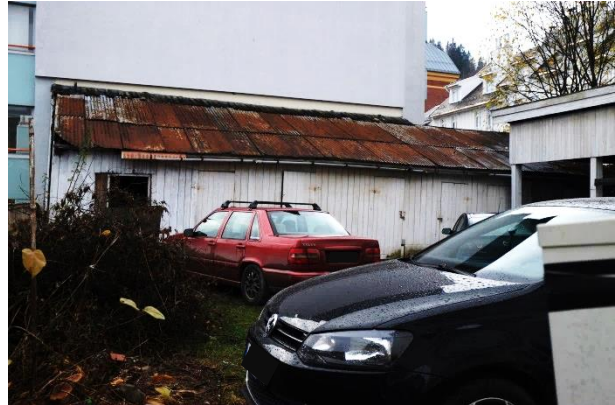
Uthuset har enkelt bølgeblikktak. Til høyre ses nyere uthus/ carport.
