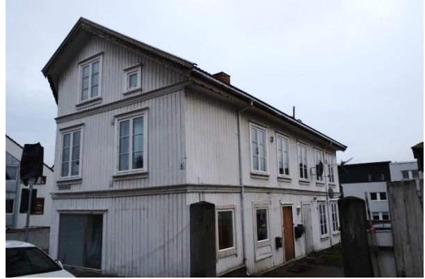
Fasade sett fra Skolegata.
