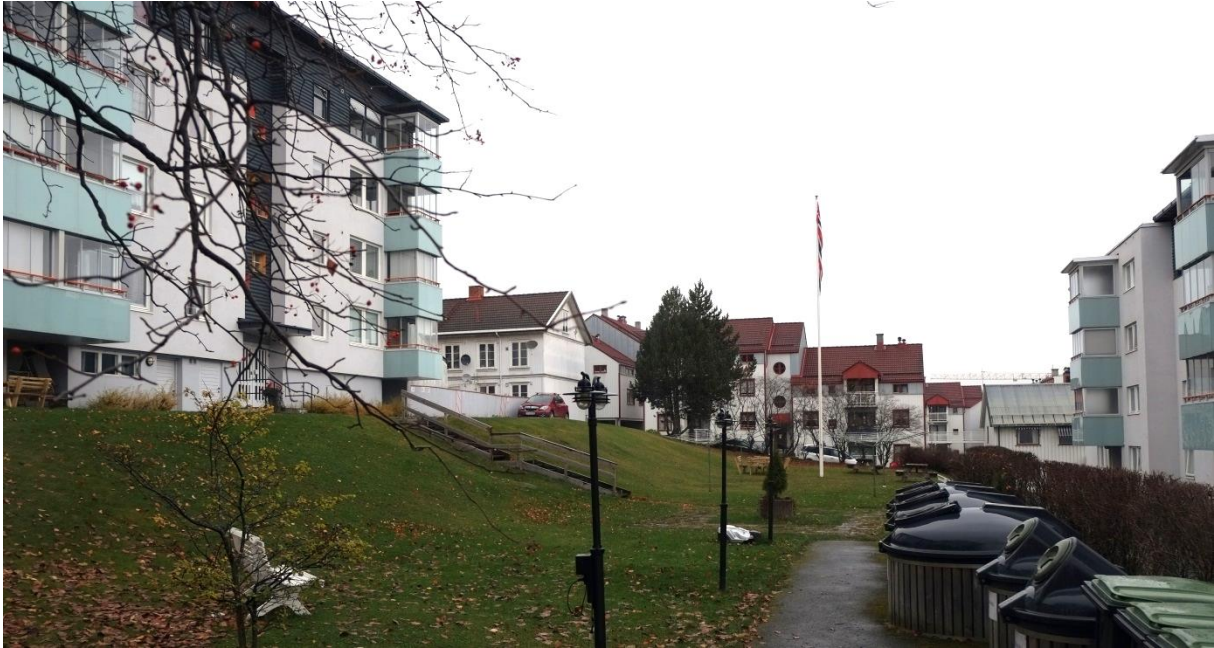
De to blokkene med adresse Skolegata 10 er bygget rundt 1960. De er i fire etasjer pluss sokkeletasje. Skolegata 8 ses til venstre midt i bildet. Foto: Siv Leden, NIKU 2017.
