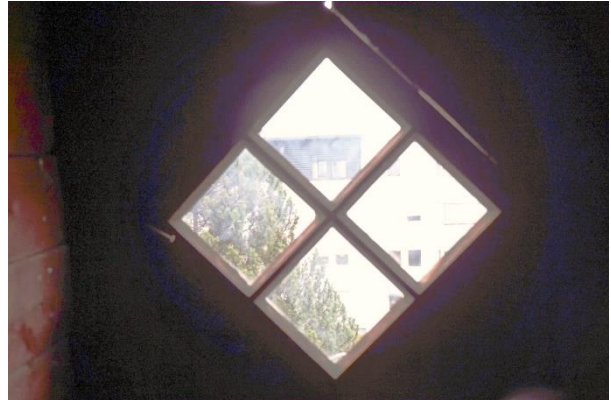
Loftsvindu i kott på loft, sett innenfra.
