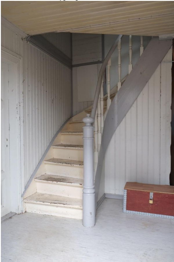
Trappeoppgang 1. etasje med eldre paneler og dører.
