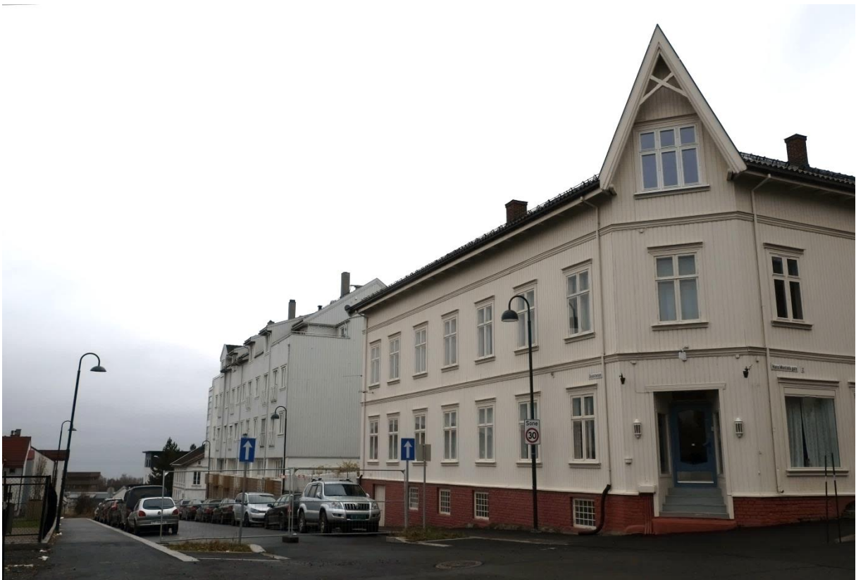
Bassengvegen sett i retning mot Gamletorvet og Mjøsa. I forgrunnen til høyre Hans Mustads gate 2 som er en eldre tregård i to etasjer med sokkel-etasje og loft. Ved siden av denne ligger en nyere boligblokk i Bassengvegen 6. Bortenfor denne ses hovedbygningen i Skolegata 8. Foto: Siv Leden, NIKU 2017.
