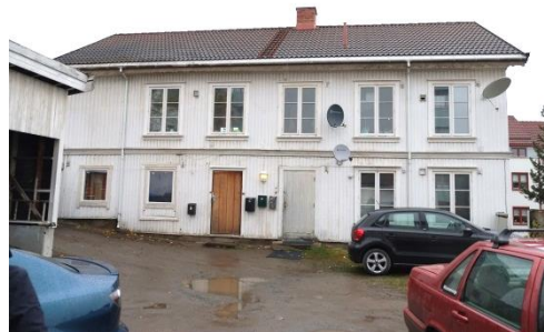
Hovedbygning sett fra bakgården.
