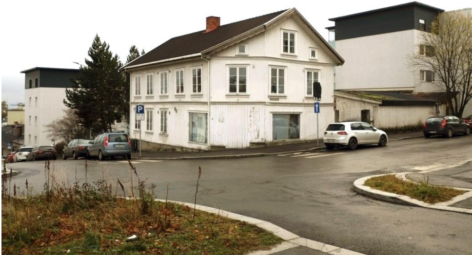
Selv om Skolegata 8 bare har to etasjer mot naboblokkenes fire, fremstår den ikke som så mye lavere enn disse sett fra Bassengvegen på oversiden. Foto: Siv Leden, NIKU 2017.
