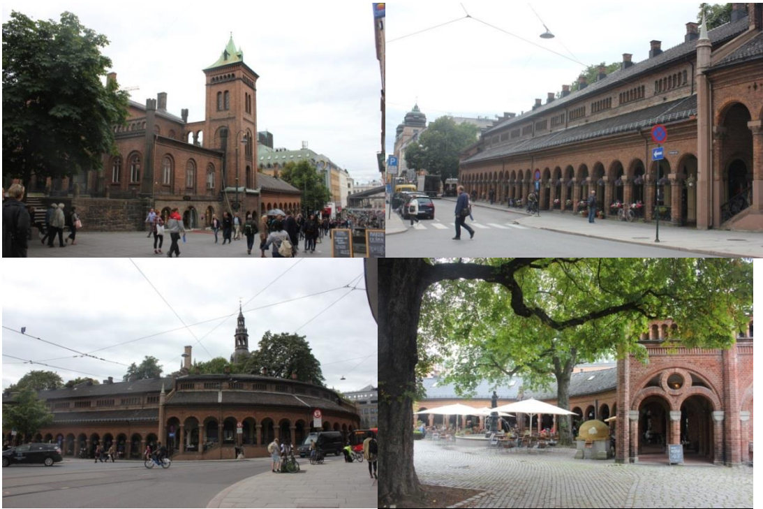
Figur 2-7 2.7 Basarene ved Kirkeristen (Dronningens gate 27)
