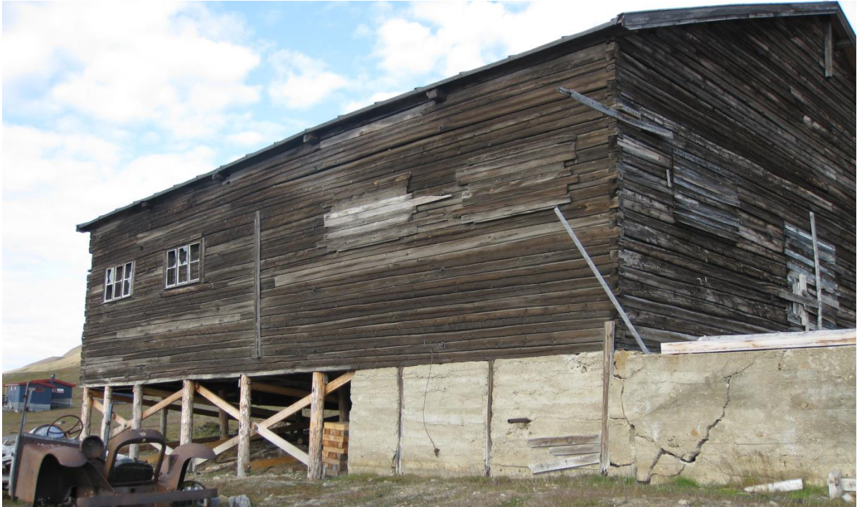
Figur 21: Smia, på Sysselemannens kart kalt A, lager, maskinverksted. Denne står i dag tom og er ikke i bruk. Foto: NIKU/A.C. Flyen
