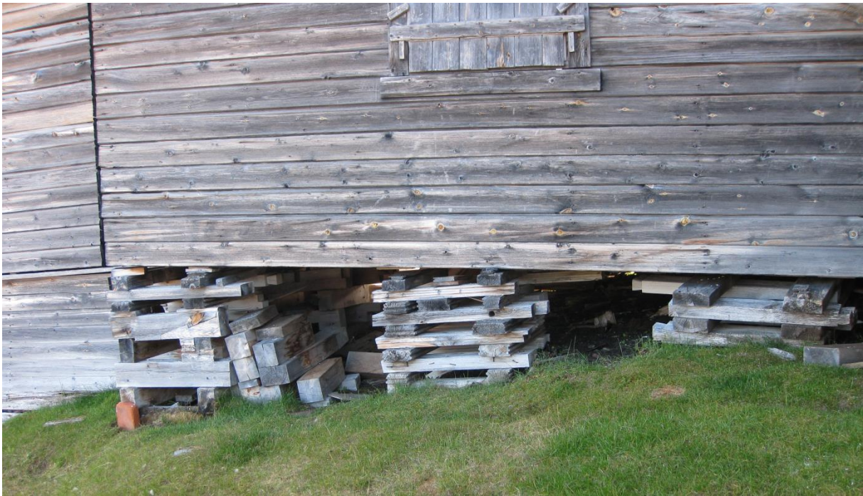
Figur 41: Svenskehuset sett fra øst, fundamentert på «pakker». Foto: NIKU/A.C. Flyen
