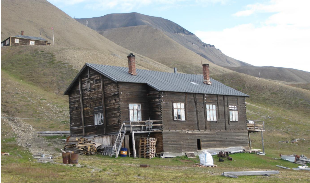
Figur 29: Gamlemessa på Hiorthamn. Bygningen står på pæler. Rommet som dannes under bygningen er dekket av liggende panel, kalt «skjørt». Skjørtet forhindrer solvarmen i å tinte grunnen under bygningen. I bakgrunnen: Funksjonærboligen. Foto: NIKU/A.C. Flyen
