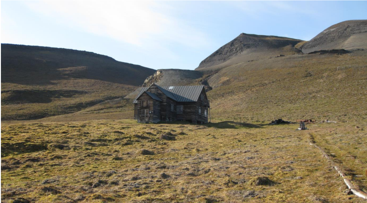
Figur 40: Svenskehuset sett fra syd. Foto: NIKU/A.C. Flyen
