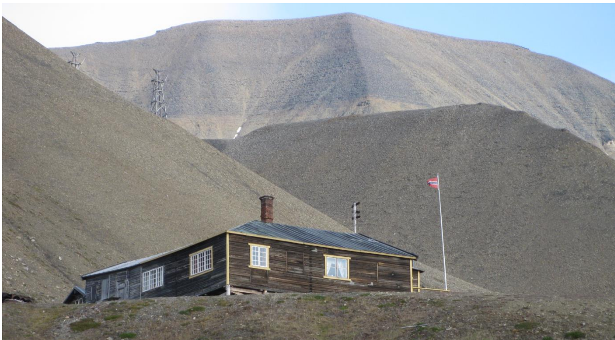
Figur 37: Funksjonærboligen, på Sysselmannens kart kalt F, administrasjon, telegraf. Funksjonærboliogen er i dag i bruk som privat hytte. I bakgrunnen sees to av taubanebukkene som førte fra gruveinngangen oppe i fjellet og ned til sjøen. Foto: NIKU/A.C. Flyen
