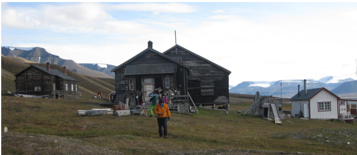
Figur 26: I forkant, midt på bildet ligger Boligbrakke, på Sysselemannens kart kalt C. I bakkant til venstre i bildet ligger Gamlemessa, på Sysselemannens kart kalt E, Stormesse, bakeri. Like til høyre for Boligbrakke C ligger den gamle sykestua, på Sysselemannens kart kalt Sykestue (D). Deler av Gamlemessa og Boligbrakka og hele Sykestua er i dag innredet til private hytter. Foto: NIKU/A.C. Flyen
