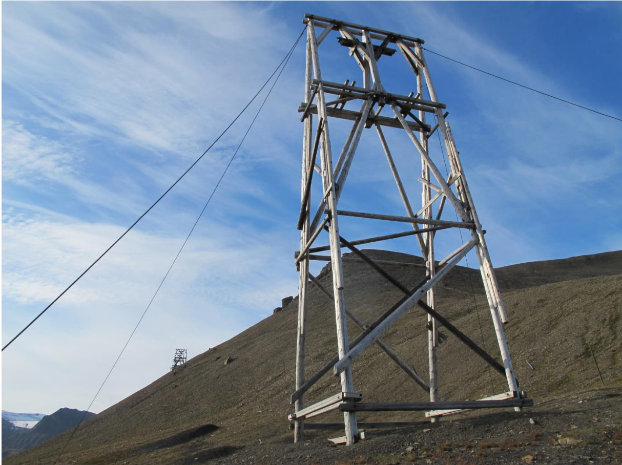
Figur 10. Den gjenoppførte taubanebukken på Skjæringa. Foto: Mycoteam AS/J. Mattsson
