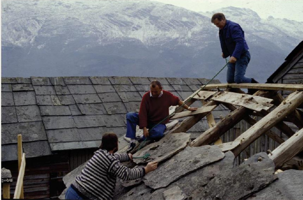
Omlegging av villskifer er en krevende og spennende oppgave. Her fra arbeid i Agatunet. Foto: Kjell Andresen © Hordaland fylkeskommune
