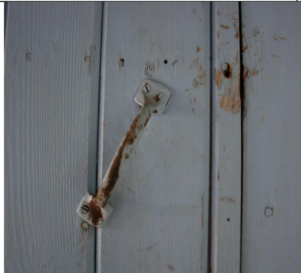
Figur 51: Detalj av håndtak på dør inn til bod i 2. etasje. Fotograf: AC Flyen/NIKU
