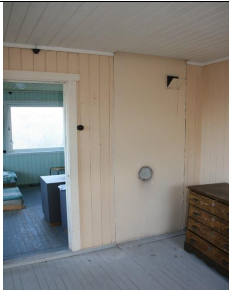
Figur 59: Soverommet i nordvest med brannmuren der det tidligere har stått en ovn. Fotograf: AC Flyen/NIKU
