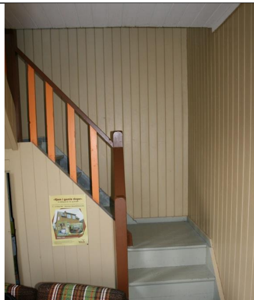
Figur 37: Vegger har malt faspanel av typen geyfus, vindu, himling og trapp med gelender opp til annen etasje er malt.. Fotograf: AC Flyen/NIKU
