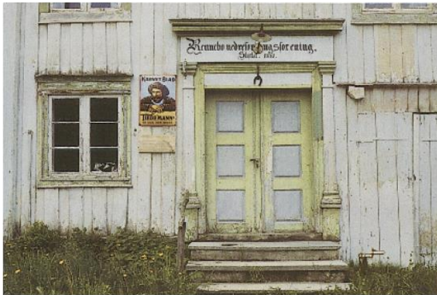
I årenes løp vil terrenget rundt huset bygge på seg, og hvis huset kanskje synker noe i tillegg vil det føre til økt fuktighet og etterhvert råteskader i panel-ender. Her må det skaves noe av gressbakken.
