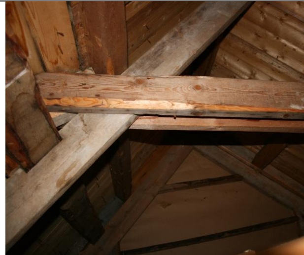
Figur 61: Det var ingen synlige tegn til skader, selv om det var en del ufarlige fuktskjolder. Loftet var luftig og fint. Fotograf: AC Flyen/NIKU
