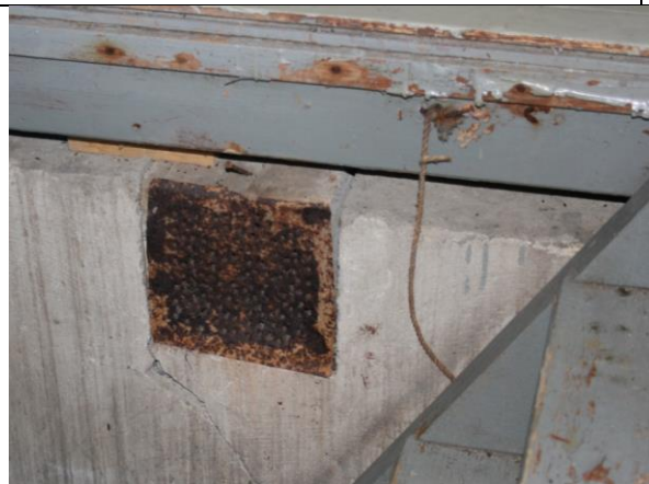
Figur 31: Kjelleren er støpt med tykke vegger og har lufteluker ut i friluft gjennom veggene. Fotograf: AC Flyen/NIKU
