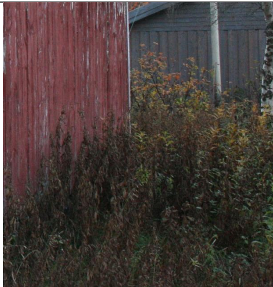
Figur 88: All begroing helt innpå husveggen holder på fuktighet og hindrer uttørring. Dette er ikke heldig for panel og veggkonstruksjon. Fotograf: AC Flyen/NIKU
