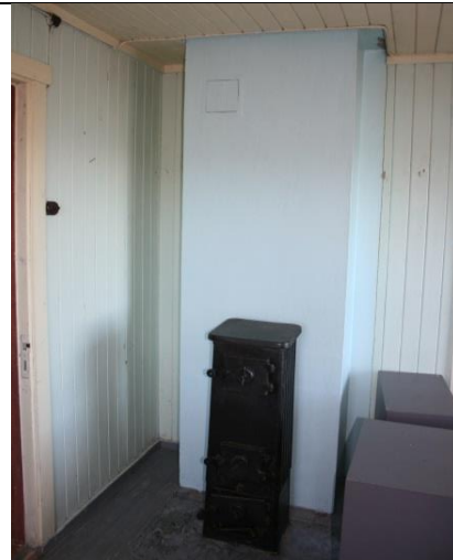
Figur 54: Ovn med brannmur i soverom mot nordøst. Fotograf: AC Flyen/NIKU
