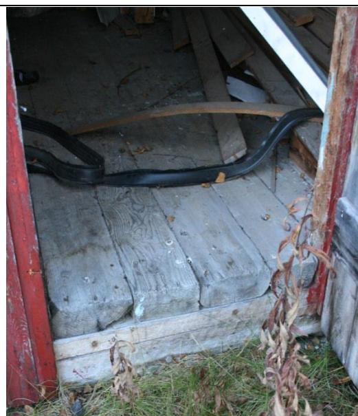
Figur 81: Gulvet hadde ingen synlige tegn til råteskader, men det kan være svekkelser i underkant. Fotograf: AC Flyen/NIKU
