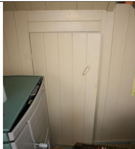
Figur 40: Under trappen opp til 2. etasje er et lite kott. Fotograf: AC Flyen/NIKU
