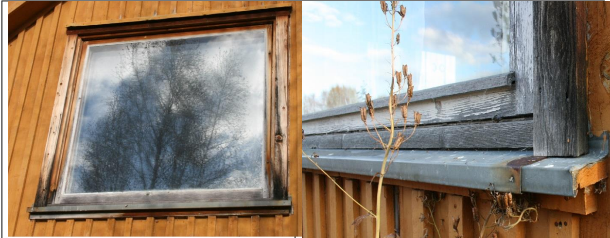
Figur 23: Vinduene står dels uten maling og dels med svært nedbrutt maling. Her 2. etasje mot øst. Fotograf: AC Flyen/NIKU
