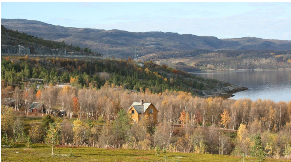
Figur 4: Nilsenhuset med uthusbygningene til venstre. Den første, provisoriske boligen er synlig mellom trærne like til venstre for Nilsenhuset. Fotoet er tatt fra terrassen på hovedbygningen til Alta museum og mot nordvest. Rafshodestua ligger i bakkant av uthusbygningene, og er ikke synlige på dette fotoet. Fotograf: AC Flyen/NIKU
