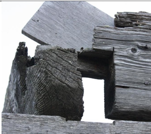
Figur 97: Råteskader i hjørnet mot sydøst på tømmerkonstruksjonen. Fotograf: AC Flyen/NIKU
