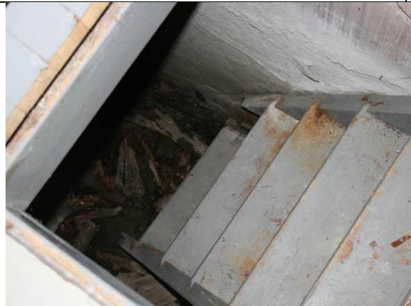
Figur 29: Nedre del av trappen er helt nedbrutt av råte. Fotograf: AC Flyen/NIKU
