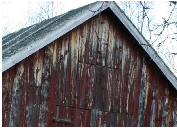
Figur 86: Panelet er malingsslitt og stedvis oppsprukket, her i vestveggen. Fotograf: AC Flyen/NIKU
