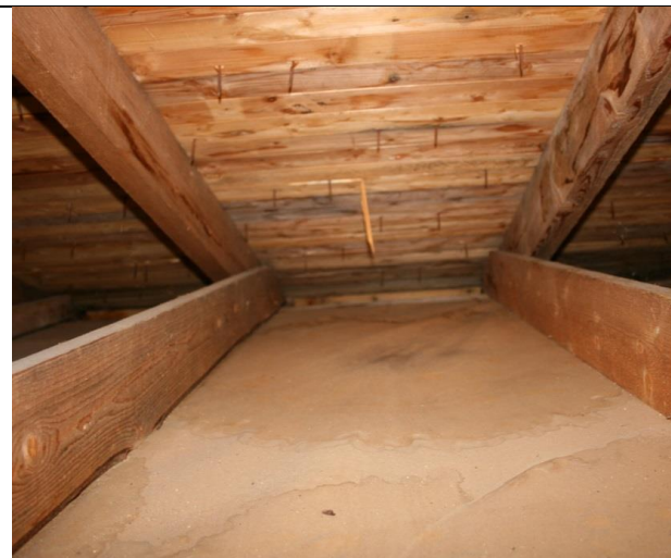
Figur 63: Undertaket sett inn mot takfoten. Fotograf: AC Flyen/NIKU
