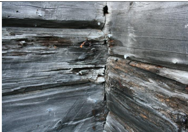
Figur 97: Råteskader i hjørnet mot sydøst på tømmerkonstruksjonen. Fotograf: AC Flyen/NIKU
