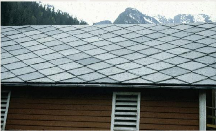
Ruteheller i Odda i Hardanger. Rutehellene er teknisk sett den mest perfekte form for helletekking. Foto: Kjell Andresen © Hordaland fylkeskommune
