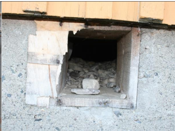
Figur 32: Kjelleren er støpt med tykke vegger og har lufteluker ut i friluft gjennom veggene. Fotograf: AC Flyen/NIKU
