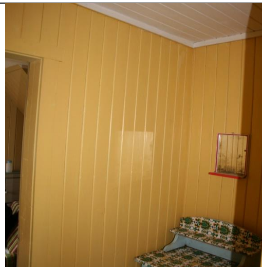
Figur 42: Den lille gangen mellom entre og kjøkken har også malt faspanel, malt himling og belegg på gulvet. Fotograf: AC Flyen/NIKU
