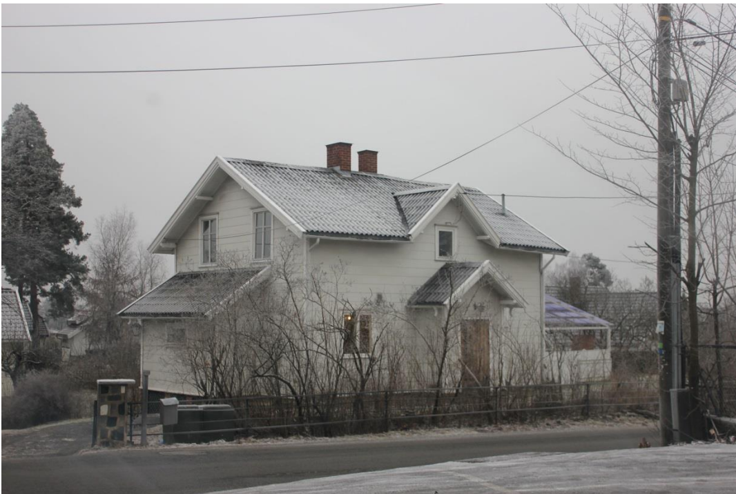
Figur 18 Kleivveien 10, foto: NIKU
