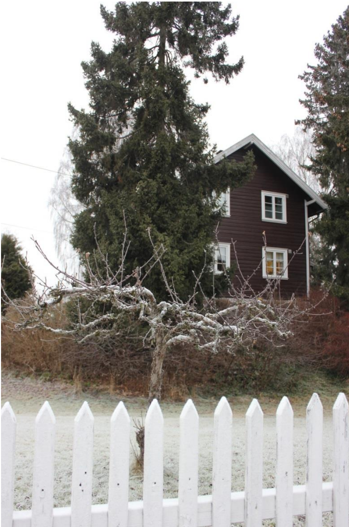
Figur 13 Fasade øst, foto: NIKU
