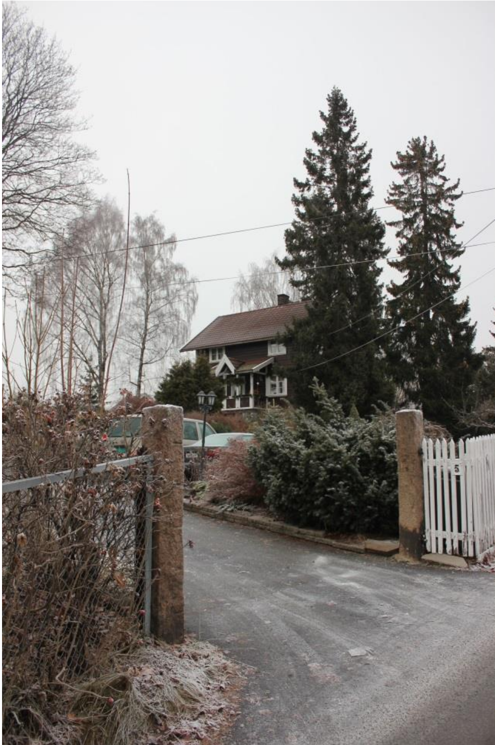
Figur 6 Kleivveien 5, foto: NIKU
