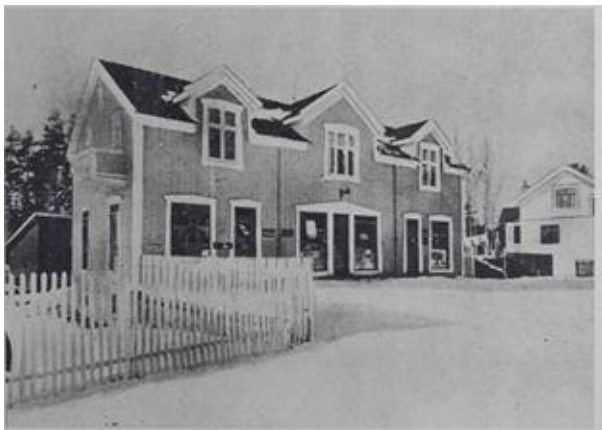
Figur 25 Gamle Ringeriksvei 30, ca. 1916, foto: Stabekk – en historikk
