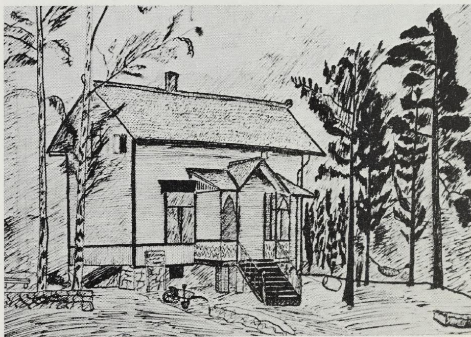
Skreddermester Simonsens hus i Gamle Ringeriksvei 35 tegnet av Melvin Simonsen i 1915.
