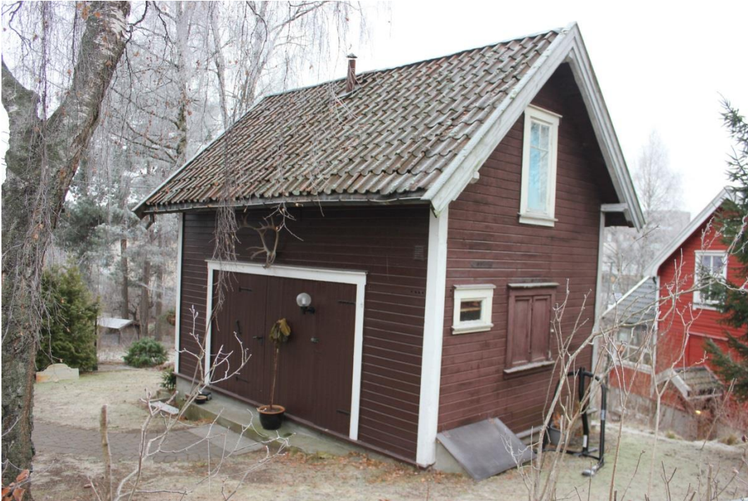
Figur 10 Uthus fasade øst og nord, foto: NIKU
