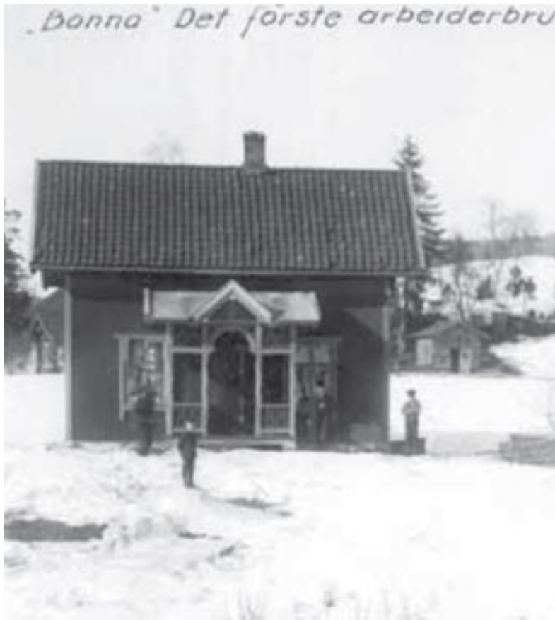
Figur 34 En tidlig Egne Hjem-modell i 1 1/2 etasje. Merk prydgavl. Foto fra «Rik på historie – et riss av kulturhistoriens fysiske spor i Bærum», Bærum kommune 2012
