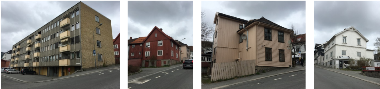
Eksempler på sentrumsbebyggelse i bratt terreng. Foto: NIKU 2017.
