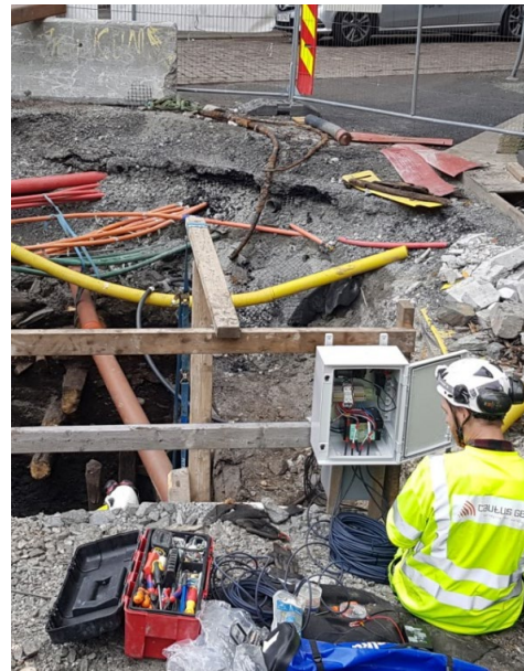
e) Installasjon midlertidig strømforsyning
