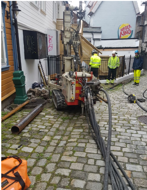
a) Borerigg og sensor installasjon
