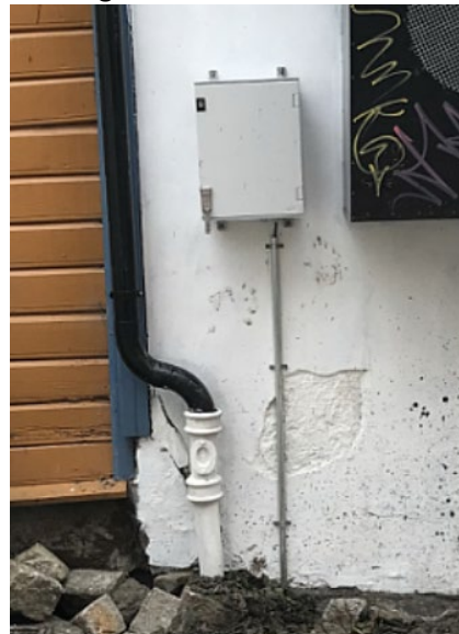
d) Ferdig montert installasjon
