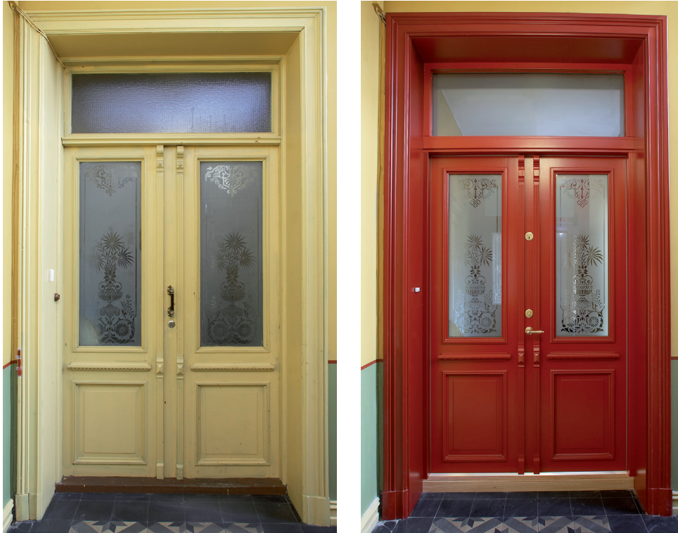
Figur 3.1 (venstre): Eksempel på bytte fra opprinnelig dør til brannklassifisert kopidør. Figuren viser den opprinnelige dørens sett fra trapperommet. Foto: Jønna Brug AS, 2007.
