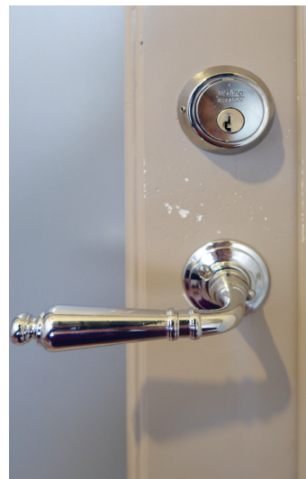
Figur 2.3 Detaljfoto av nytt håndtak på dør til høyre. Håndtaket er tidsriktig, men ligner ikke på det opprinnelige. Opprinnelig anslagslist er byttet ut med en enklere list. Foto: Barbro Wedvik, NIKU, 2017. Figure 2.3: Detail photo of the new handle on the right door. The handle is contemporary in its style and has little in common with the original astragal was replaced with a less elaborate one. Photo: Barbro Wedvik, NIKU, 2017.
