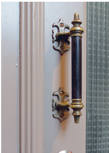
Figur 2.2: Detaljfoto av opprinnelig håndtak i sandstøpt messing og ibenholt og opprinnelig profilert anslagslist på dør til venstre. Foto: Barbro Wedvik, NIKU 2017. Figure 2.2: Detail photo of the original brass and ebony door handle and the astragal molding on the left door. Photo: Barbro Wedvik NIKU, 2017.
