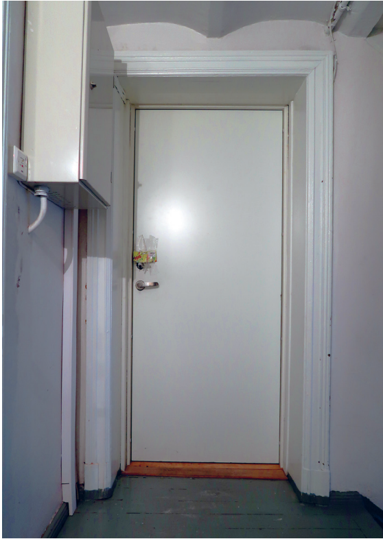
Figur 4.1: Eksempel på bytte fra ukjent originaldør til brannklassifisert enkel standarddør, sett fra trapperommet. Foto: Barbro Wedvik NIKU, 2017.
