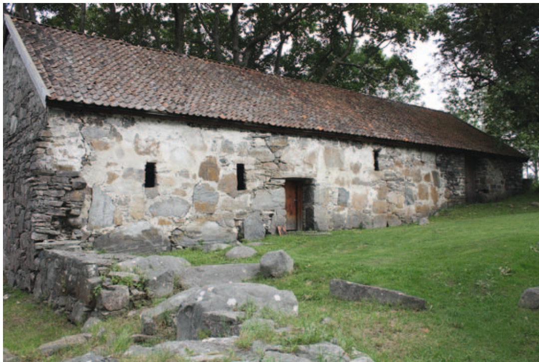
FIGUR 9. Ytre vestre bygningsfløy med inngang til det som var "bryggerhuset". FOTO MOT NORDVEST: RM 2009.
