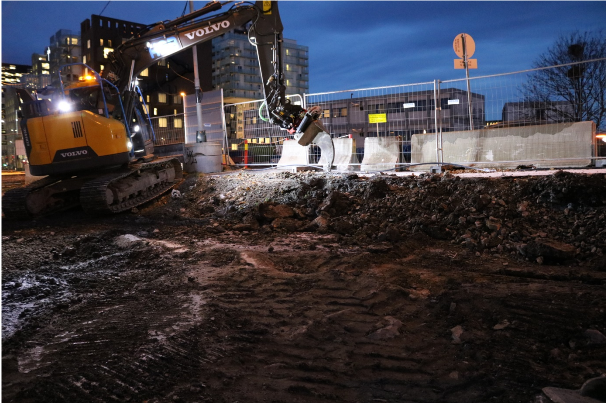
Figur 3: Arbeidsbilde. Fjerning av asfalt ved Bispegata, område A. Sett mot nordvest. Foto-nr: Cf35170_NIKU_0038.
