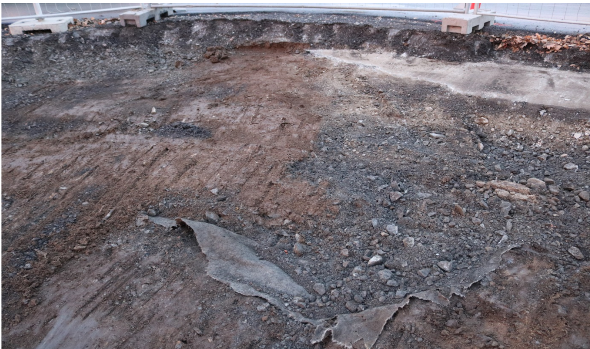
Figur 4: Veiduk under påfylte masser, område A. Foto-nr: Cf35170_NIKU_0053.
