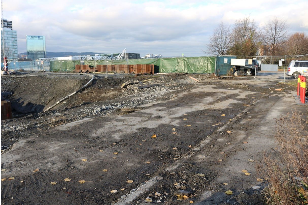
Figur 8: Område B etter graving. Sett mot nord. Foto-nr: Cf35170_NIKU_0010.
