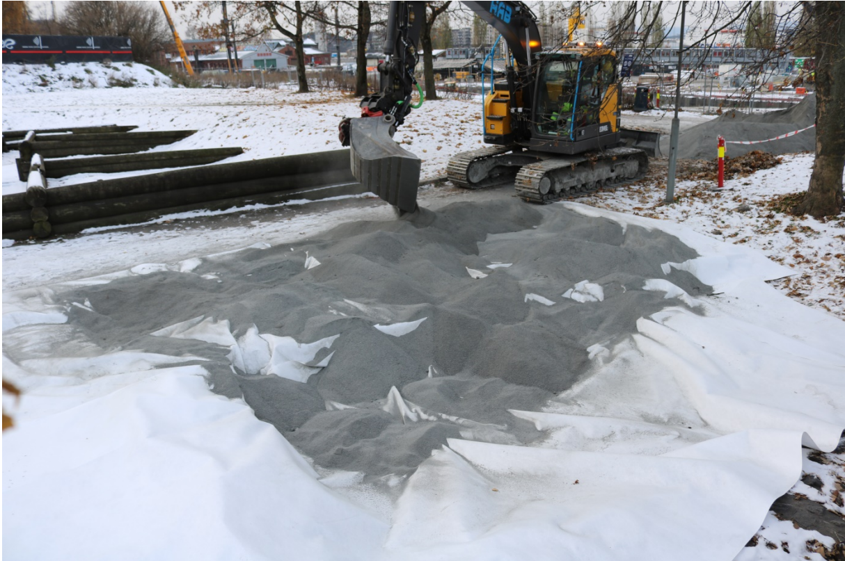
Figur 2: Arbeidsbilde. Ruinen, K2, på område E dekkes til med veiduk og pukk. Sett mot sørvest. Foto-nr: Cf35170_NIKU_0021.
