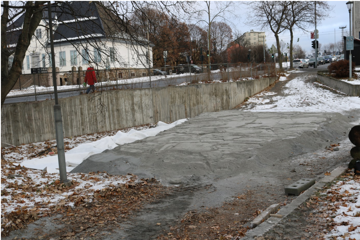
Figur 10: Område E. Ruinen etter tildekking. Området rett over muren har 50 cm grus over seg. Sett mot øst-nordøst. Foto-nr: Cf35170_NIKU_0033.
