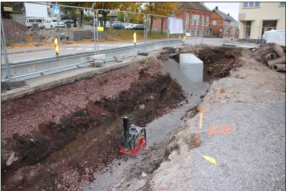
Figur 15. Nordøstre del i VA-grøft mot Tollbodgaten. Sett mot nord. Cf35153_NIKU_580447.
