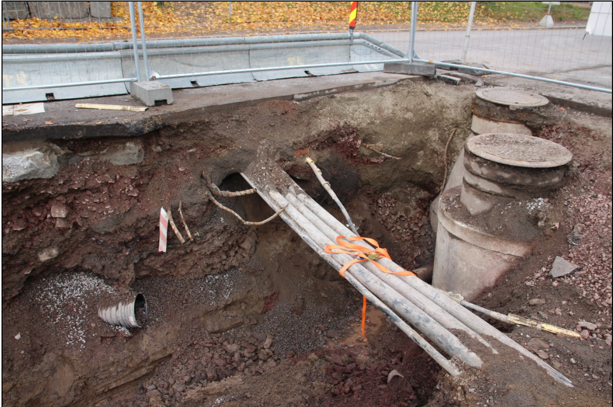
Figur 16. Nordøstre del i VA-grøft mot Tollbodgaten. Moderne kummer, rør og elektriske ledninger. Sett mot nordvest. Cf35153_NIKU_580465.
