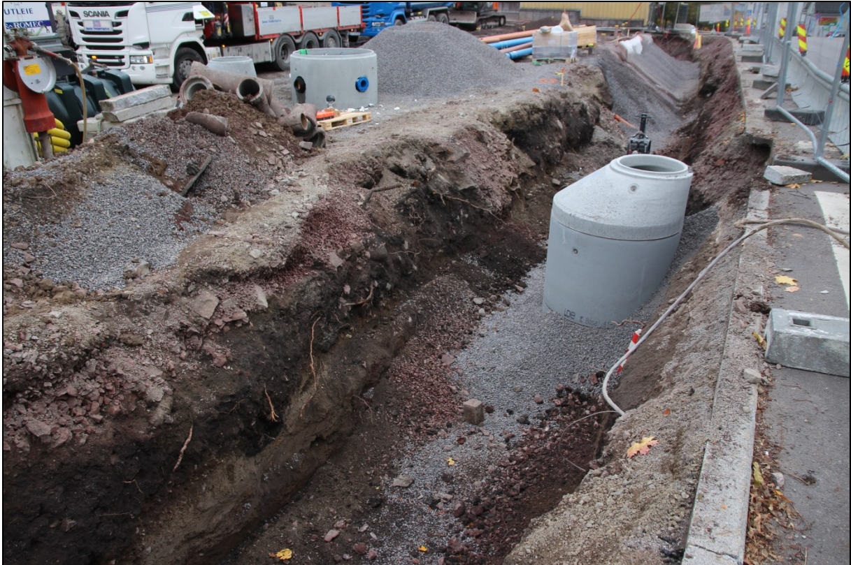
Figur 14. Nordøstre del i VA-grøft mot Baglergaten 2 tomten. Sett mot syd. Cf35153_NIKU_580435.
