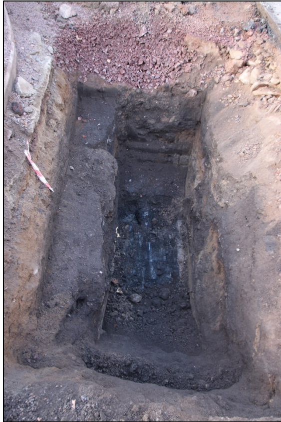
Figur 18. Brannhydrantgrøft i Baglergaten 2. Sett mot NV. Cf35153_NIKU_580479.
