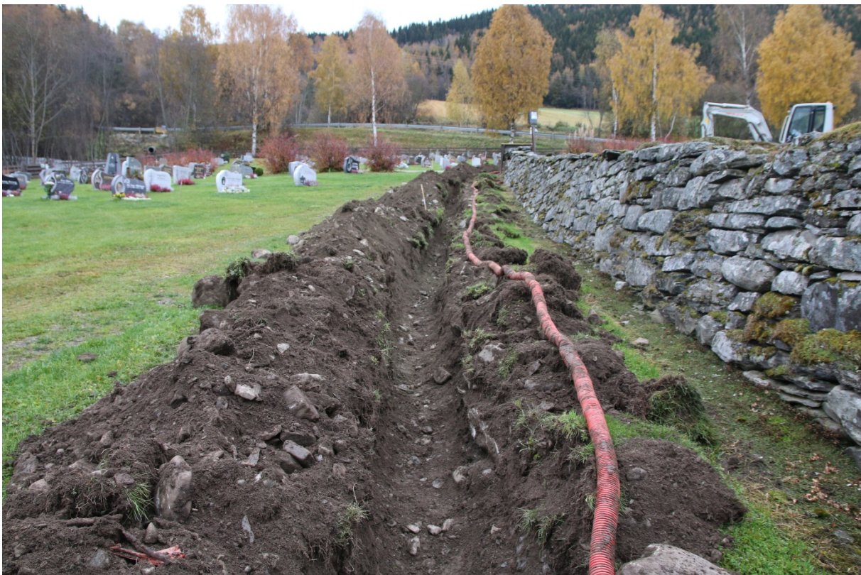
Figur 2: Grøft fra eksisterende kameraposisjon 3 mot gangsti. Hull til nytt kamerafundament ble gravd om lag midt i grøfta. Sett mot øst. Foto-nr: Cf35159_NIKU_0008.
