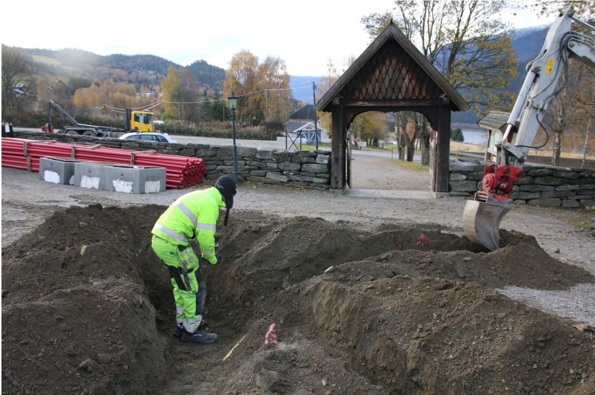
Figur 9: Graving av grop for kum i krysset. Sett mot S. Cf35159_NIKU_0071.
