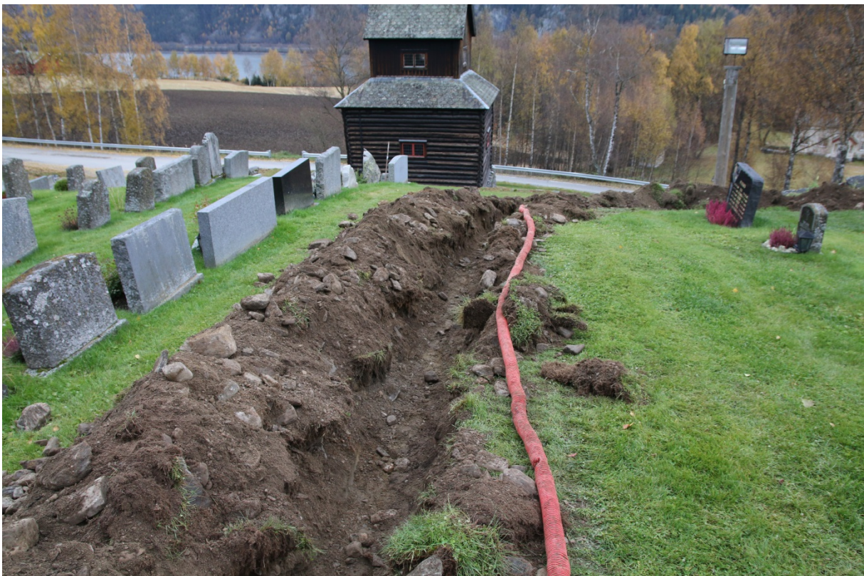
Figur 5: Grøft ved kameraposisjon 2 og mot kirka. Sett mot SV. Foto-nr: Cf35159_NIKU_0036.
