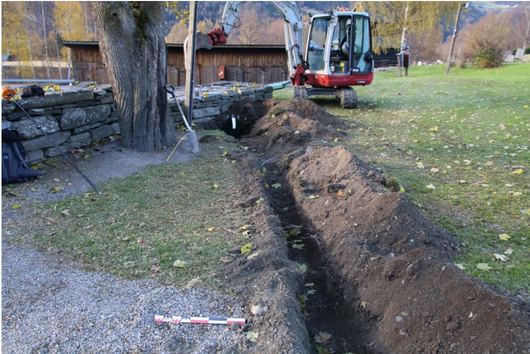
Figur 16: Ny grøft mot kameraposisjon 1. Sett mot V. Foto-nr: Cf35159_NIKU_0082.
