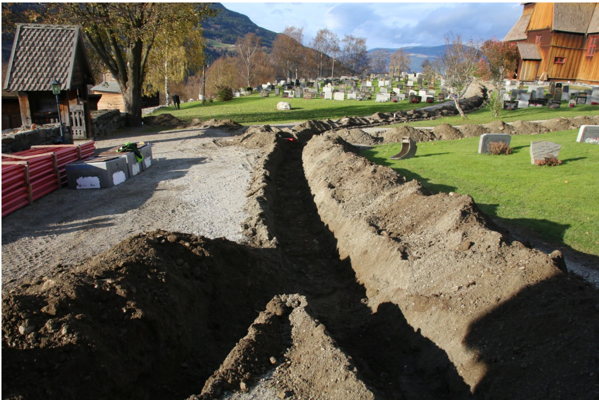
Figur 11: Ferdig gravd grøfter, oversikt søndre del av kirkegården. Sett mot NV. Foto nr: Cf35159_NIKU_0087.
