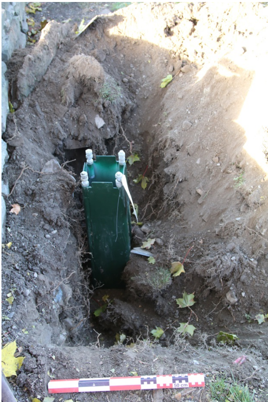
Figur 8: Fundament til kamera, posisjon 1. Sett mot V. Foto nr: Cf35159_NIKU_0073.
