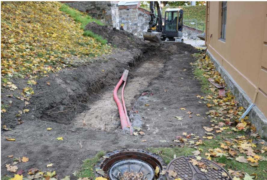
Figur 3: Sjakten langs den nordre veggen til Corps du Garde. Foto-nr: Cf35158_NIKU_0009.
