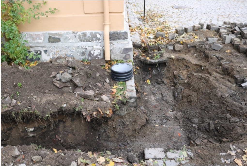
Figur 6: Sjakt langs den vestre veggen til Corps de Garde og inn til eksisterende kum ved det sørvestre hushjørnet. Foto-nr: Cf35158_NIKU_0030.
