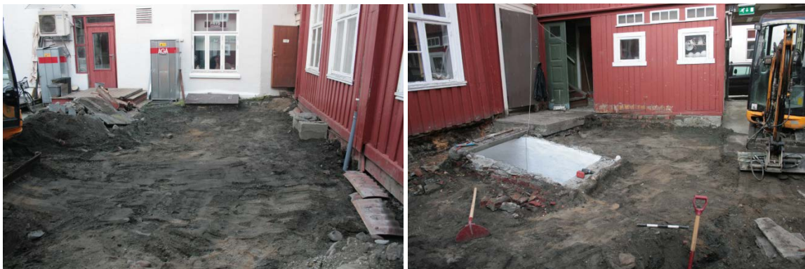
Figur 6. Ferdig gravd membranområde. Til venstre; øst for nedgang til hvelvkjelleren (sett mot ØNØ). Til høyre; vest for nedgang til hvelvkjelleren (sett mot VSV). Da_61144_011 og Da_61144_012.
