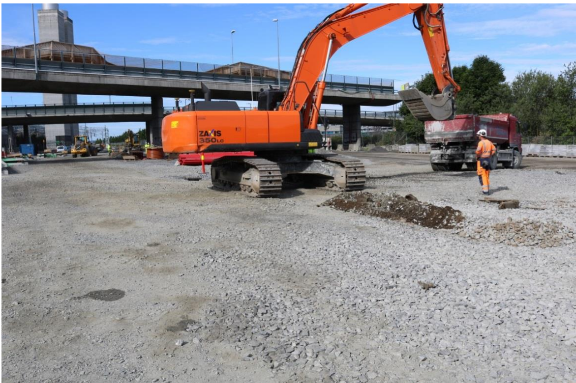
Figur 5: Sjakt i område 2 (jfr. Figur 2) ved KL-fundament punkt 14 før gravearbeidet startet. Gravemaskinen står på linjen til sjakten i område 2. Sett mot vest. Foto: Cf35145_NIKU_0050.
