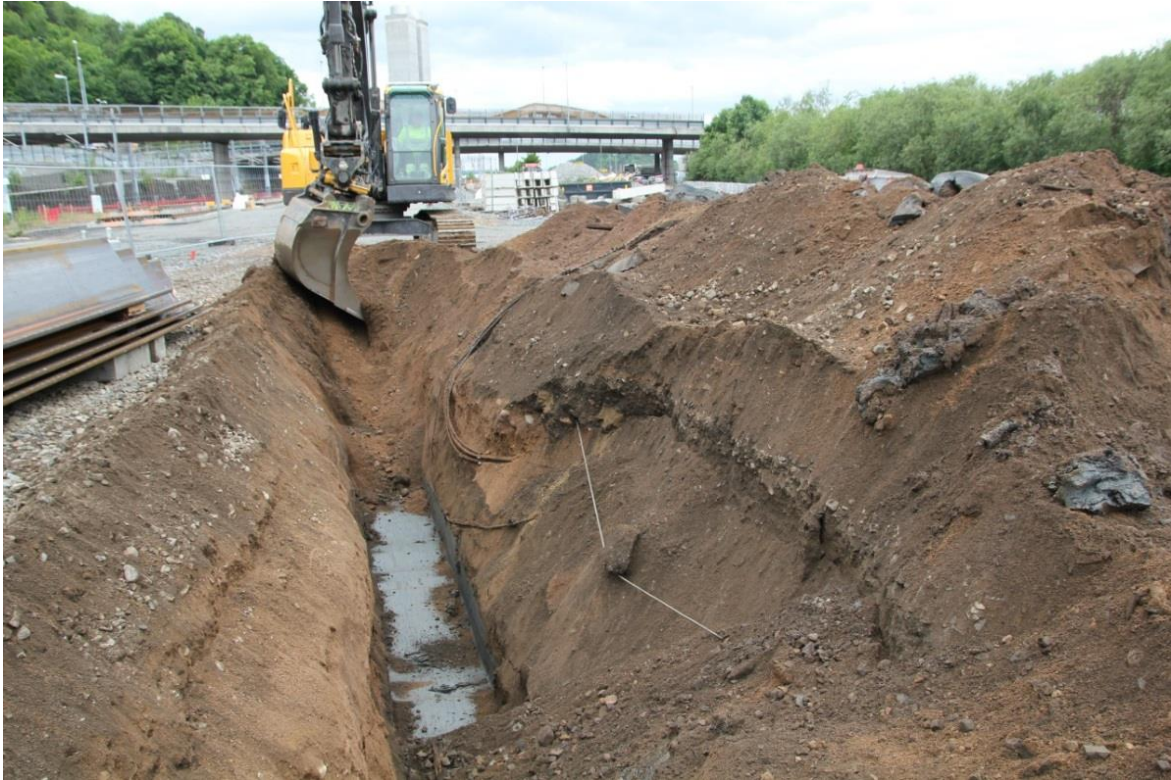
Figur 4: Sjakt i område 2 (jfr. Figur 2) i prosjekt 1020830, gravd sørover mot og mellom KL-fundamentene. Sett mot sørvest. Foto: Cf35145_NIKU_0097.
