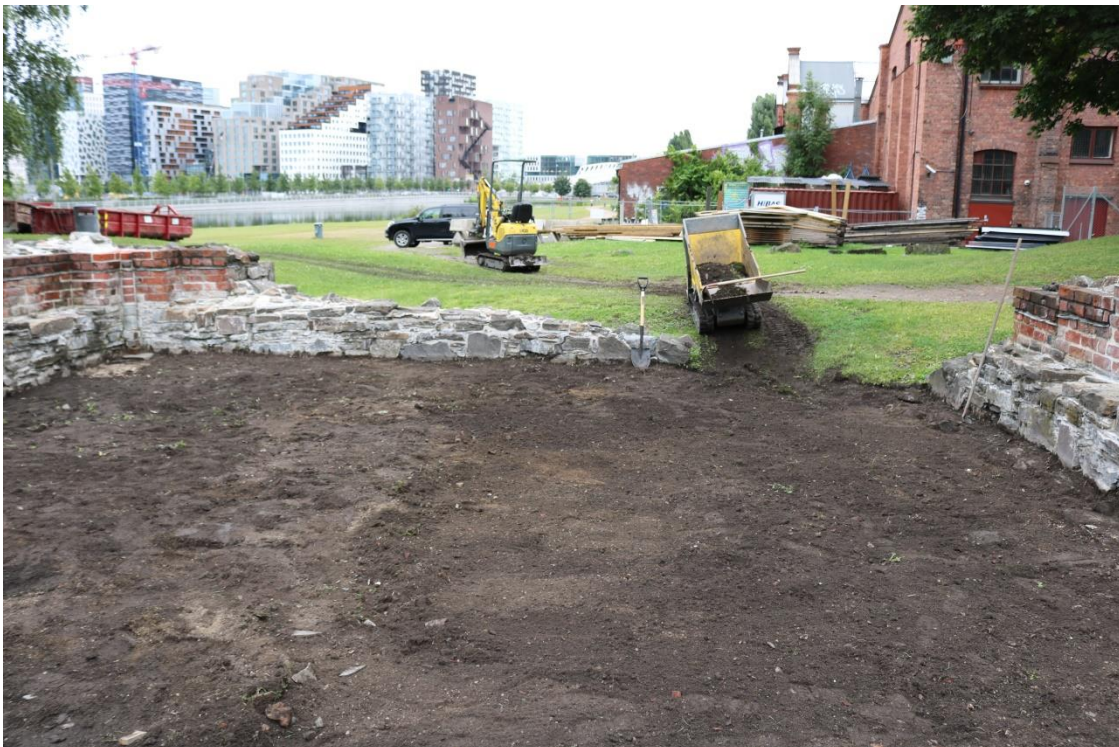
Figur 8: Nordre tverrskip etter avtorving med maskin. Foto: NIKU_0123.
