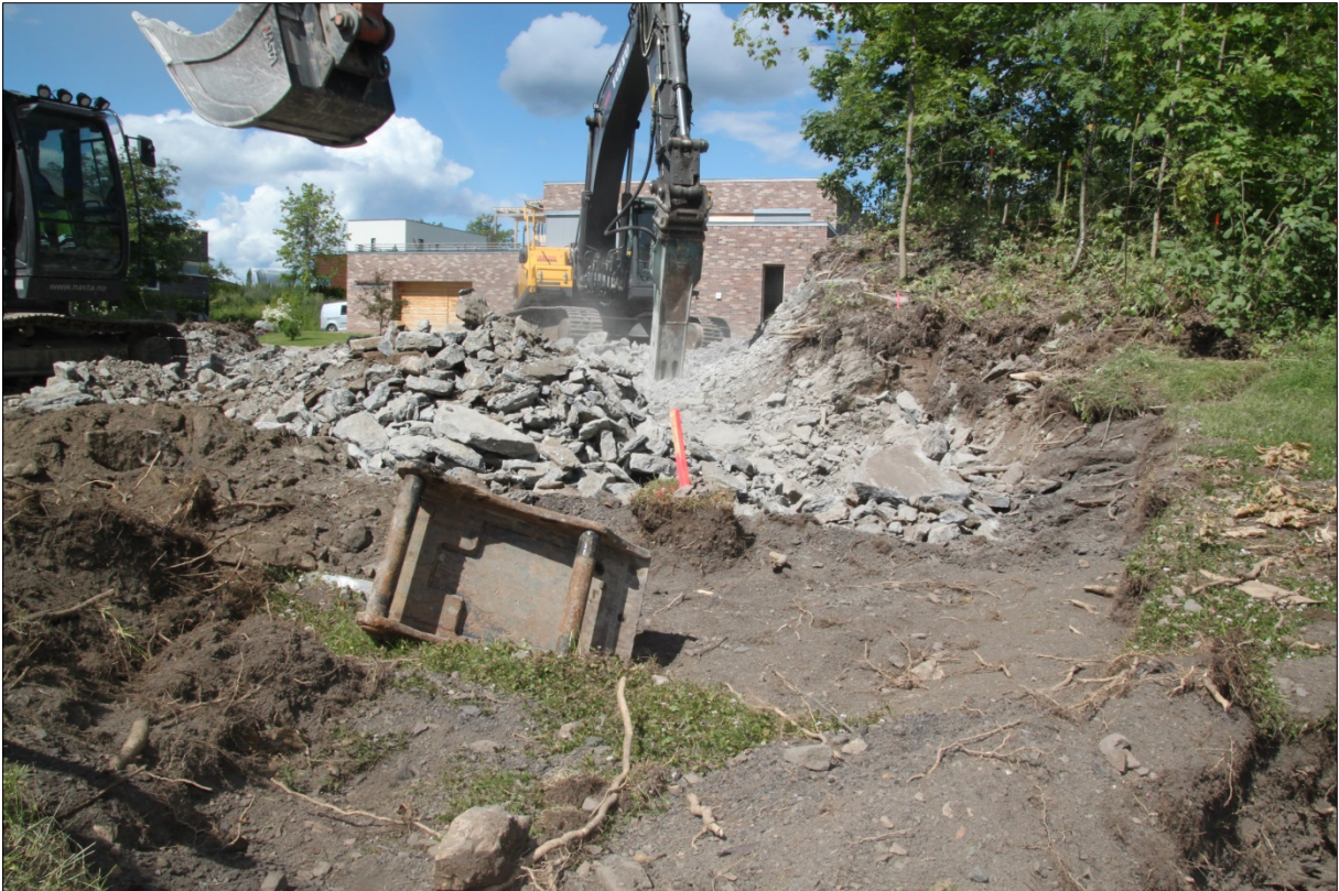
Figur 23 Piggning med maskin ved Sjakt 3, for fjerning av bergknausen i NØ-del av området (for nytt bolighus etc.). Nytt hus i Olav Myntmestersgate i bakgrunnen. Mot NV. Foto: NIKU Cf35137_0107.
