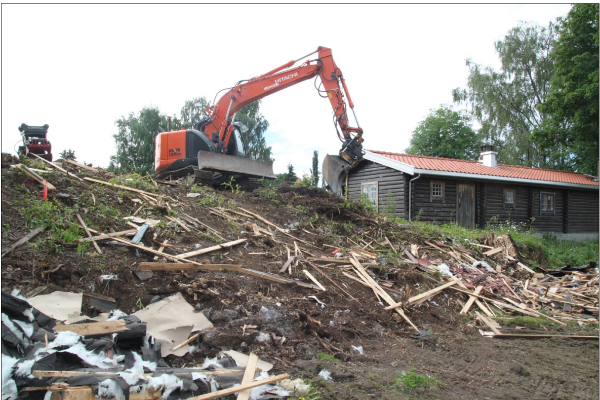
Figur 9 Graving til nytt bolighus på bergknausen igangsatt. Mot S-SV. Foto NIKU Cf35137_0009.
