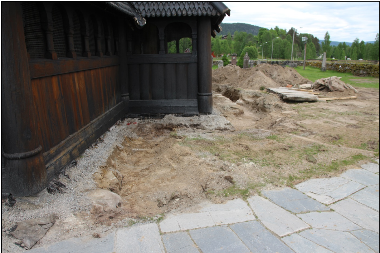
Figur 1. Sydvesthjørnet av stavkirken og deler av grøften på sørsiden, foto mot øst. Cf35130_NIKU_562877.
