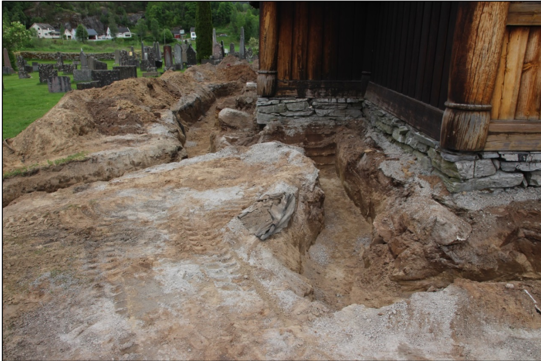
Figur 3. Nordvesthjørnet og nordportalen av stavkirken, foto mot øst. Cf35130_NIKU_562895.
