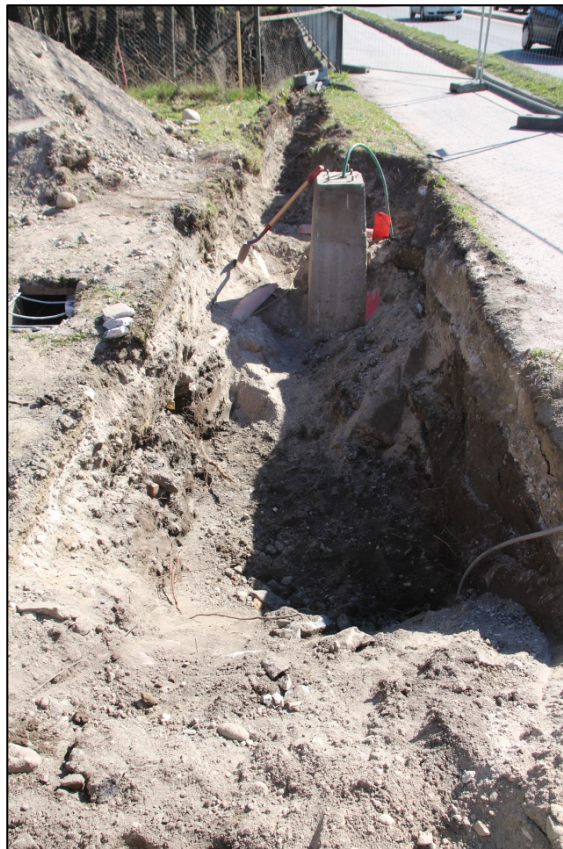
Figur 3. Sydlig halvportal. Sett mot syd. Cf35128_NIKU_561831.
