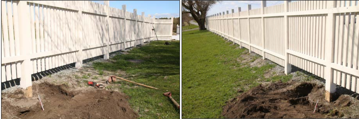
Fig. 9 Hull 3. Oversiktsbilder. Sett mot Ø og V. Da60264_032 og Da60264_033.
