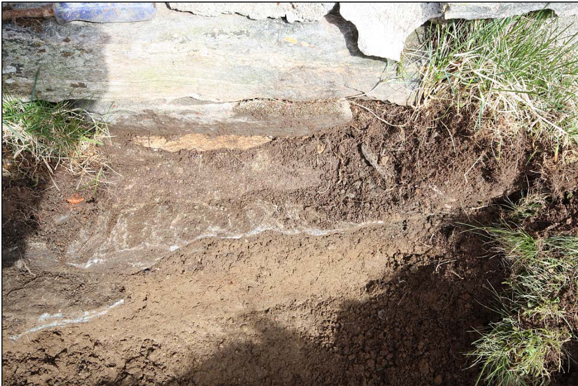
Figur 3. Fundamentstein og sokkelstein, med støp på. (Foto Bf_30006_NIKU_0003.tif: Dunlop, NIKU)
