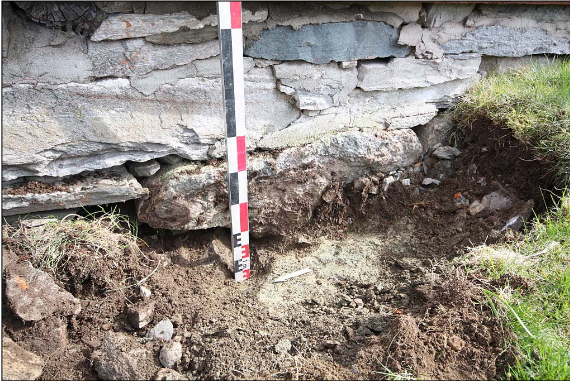
Figur 6. Det lyse leirelaget, forstyrret av de nederste fundamentsteinene. (Foto Bf_30006_NIKU_0016.tif: Dunlop, NIKU)
