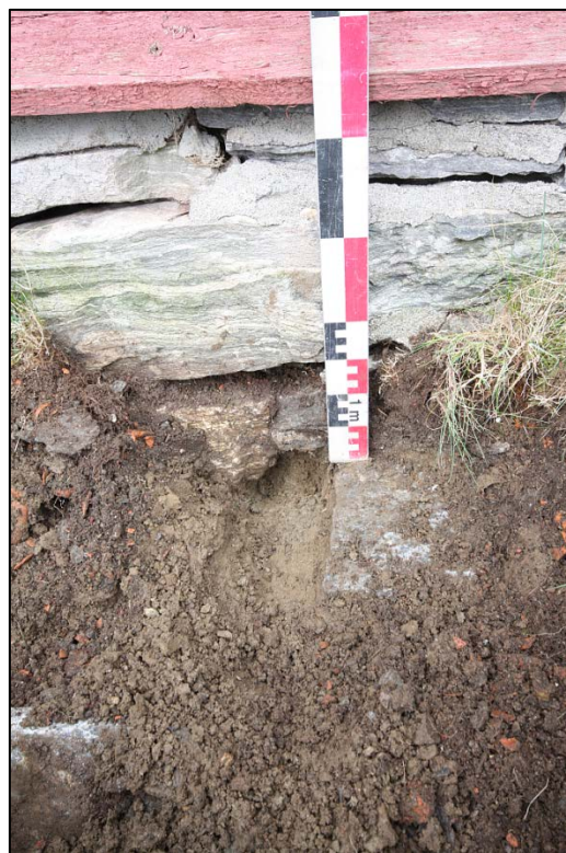
Figur 8. Noe avstand mellom fundamentsteiner. (Foto Bf_30006_NIKU_0023.tif: Dunlop, NIKU)
