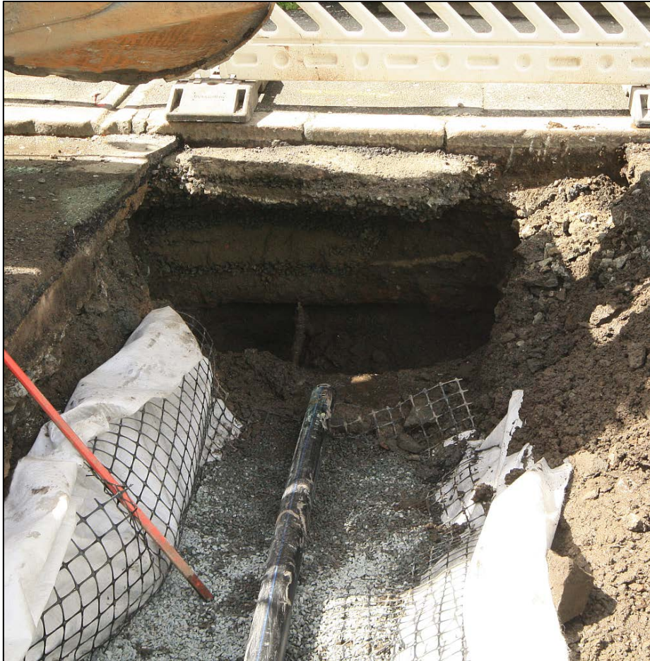
Figur 7. Grøften inn mot hovedvannledningen. (Bilde nr. Bf30010_NIKU_0037; Dunlop, NIKU)
