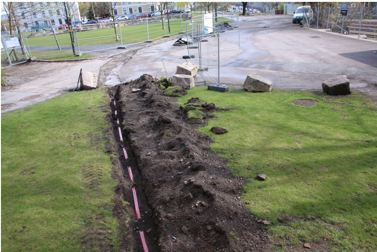
Figur 66: Oversiktsbilde over grøft for strøm under plenen ved Saxegården. Sett mot NØ. Foto-nr: Cf35149_NIKU_0667
