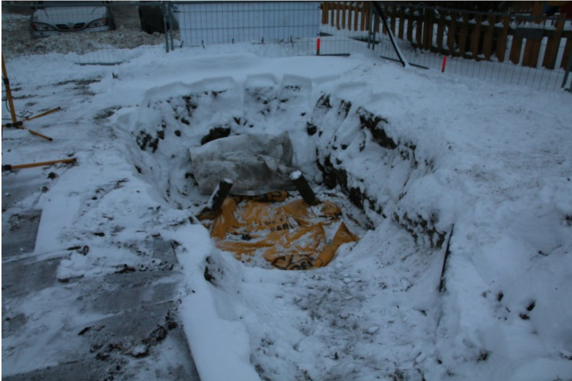
Figur 5: Brønn 2+3. Utfordringer ved utgravning vinterstid. Tidvis en del snø som måtte fjernes hver dag og ned mot 15 minusgrader gjorde arbeidet krevende. Sett mot Ø. Foto-nr: Cf35149_NIKU_0282
