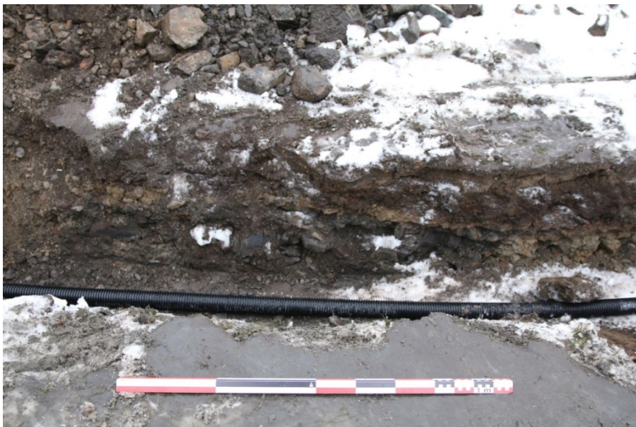
Figur 9: Brønn 2+3. Ferdig gravd grøft for vann. Sett mot S. Foto-nr: Cf35149_NIKU_0174
