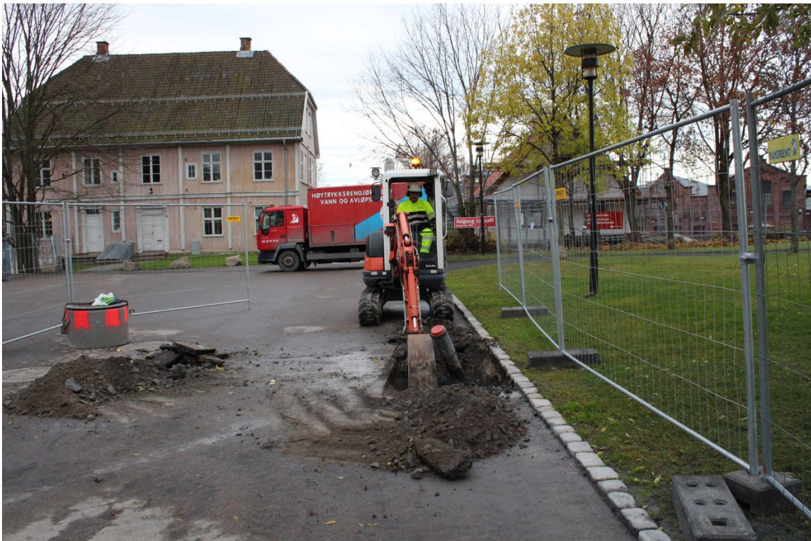
Figur 3: Brønn 5, graving av grøft for strøm. Sett mot V. Foto-nr: Cf35149_NIKU_0723
