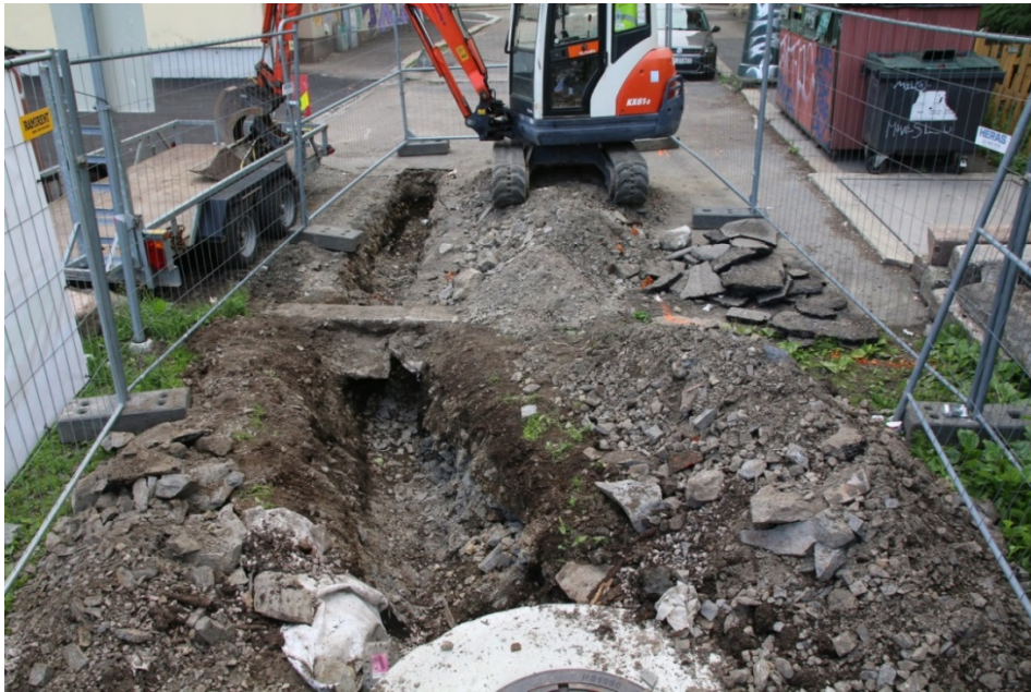
Figur 10: Brønn 2+3. Grøft for strøm, øst i Clemens gate. Sett mot Ø. Foto-nr: Cf35149_NIKU_0680
