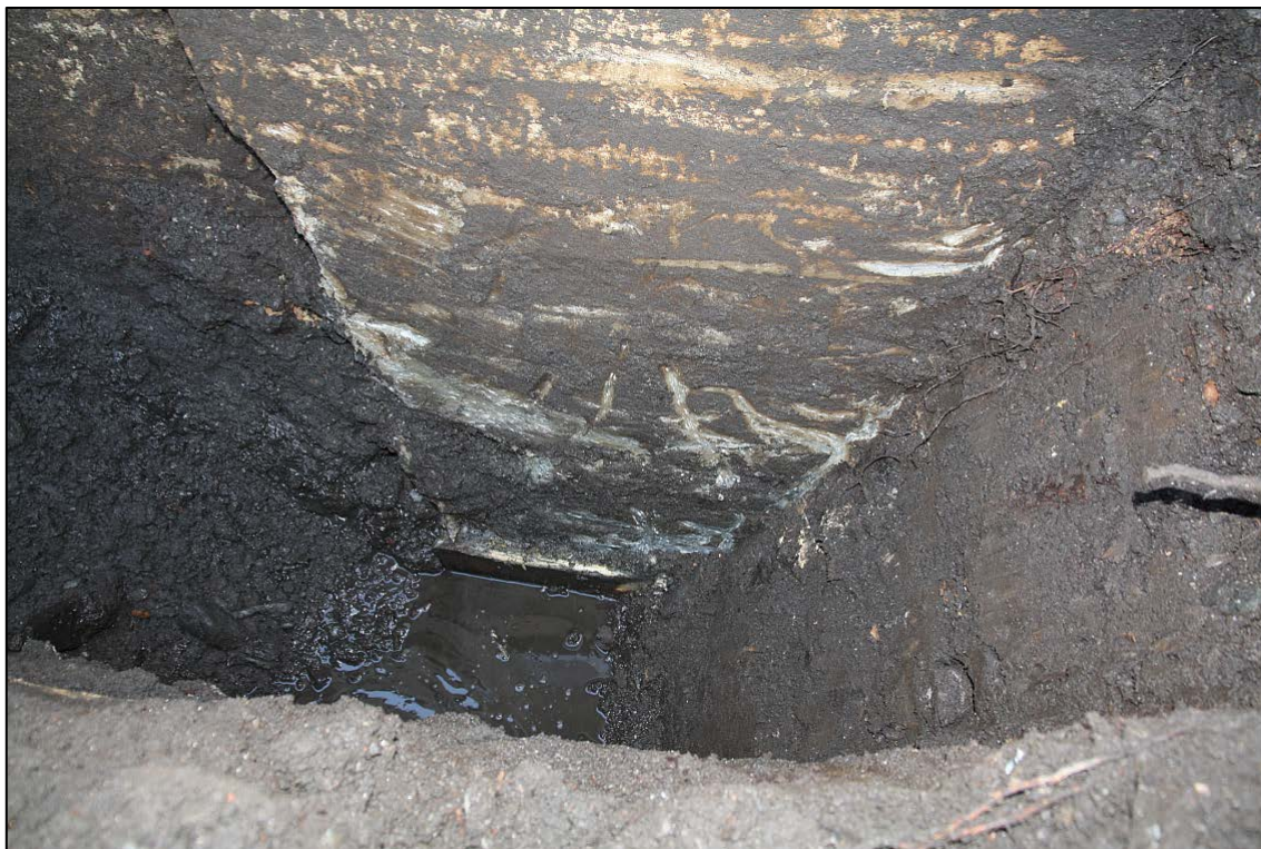
Figur 2. Vannsig i bunnen av prøvehull 1, samt bunnplanken i treforskalingen. (Foto: Hobæk, NIKU)
