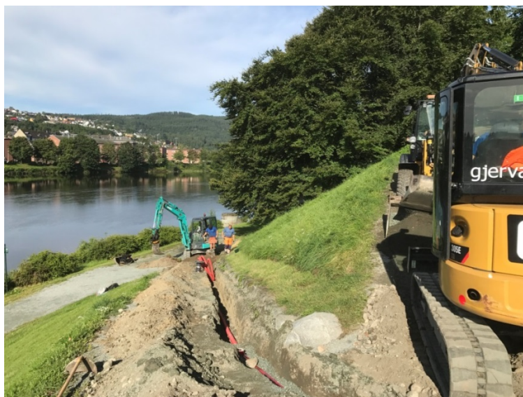
Figur 9: Oversikt sjakt mellom lysmastgrop 3 og 4, mot vest.
