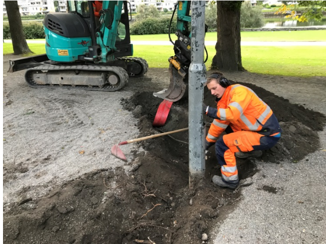
Figur 58: Utskifting av lysstolpe på lekeklassen, mot sør.
