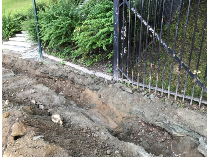
Figur 31: Vestre port med grop/grøft 62, mot NV.
