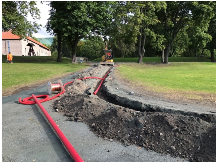
Figur 59: Oversikt mot lysmastgrop 30, mot nord.
