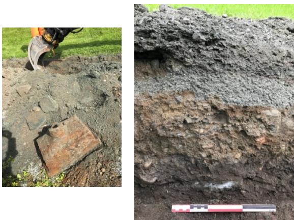
Figur 14: Støpejernssluk (venstre) og profil 10, mot nord (høyre).
