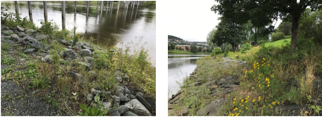
Figur 24: Flomvern ved Nidelven, mot øst (venstre) og mot vest (høyre).
