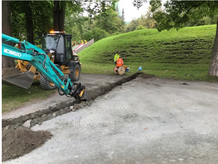
Figur 72: Oversikt sjakt mot lysmastgrop 27, mot nord.
