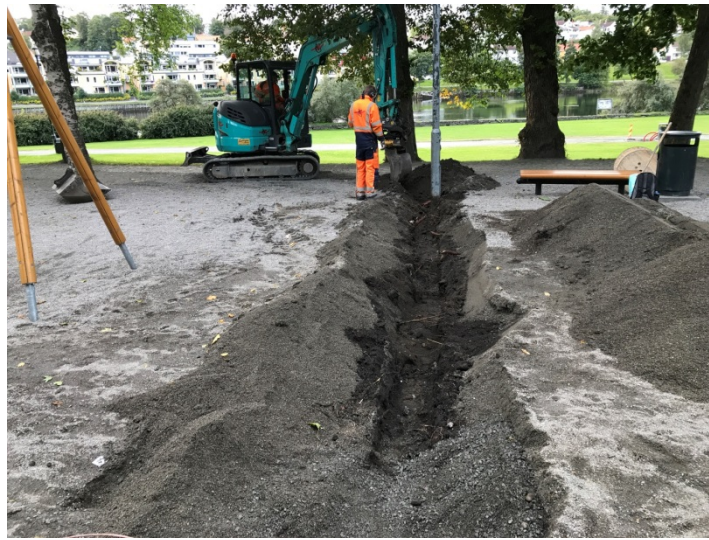
Figur 57: Oversikt ny sjakt på lekeplass, mot sør.
