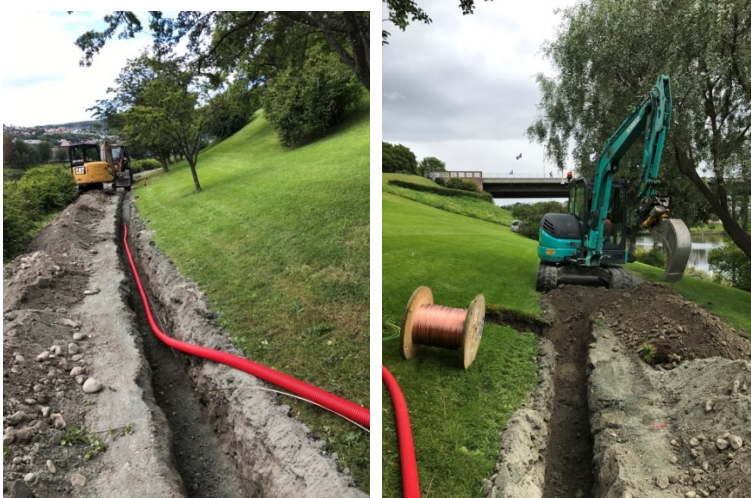
Figur 18: Oversikt sjakt fra lysmastgrop 9 mot 8 (venstre) og fra 8 mot 9 (høyre).
