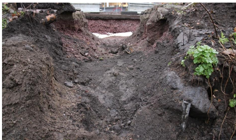
Figur 7 Innstikksgrøft sett mot Ø. Etterreformatorisk lag SL1118 i bunn av grøften midt i bildet. Stein TS1132 til høyre i bildet.
