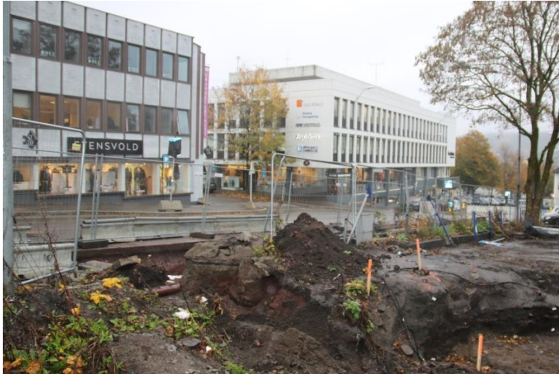
Figur 83 Oversiktsbilde mot SØ. Foto viser innstikkgrøft mellom hovedgrøft (t.v) og Anders Madsens gate 3 (t.h.)
