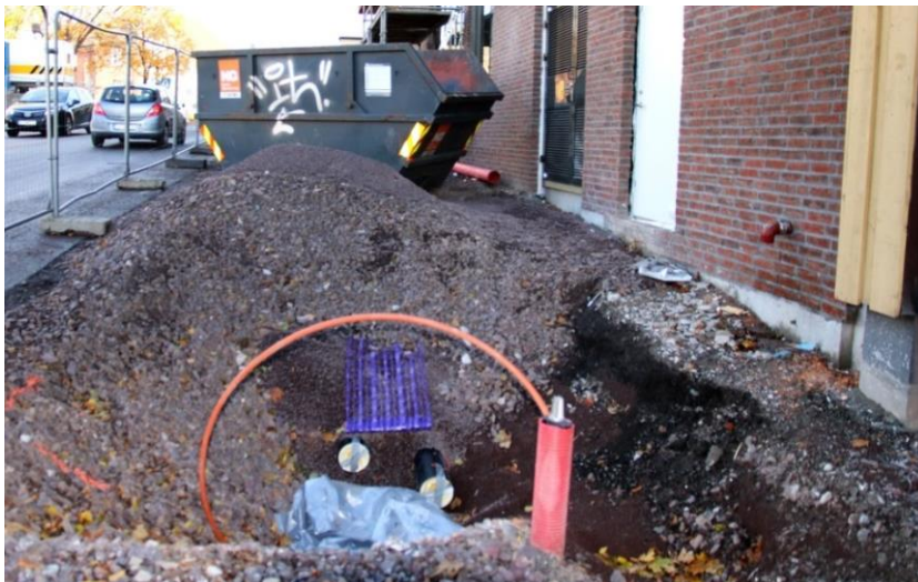
Figur 11 Etterkontroll av grøft gravd for flytting av trasè utenfor Baglergaten 2, sett mot N.
