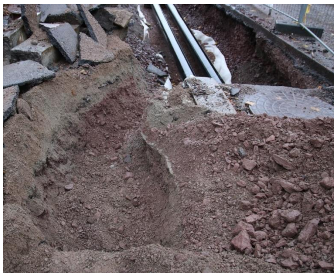
Figur 2 Grøft til fiberkum, sett mot NØ.
