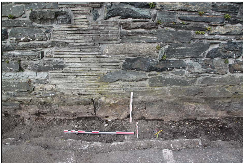
Figur 4. Det reparerte partiet i den sørlige delen av den gamle muren. Foto: Dunlop, NIKU (bildenr. Bf30023_NIKU_0009).
