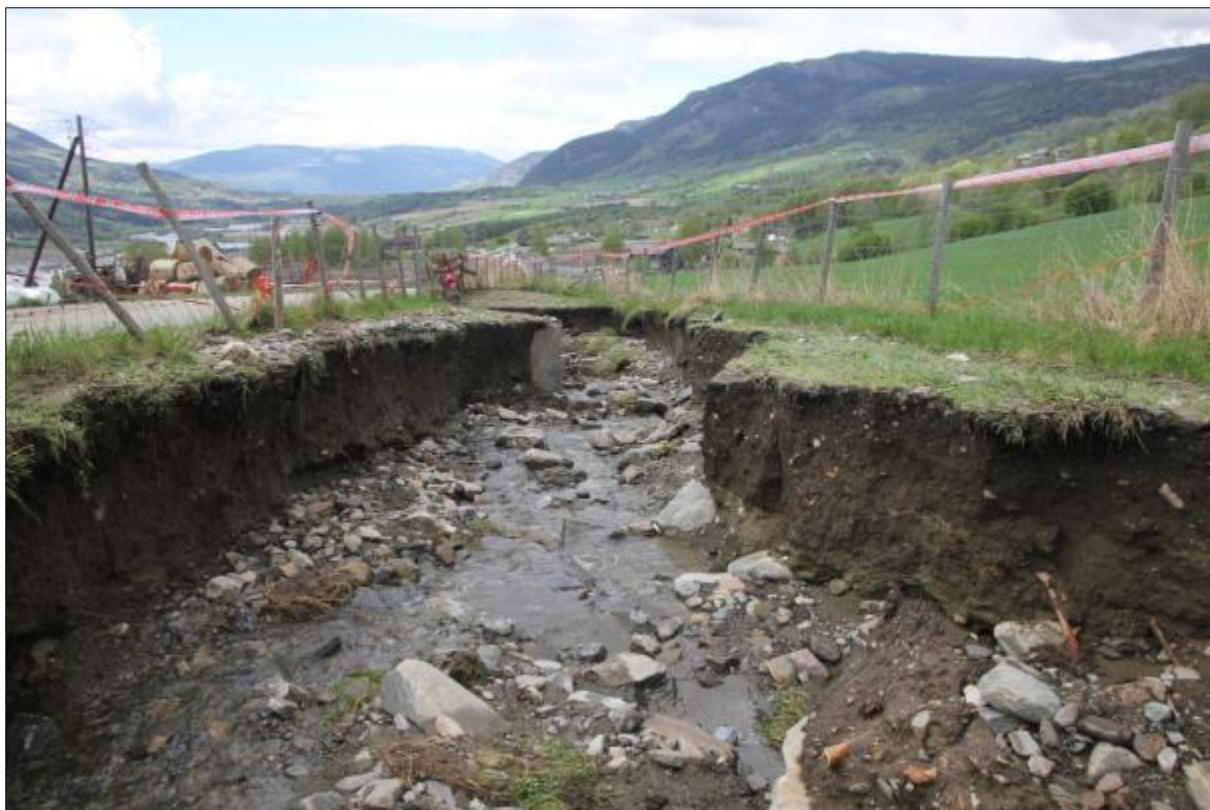
Figur 4. Flomrevnen med vannføring. Foto tatt under befaring 24.5.2013. En mulig gravstein (kontekst 110) ses stående i grøfteveggen midt i bildet. Foto: niku_ark_340205.jpg.
